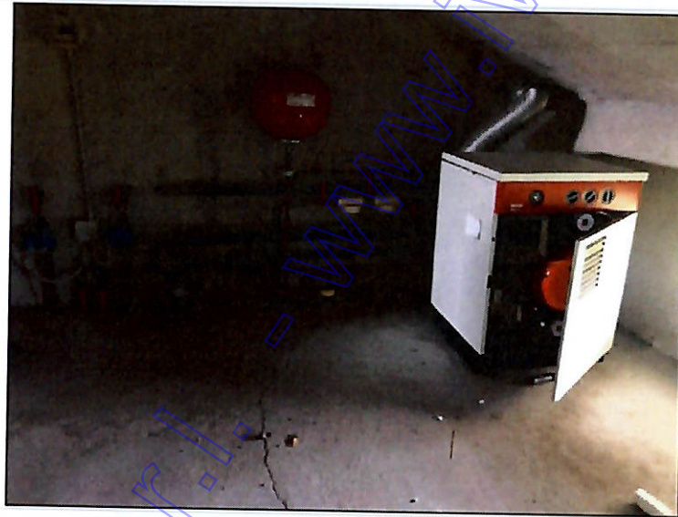
20. Fotografia interno locale soffitta con c. t.
