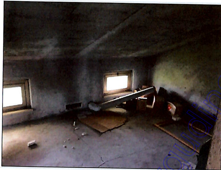
19. Fotografia interno locale soffitta
