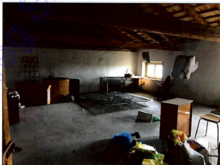
18. Fotografia interno locale soffitta
