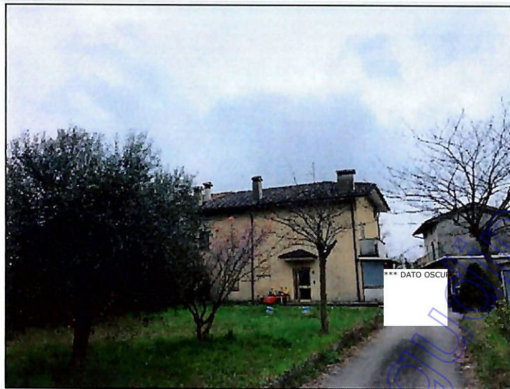
4. Fotografia esterno da via Dei Rimini
