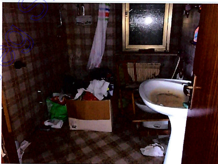
15. Fotografia interno locale bagno
