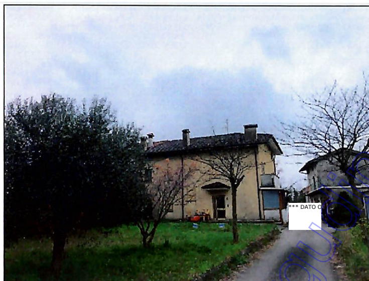
4. Fotografia esterno da via Dei Rimini
