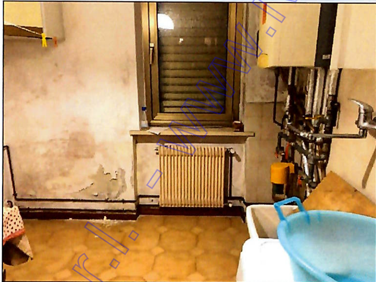
20. Fotografia interno locale ripostiglio e c. t.
