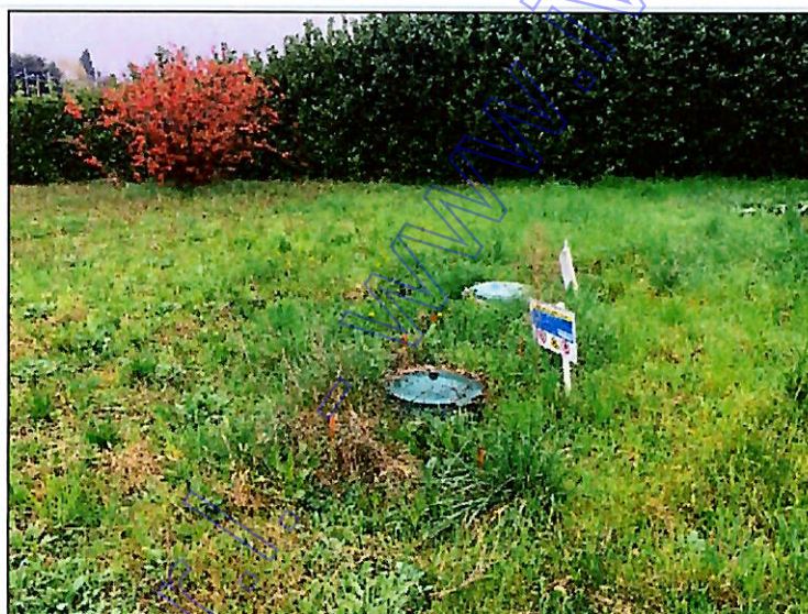
5. Fotografia area esterna mappale 319 con serbatoi GPL
