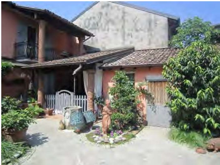
VISTA PORTICO (1) E LOCALE SGOMBERO (1)
