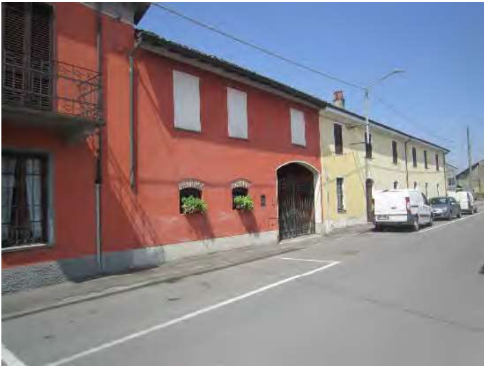
VISTA FRONTE EST
