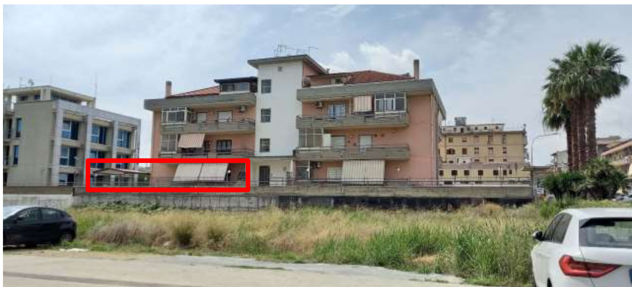
Foto 3 – Immobile “1A” – Prospetto Nord
