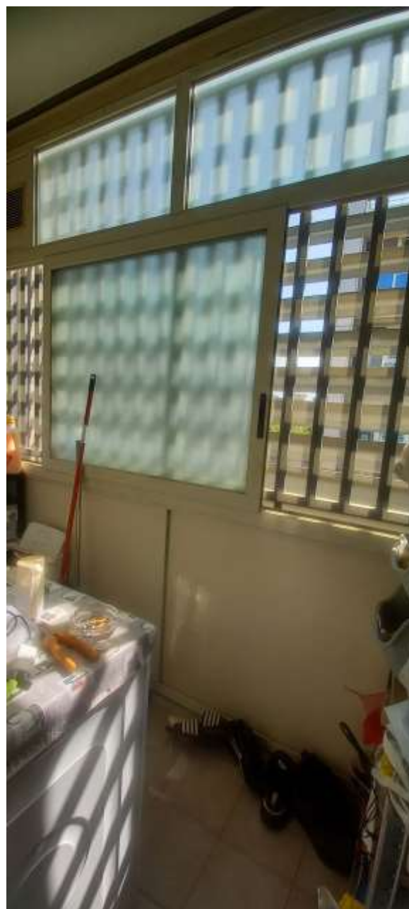
Foto 13 – Immobile “1A” – Lavanderia
