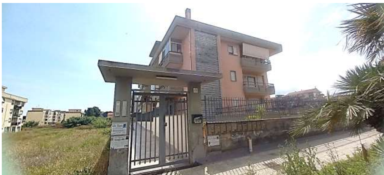
Foto 6 – Immobile “1A” – Ingresso condominiale su viale R. da Lentini
