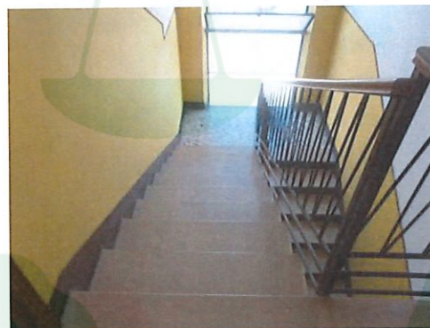
Vano scala comune
