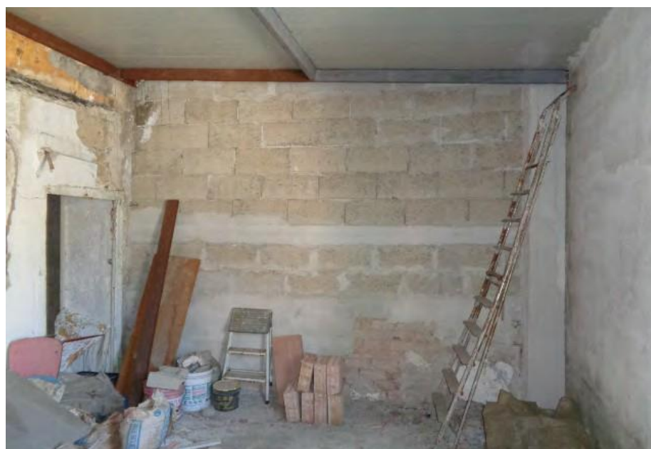
FOTO 12 Appartamento al P.2° SUB 26: Camera n°2 (ampliamento su preesistente terrazzo)
