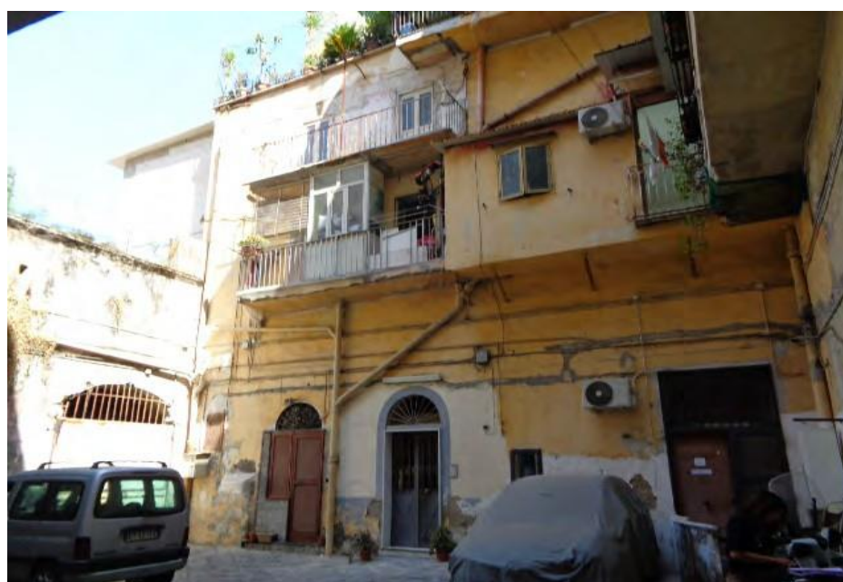
FOTO 4 Prospetto del fabbricato su corte interna: portoncino d'accesso al fabbricato
