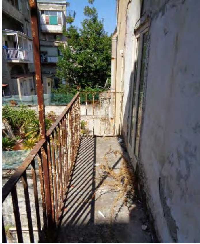
FOTO 13 Appartamento al P.2° SUB 26: Balcone su corte interna
