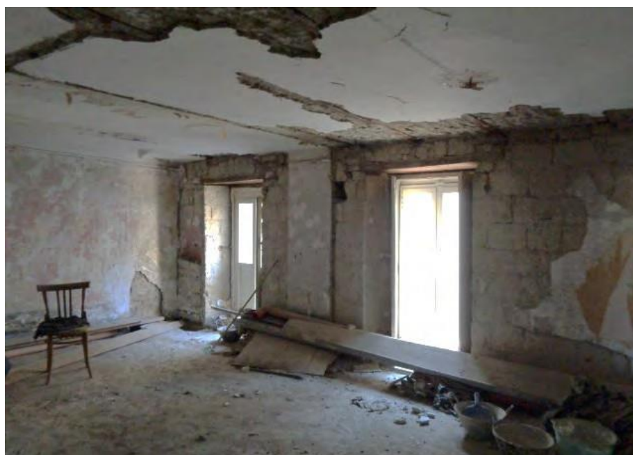
FOTO 8 Appartamento al P.2° SUB 26: Camera n°1
