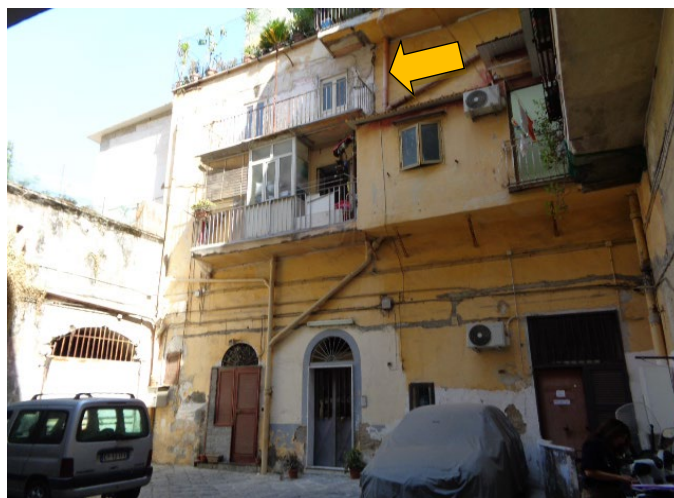
Corte interna del fabbricato – Particolare dell'affaccio dell'u.i. SUB 26 al P.2°
