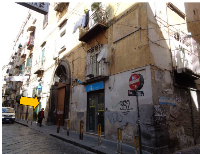
Veduta esterna del fabbricato da Via Materdei
