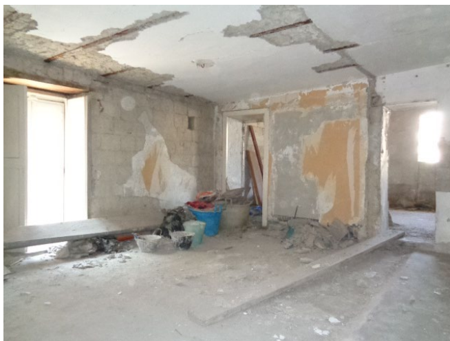
Particolare della camera n°1
