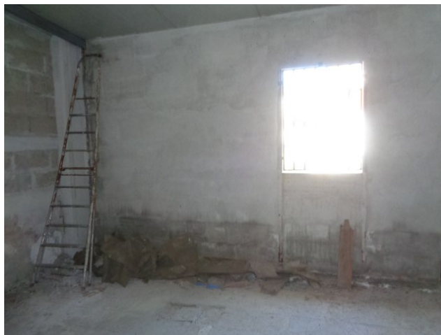
Particolare della camera n°2 (realizzata su preesistente terrazzino)
