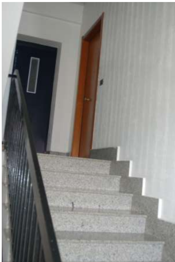
corpo scala condominiale
