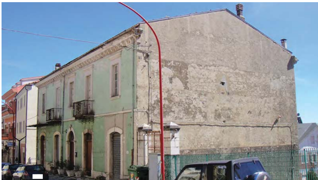
Figura 3: Prospetto prospiciente via Filangieri
