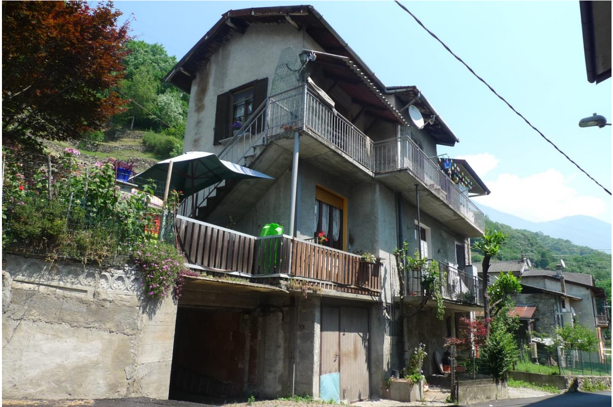
Vista esterna lato sud-ovest
