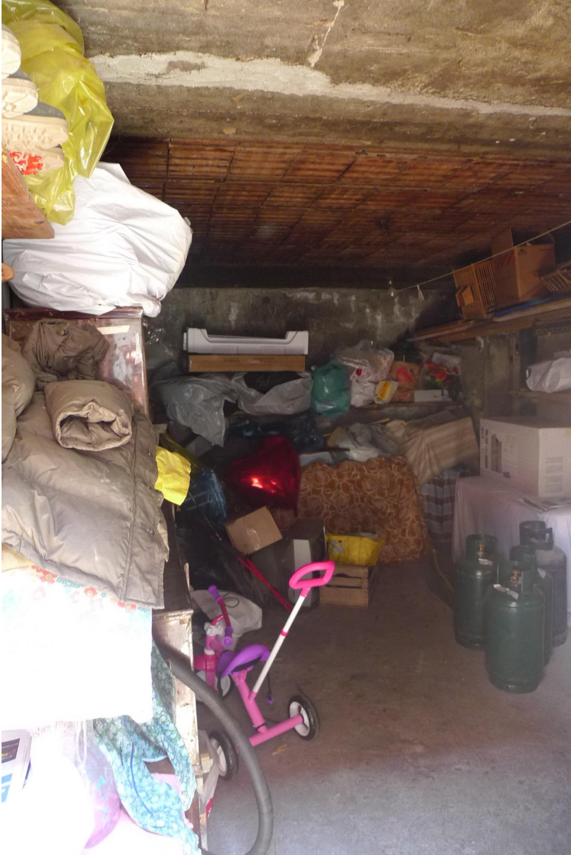
Ripostiglio piano terra
