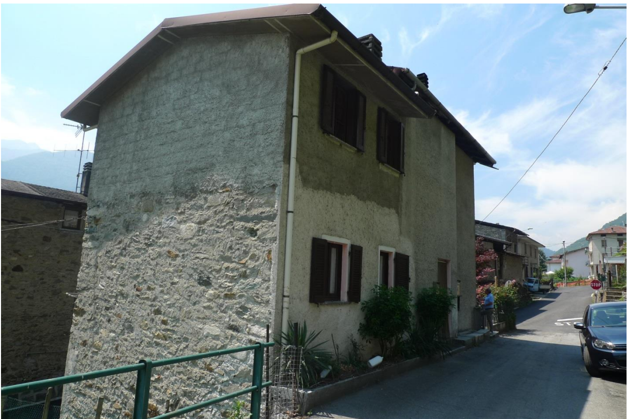
Vista esterna lato nord-est
