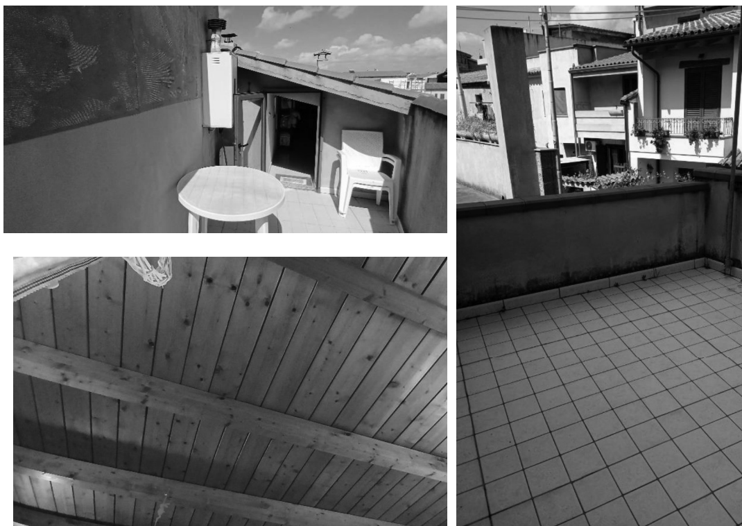
FOTO 26 - 28 – Nell'ordine da sinistra in alto: 26) Terrazzino esterno a cui si accede dal piano sotto-tetto; 27) Particolare del terrazzino collegato alla camera matrimoniale; 28) Particolare della controsoffittatura in impalcato ligneo, presente nei piani terra e secondo.
