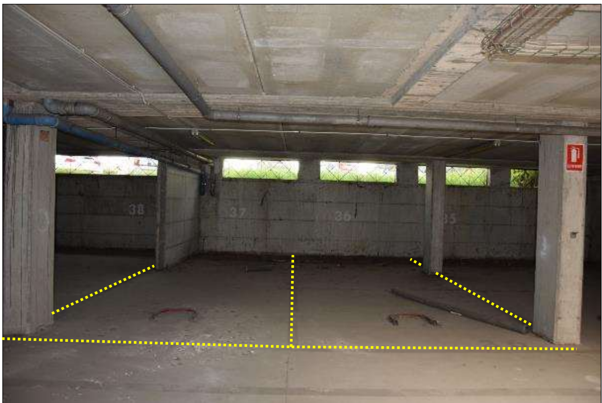
FOTO 2 – SUB 113 (POSTO 37) – SUB 114 (POSTO 36)
