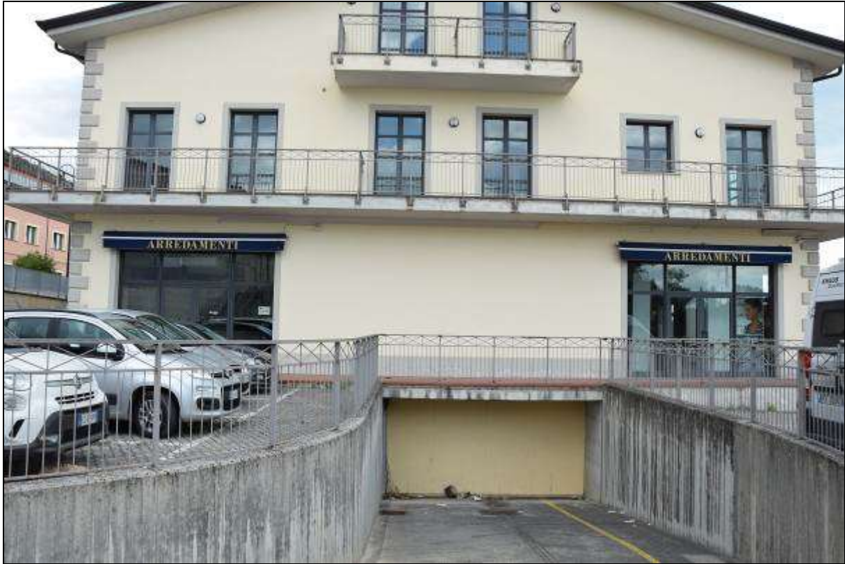
FOTO 13 - ingresso garage interrato chiuso per motivi di sicurezza
