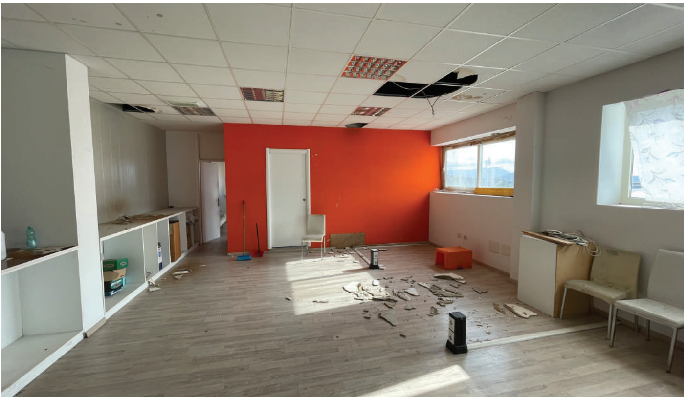
FOTO 18 - Vista interna del piano secondo nella zona uffici;
