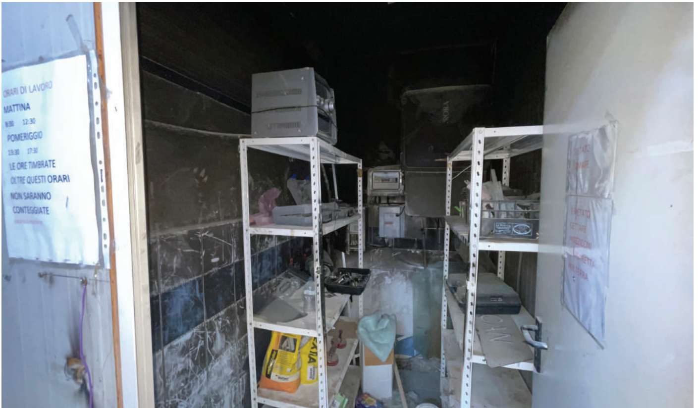
FOTO 10 - Vista interna del ripostiglio al piano primo;
