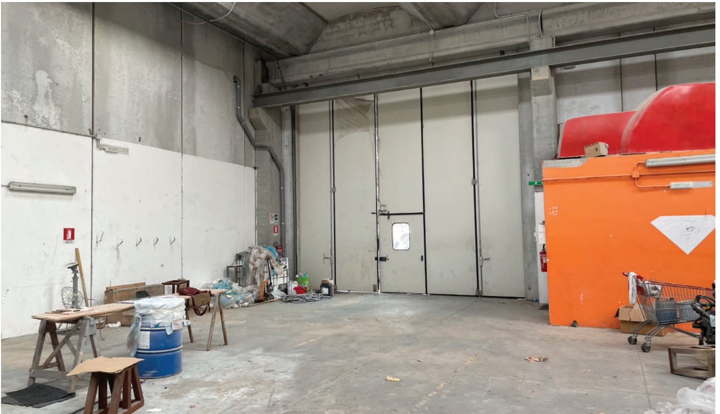
FOTO 5 - Vista interna dell'edificio al piano primo nell'area di rimessaggio;
