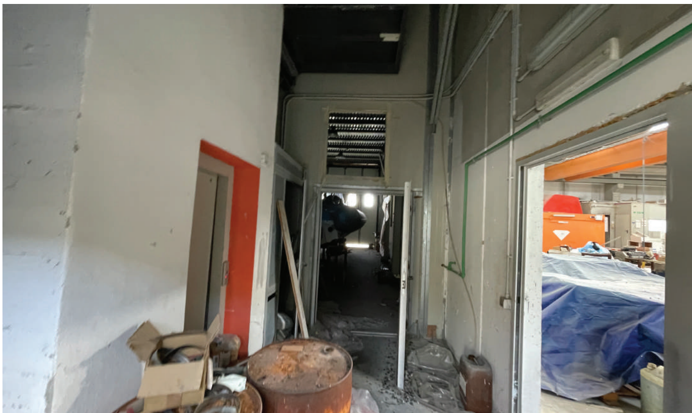
FOTO 13 - Vista interna dell'ascensore e area di rimessaggio;
