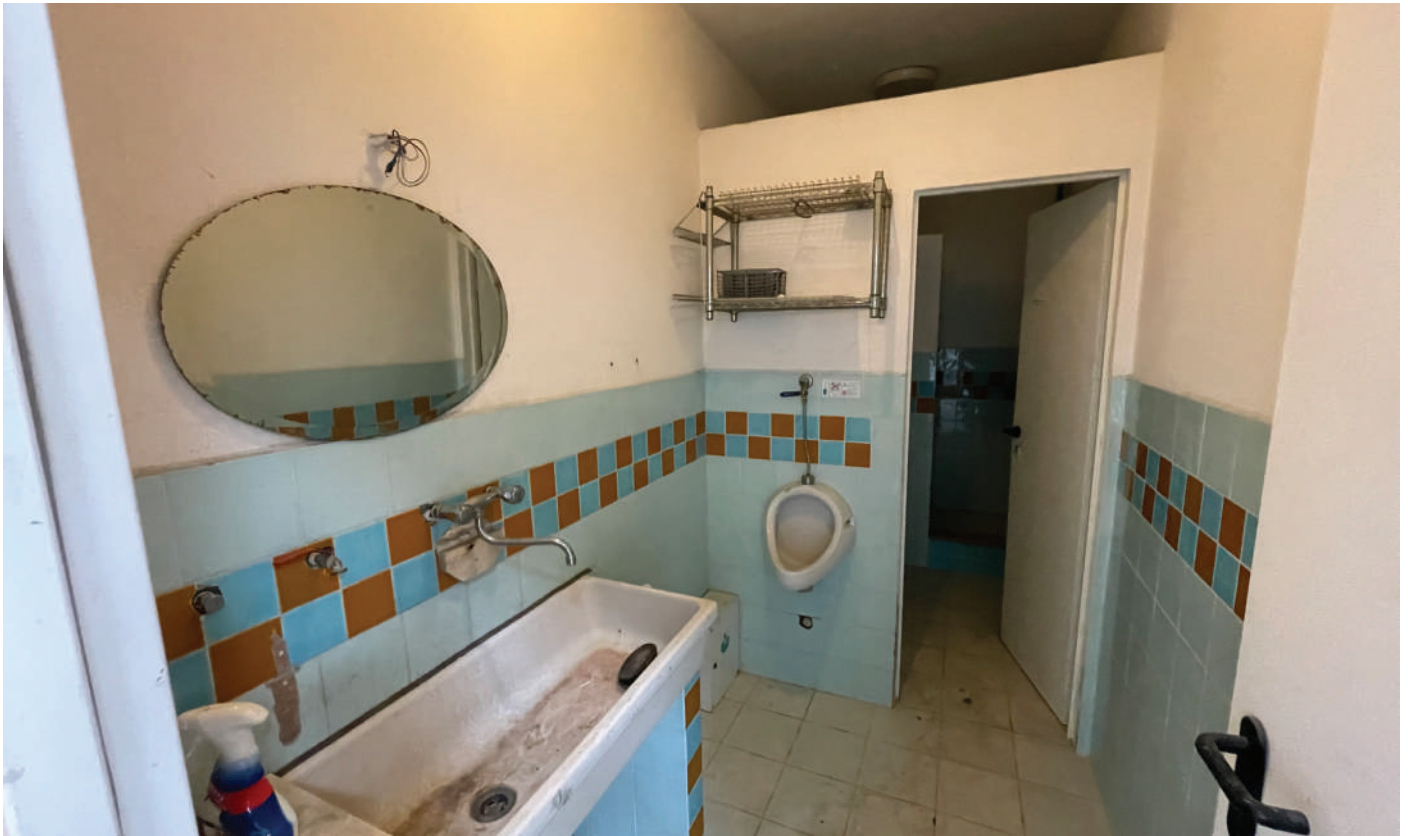
FOTO 9 - Vista interna dei servizi igienici al piano primo;
