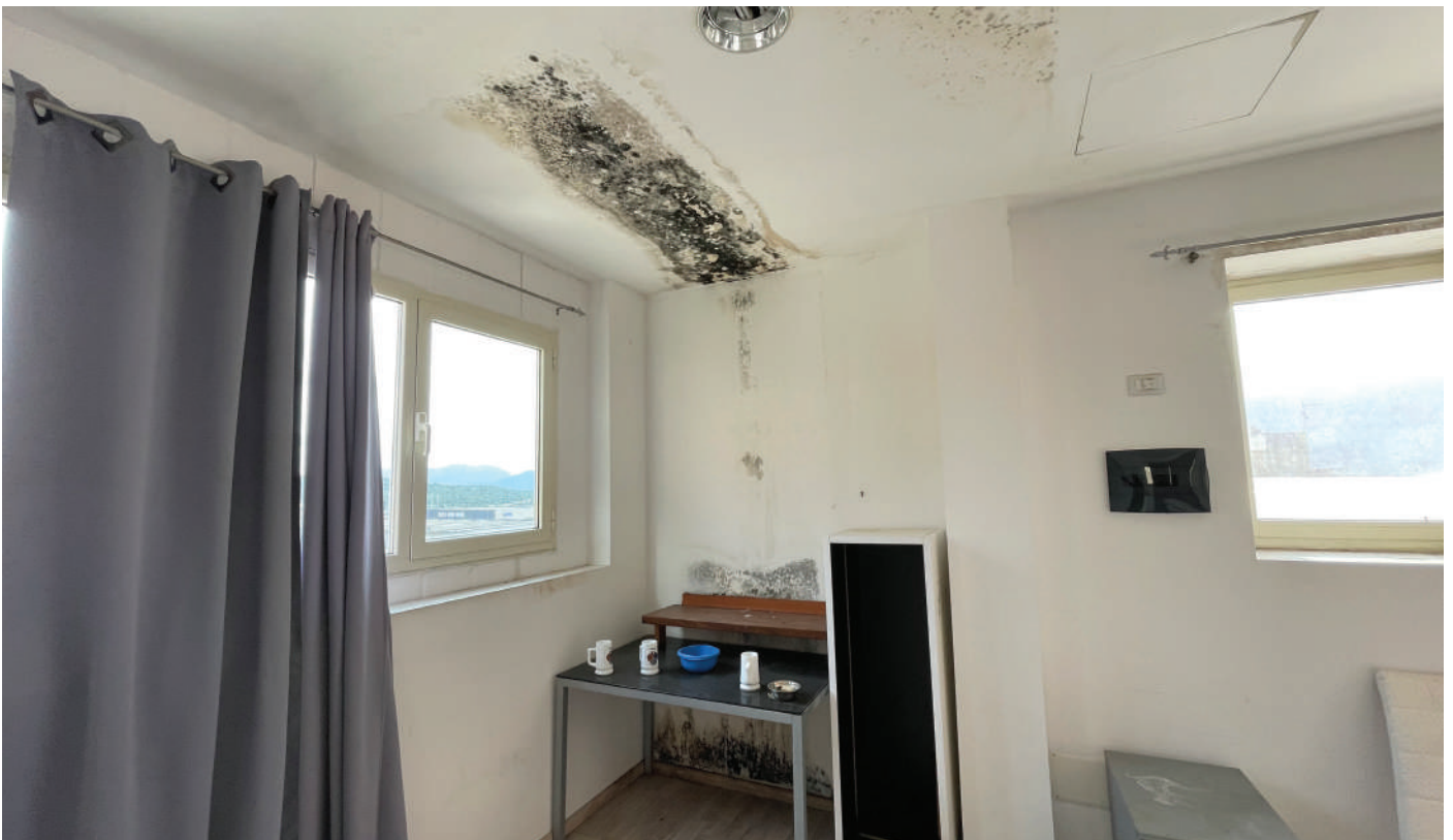
FOTO 20 - Vista interna del piano secondo nella zona foresteria;
