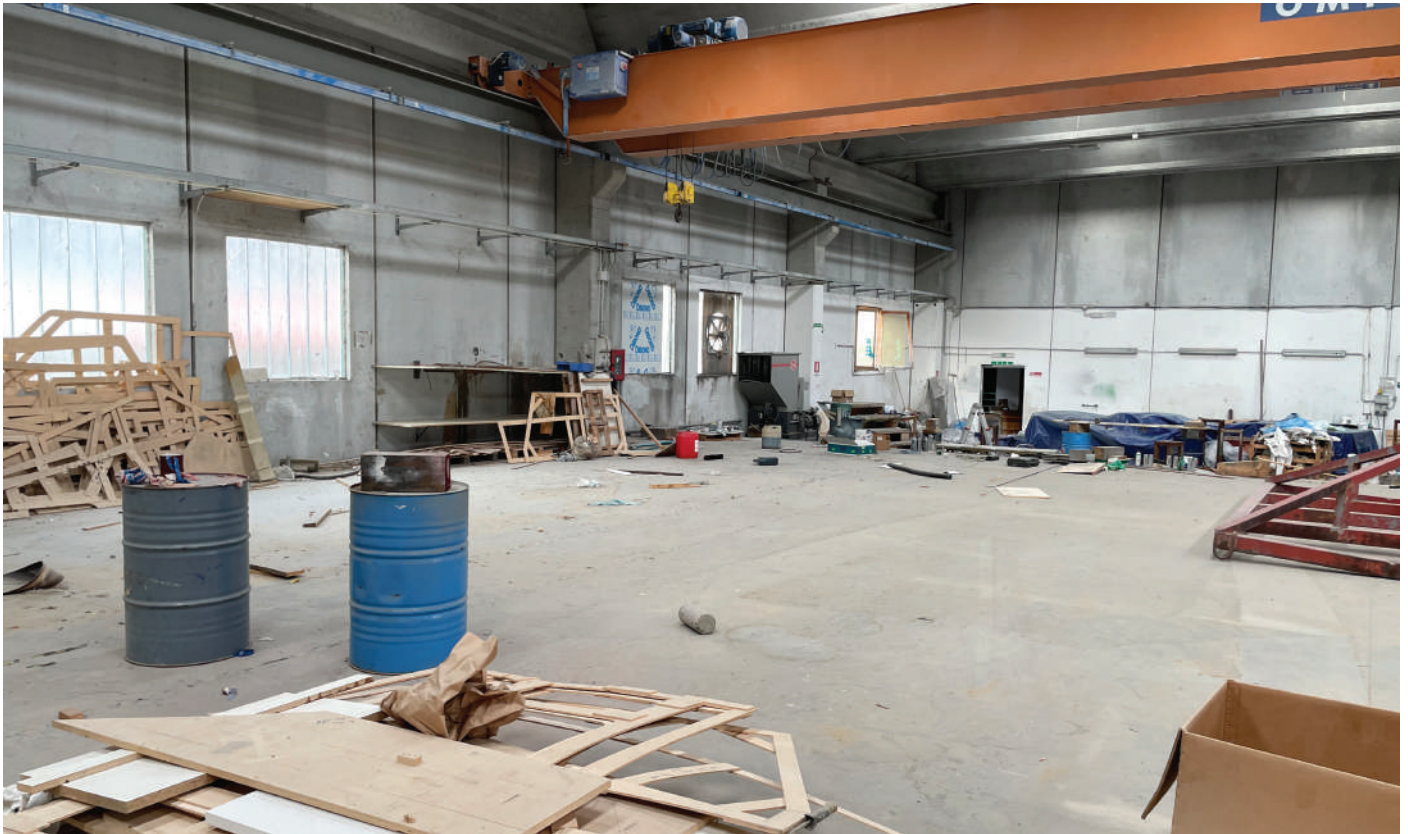
FOTO 7 - Vista interna del piano primo nell'area di rimessaggio;
