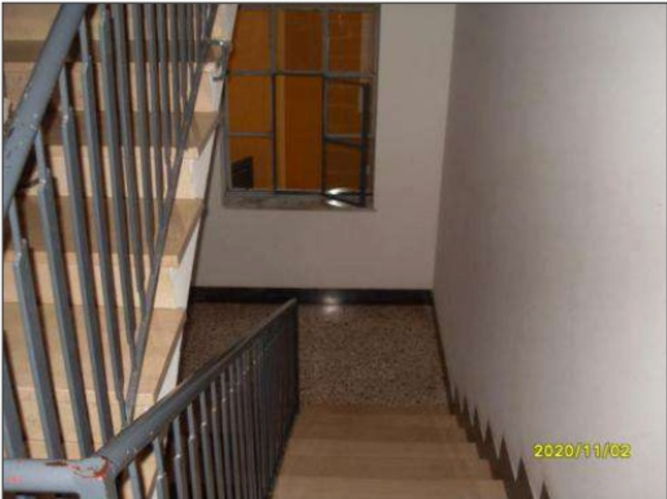
Foto 1. Particolare vano scala di accesso alle abitazioni
