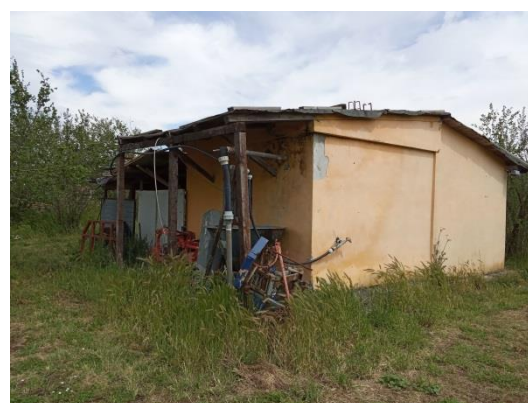
Locale pozzo con deposito
