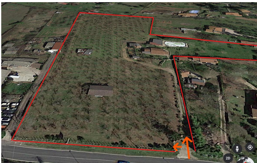
Vista del compendio immobiliare e degli accessi da Via Cassia Cimina
