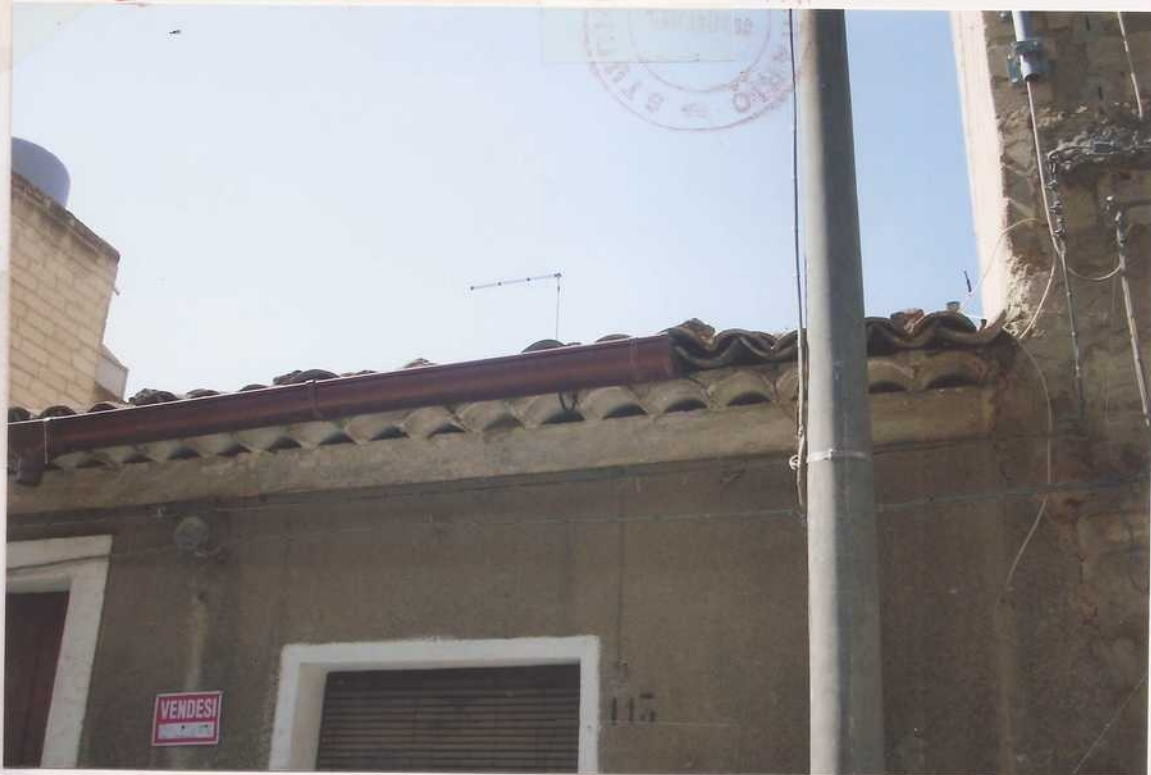
Area libera del fabbricato
