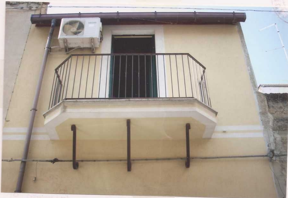
Primo piano della stabile - Via Umberto 161 -
