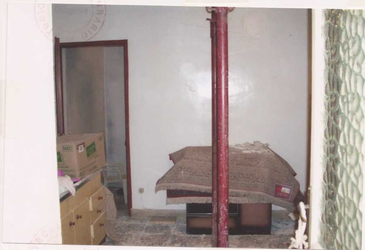
Interno del fabbricato
