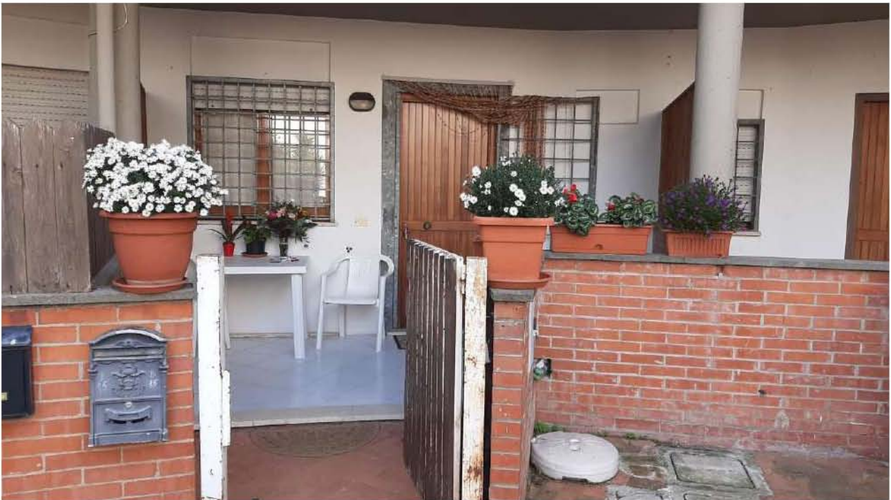
Foto n. 2 – Esterno dell'immobile – accesso pedonale
