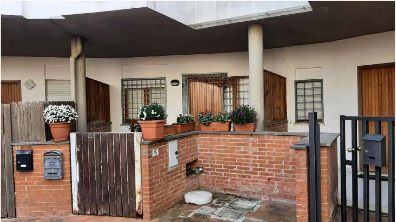
Foto n. 1 – Esterno dell'immobile – accesso pedonale
