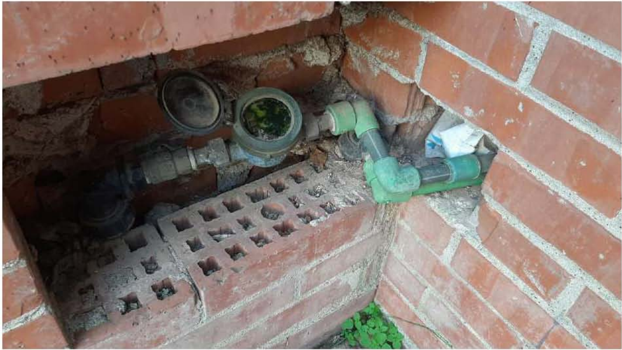
Foto n. 45 – Contatore acqua
