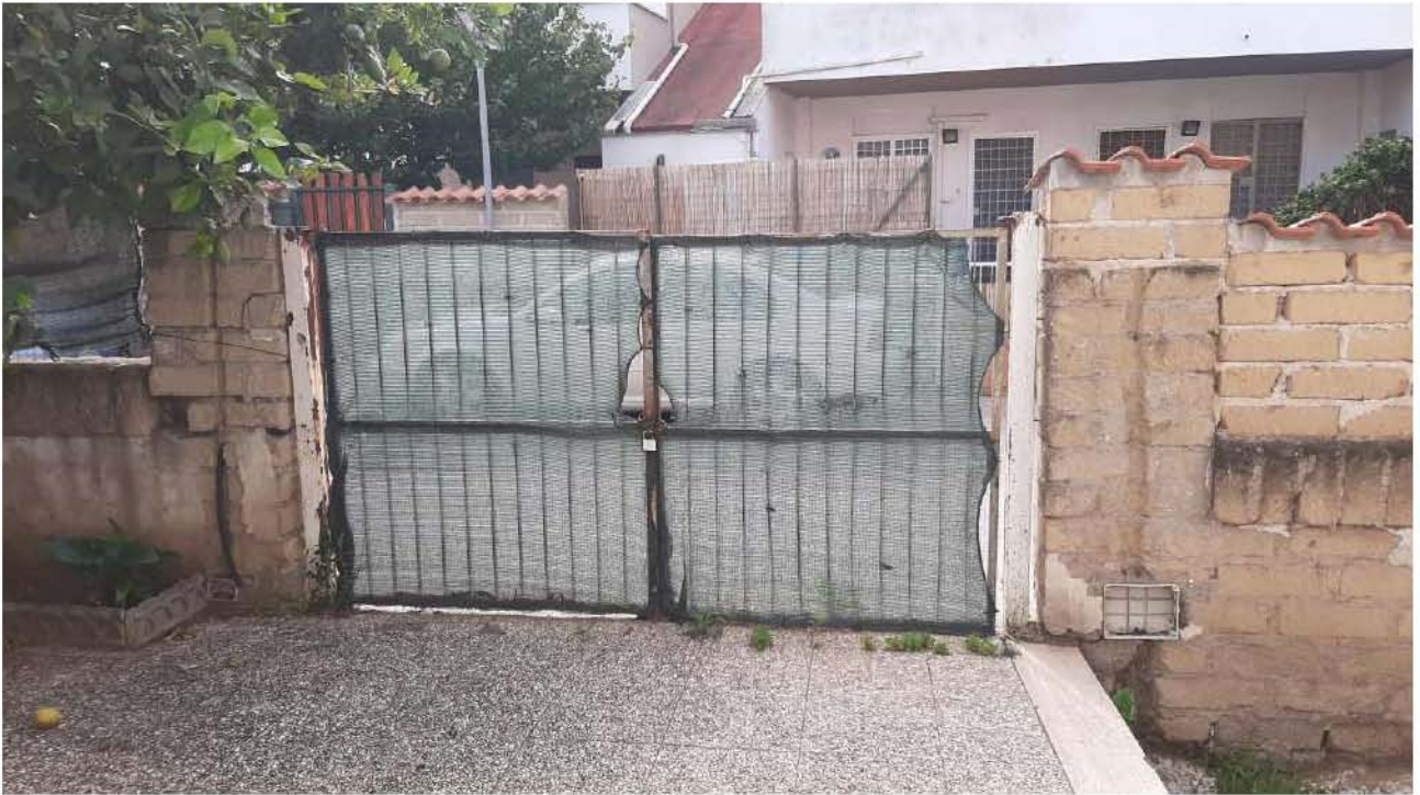
Foto n. 15 – Appartamento – piano seminterrato – accesso carrabile
