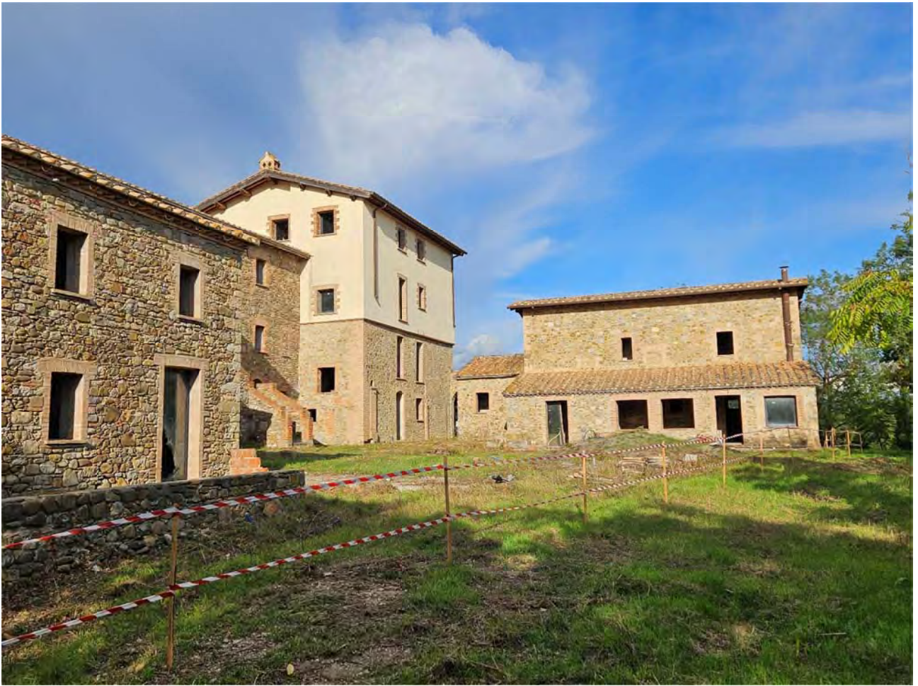
Vista fabbricato principale e secondario lato corte interna (sud-est)
