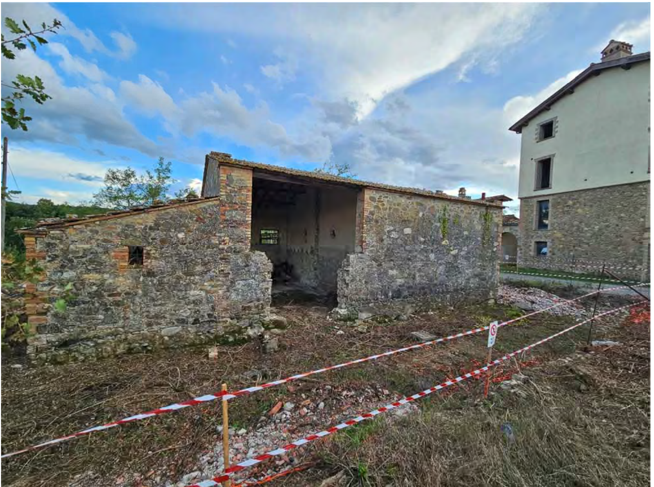
Vista esterna lato est
