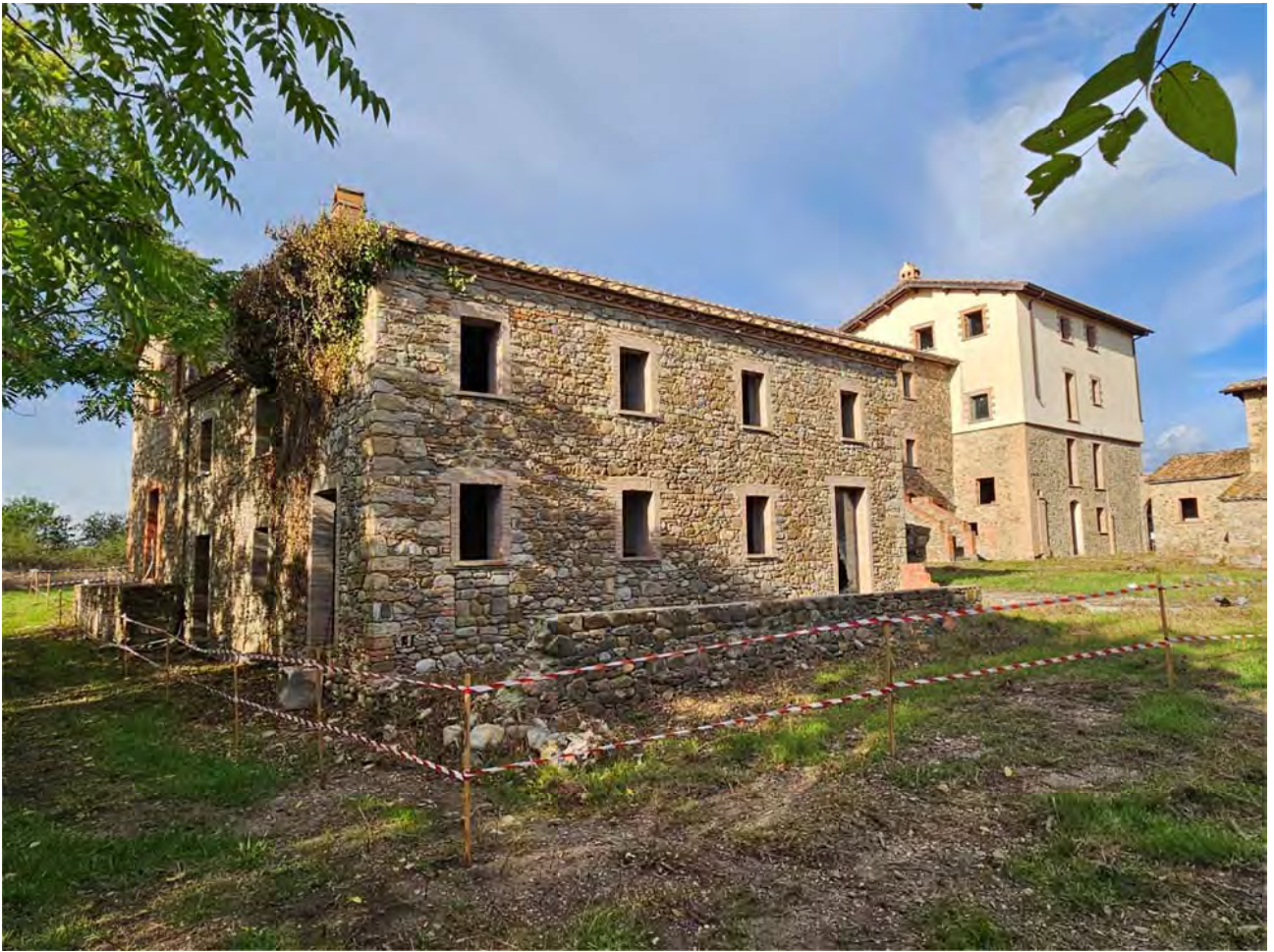
Vista fabbricato principale lato corte interna (sud)
