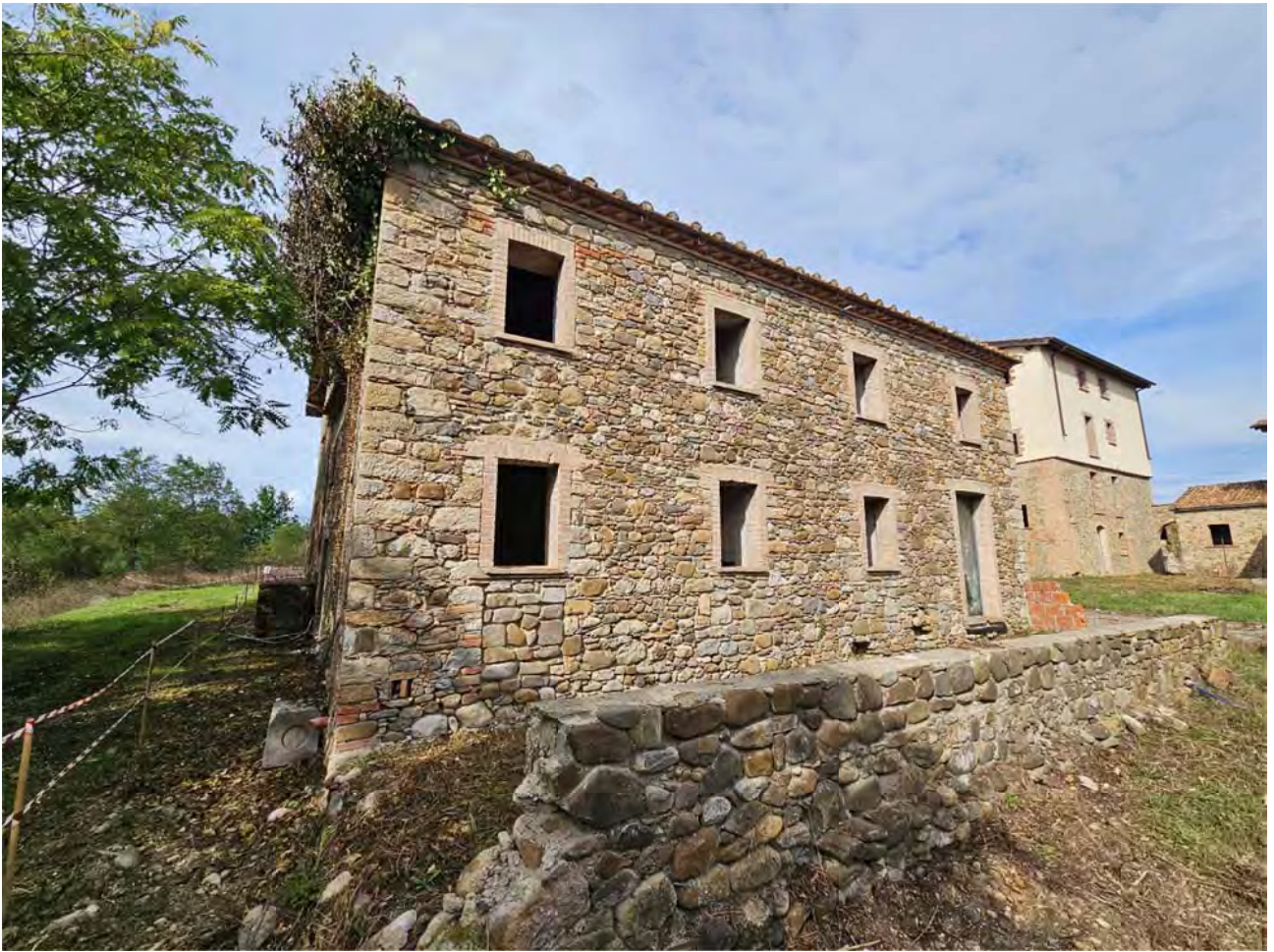
Vista fabbricato principale lato corte interna (sud)
