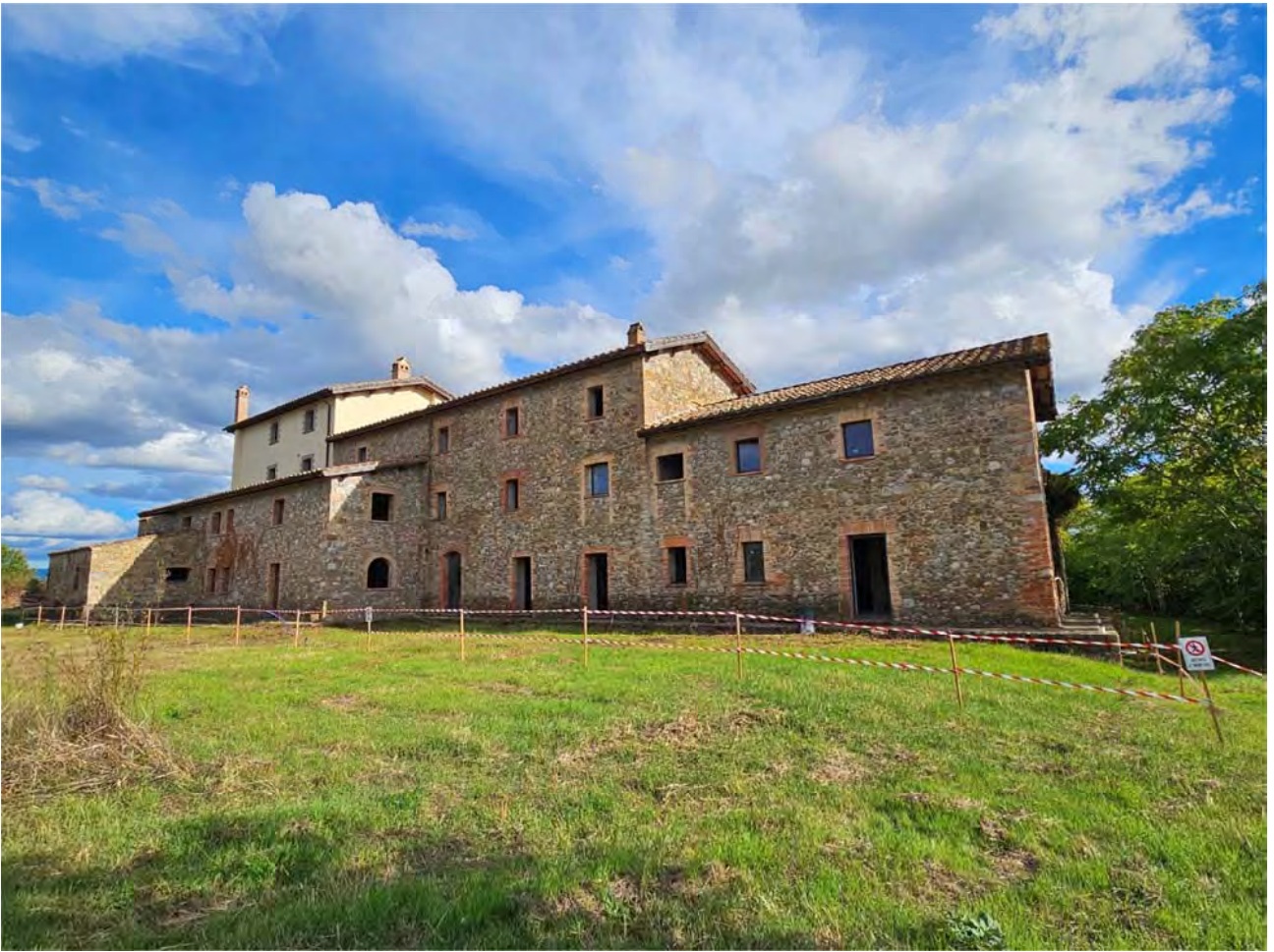
Vista fabbricato principale lato giardini (nord)
