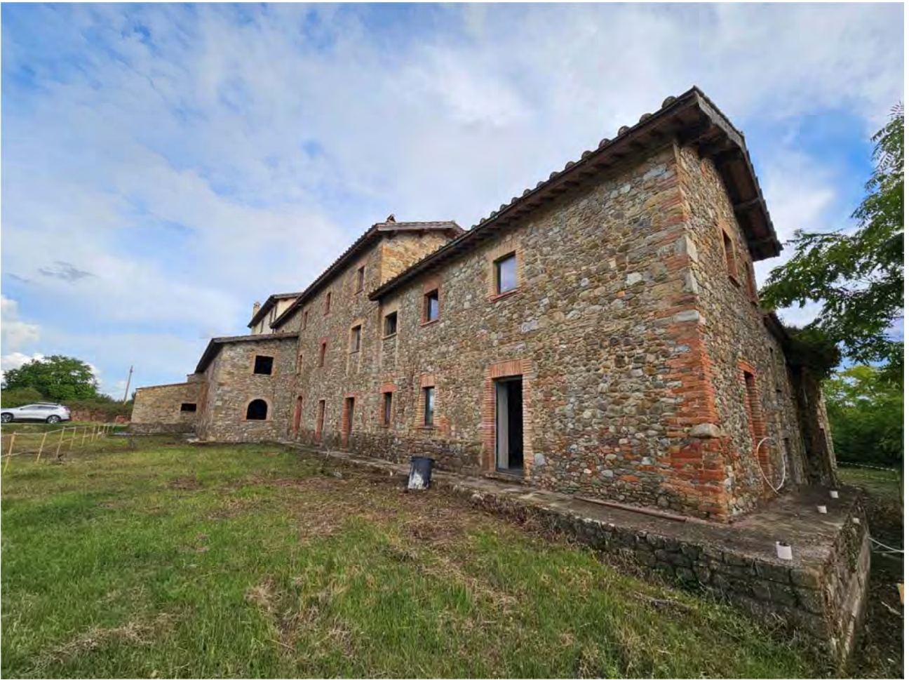
Vista fabbricato principale lato giardini (nord)
