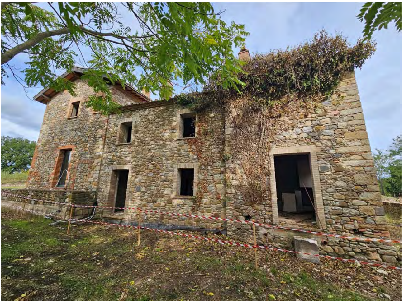
Vista laterale fabbricato principale (ovest)
