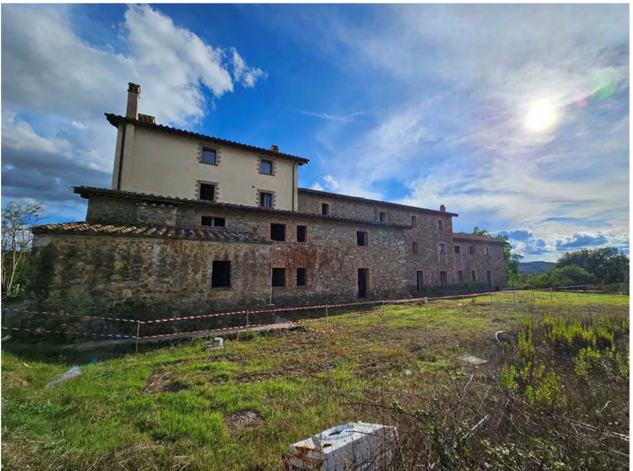
Vista fabbricato principale lato giardini (nord)
