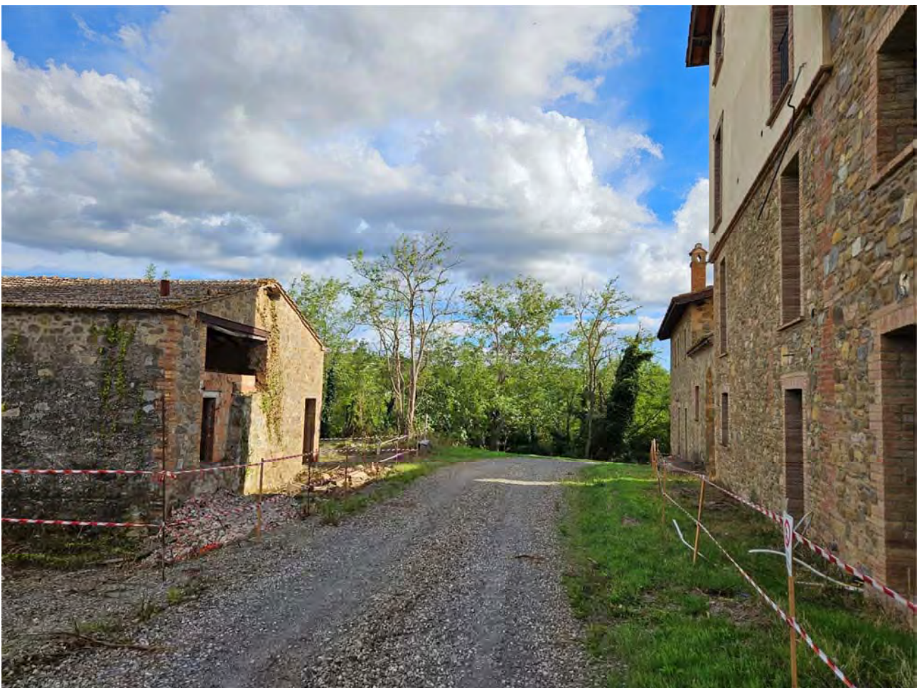
Vista su via del Cipressino lato nord-ovest
