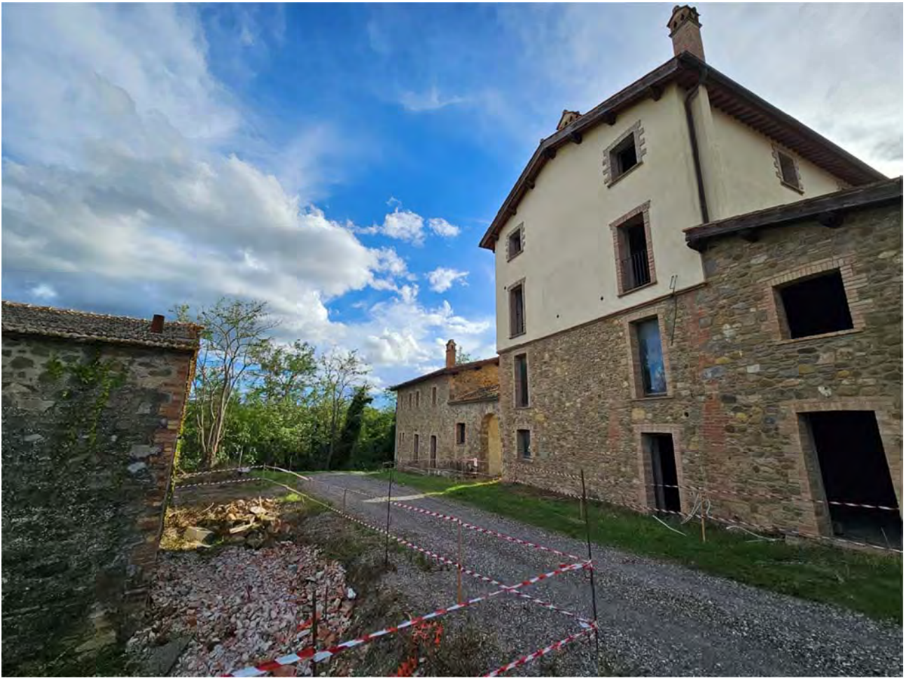
Vista porzione di fabbricato principale su Via del Cipressino (est)
