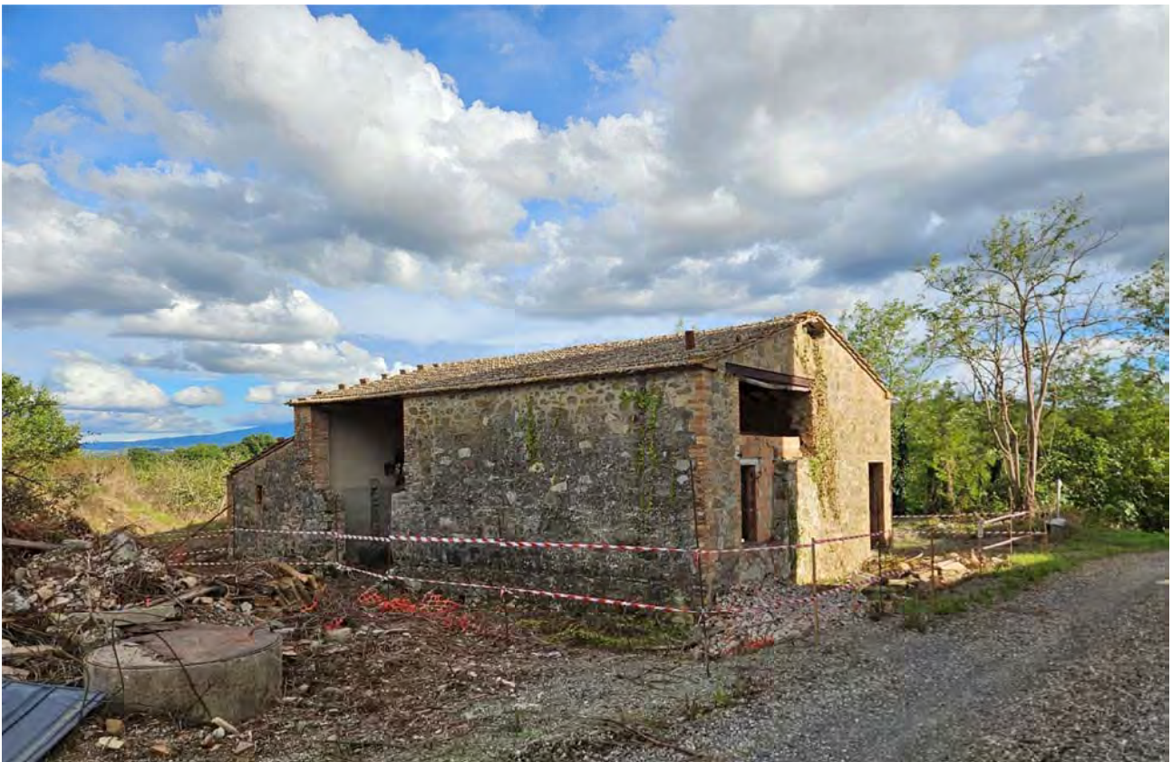
Vista su via del Cipressino lato nord-ovest
