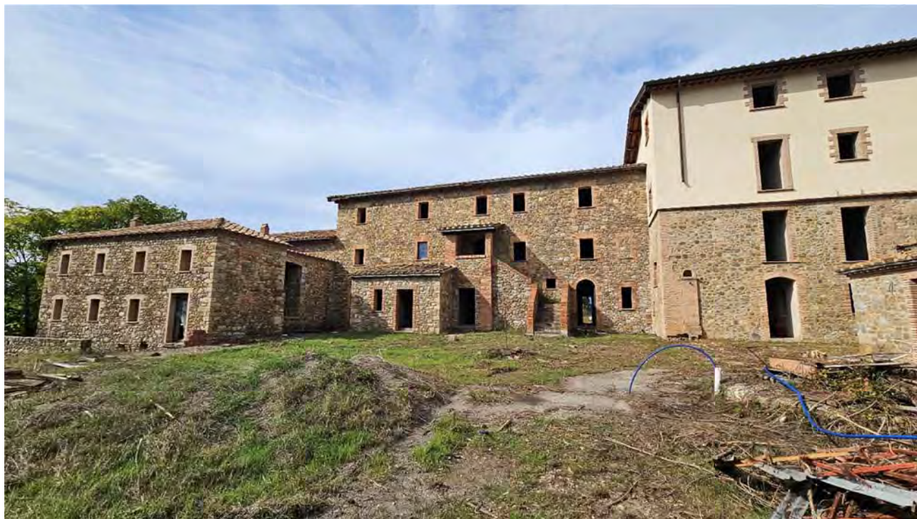
Vista fabbricato principale lato corte interna (sud)
