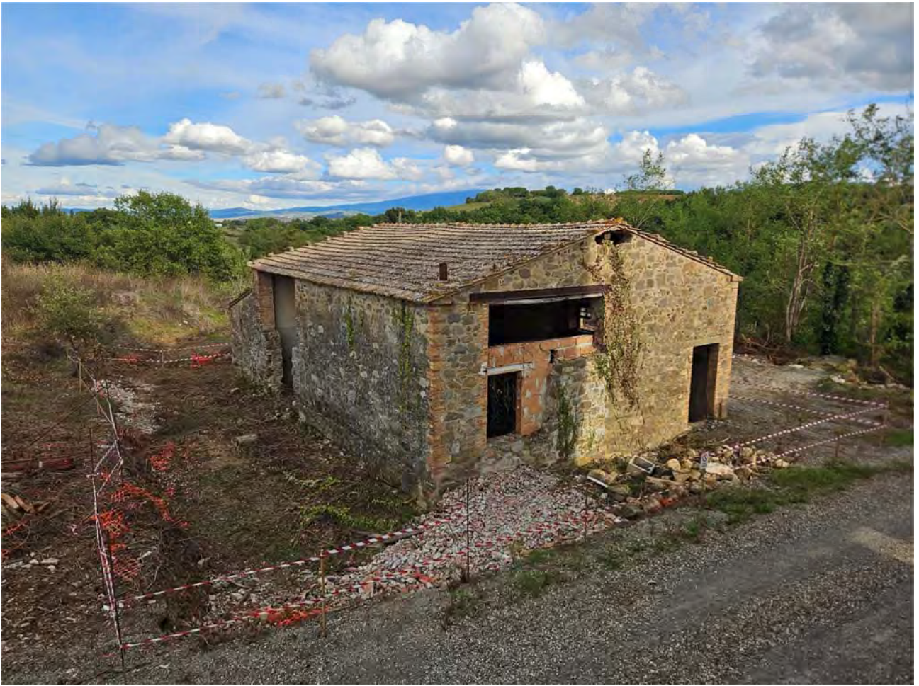
Vista su via del Cipressino lato nord-ovest
