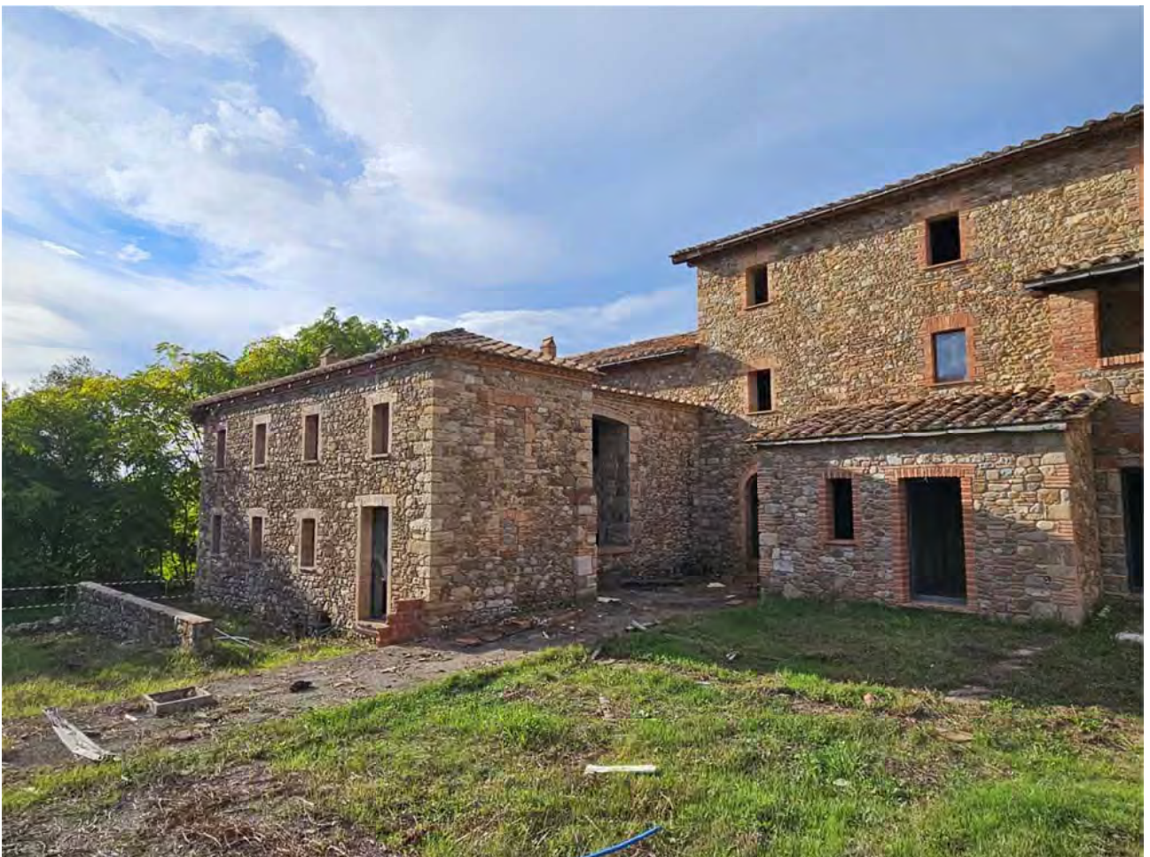
Vista fabbricato principale lato corte interna (sud)
