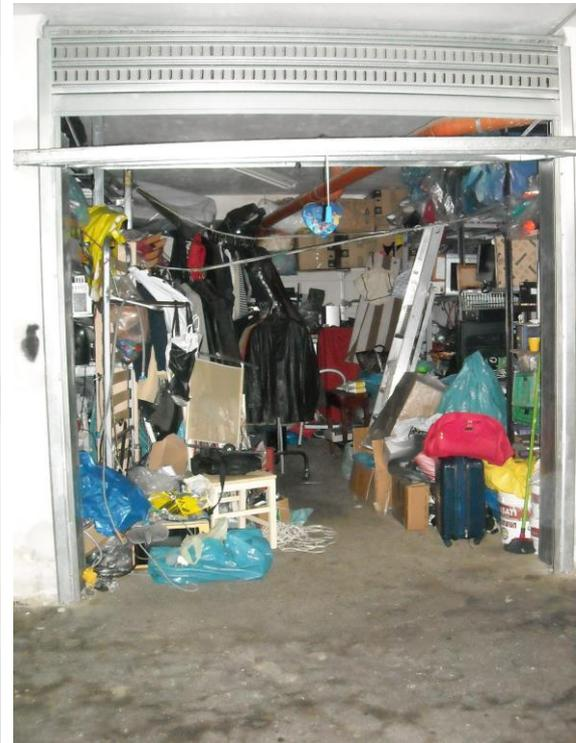
Il box è munito di saracinesca a ribalta, in ferro zincato, al suo interno presenta pareti intonacate ed imbiancate, la pavimentazione in cemento battuto (così come tutto il piano interrato) ed è servito da impianto elettrico. (cfr. foto n.21-22). Altezza interna del box è 2.87 m.
