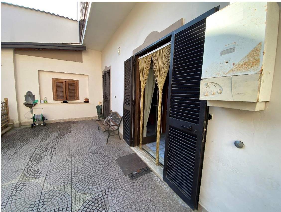
Ingresso piano terra sub. 5 e sub. 6 - lotto 3-
