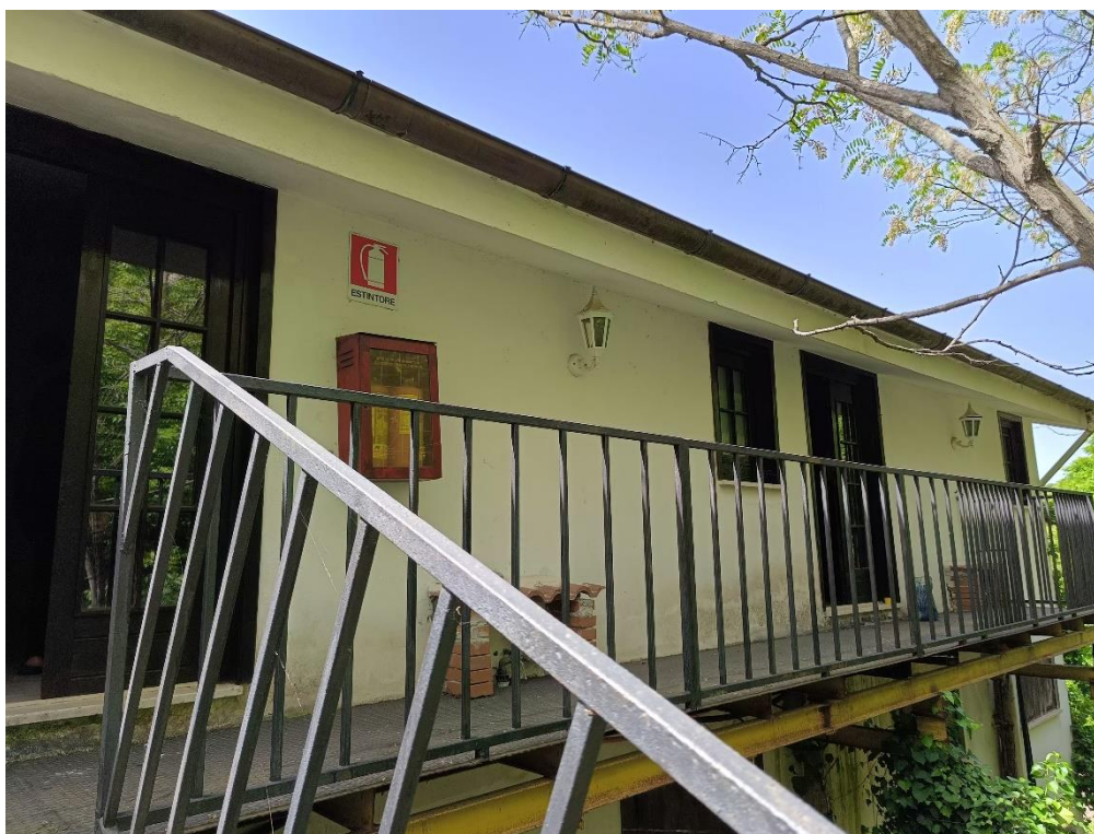
foto n° 18 - Vista Esterna - Bene 4 Piano Mansarda – Sub. 26
