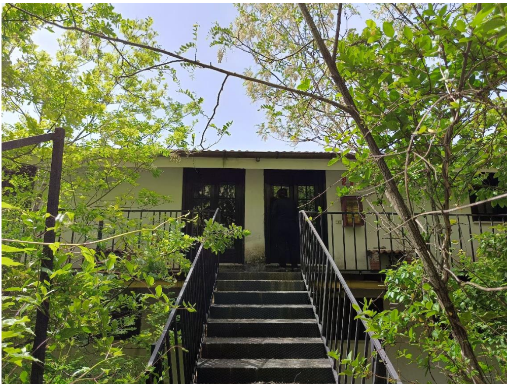
foto n° 27 - Vista Esterna – Intero Fabbricato
