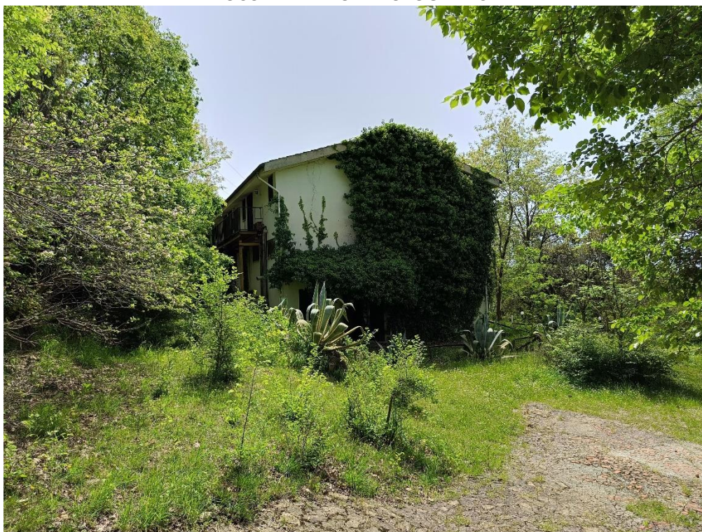
foto n° 29 - Vista Esterna – Intero Fabbricato
