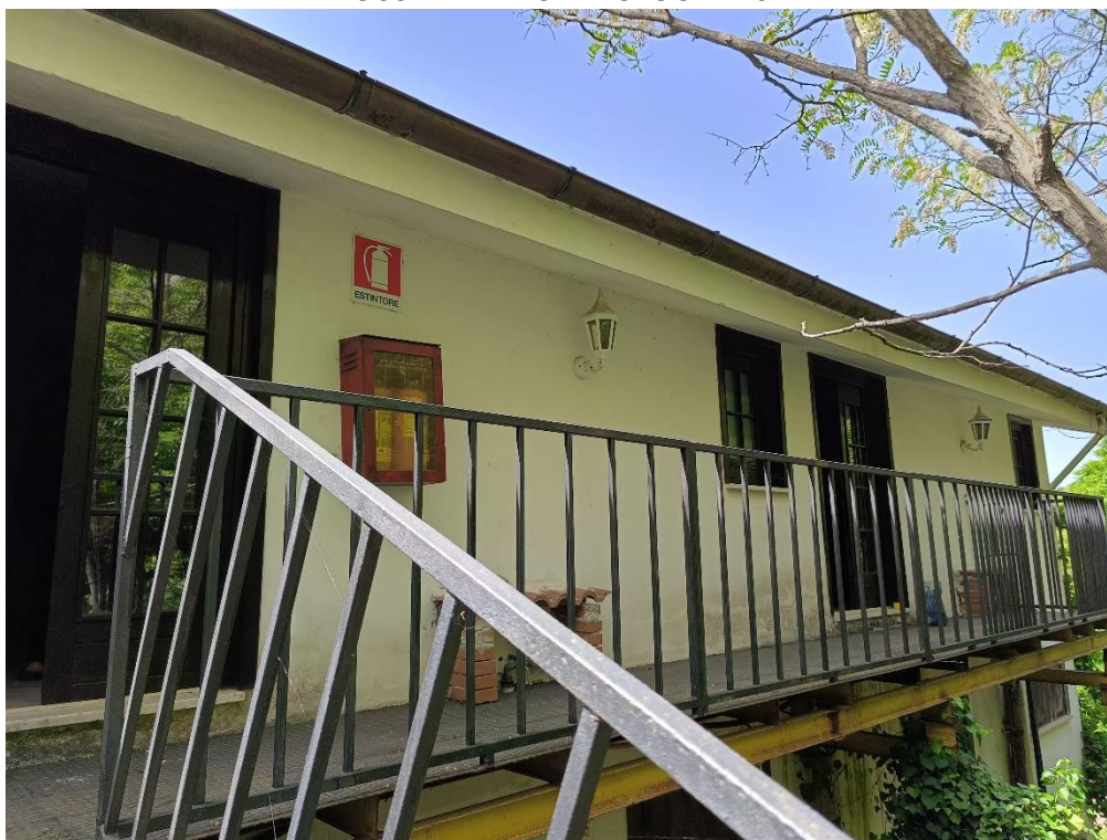
foto n° 21 - Vista Esterna - Bene 5 Piano Mansarda – Sub. 27
