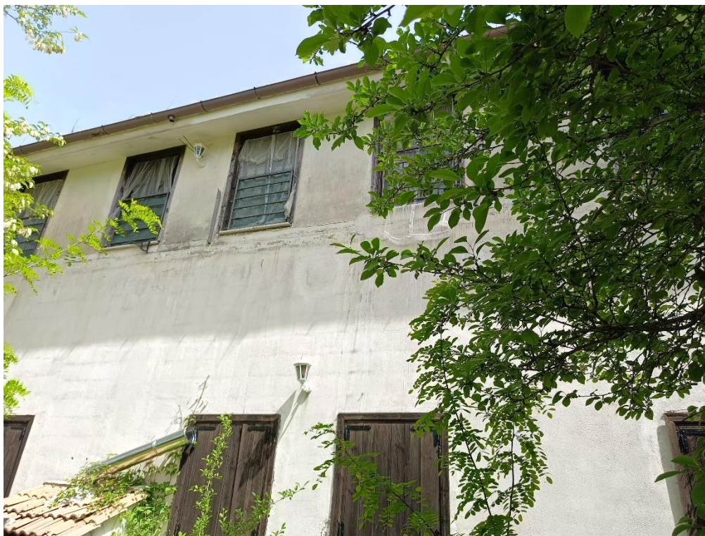
foto n° 26 - Vista Esterna – Intero Fabbricato
