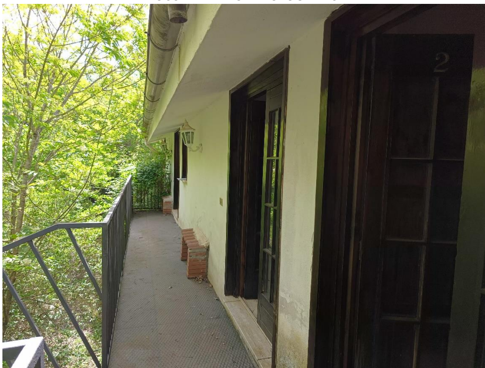
foto n° 13 - Vista Esterna - Bene 3 Piano Mansarda – Sub. 25
