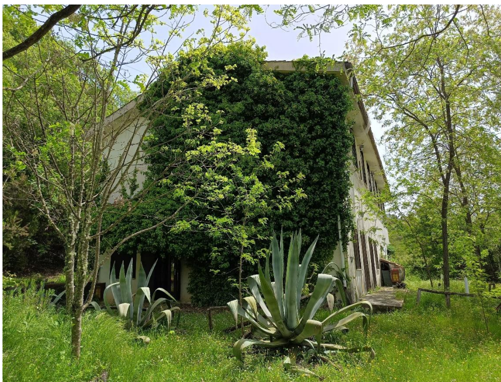
foto n° 30 - Vista Esterna – Intero Fabbricato
