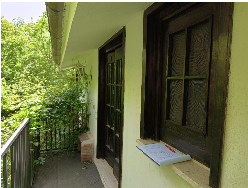
foto n° 7 - Vista Esterna Immobile Bene 2 Piano Mansarda – Sub. 24
