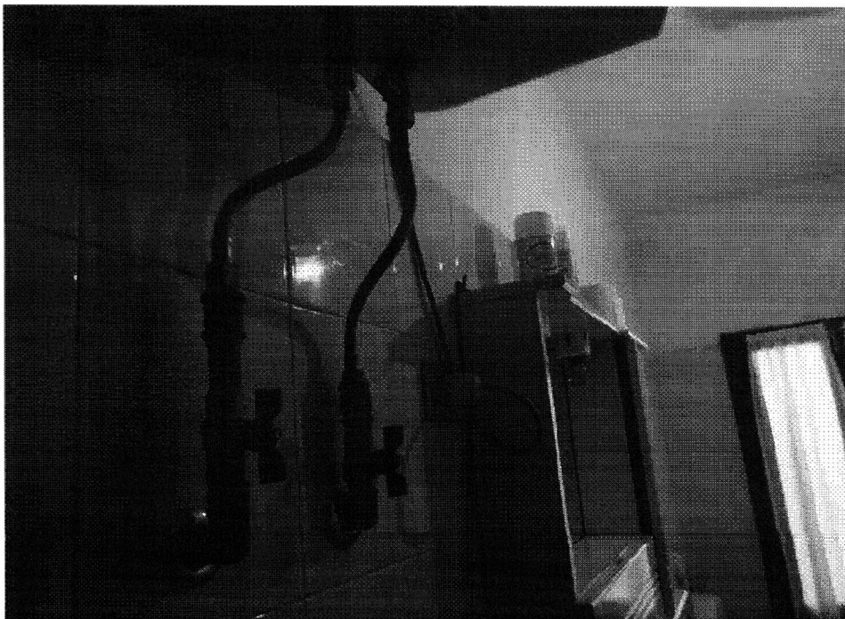
Bagno al piano terra sub.1
