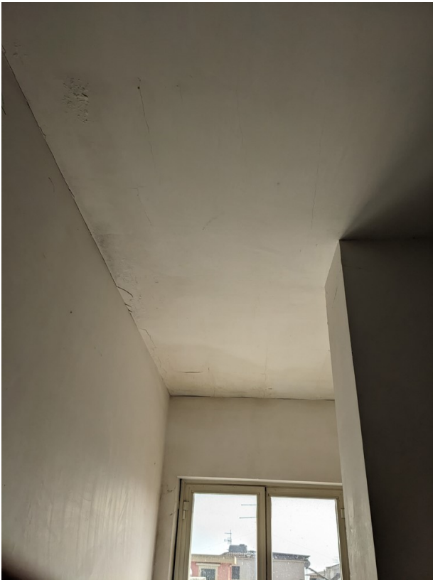
Torrino scala con ripostiglio
