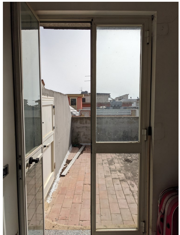
Porta del torrino di accesso al terrazzino
