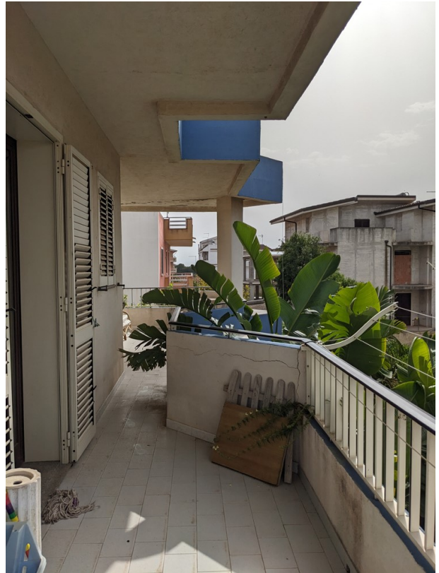
Veranda al piano primo – prospetto sud
