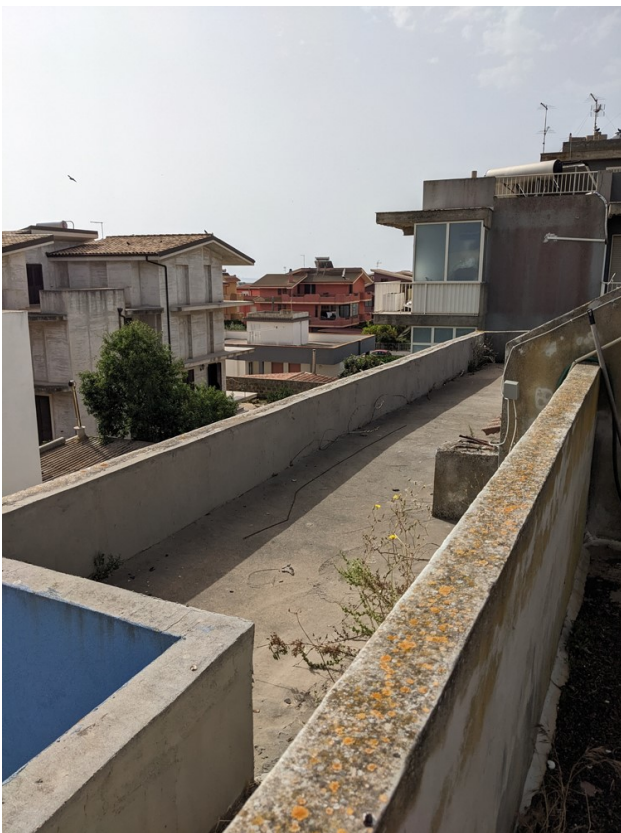
Pensilina aggettante di copertura
