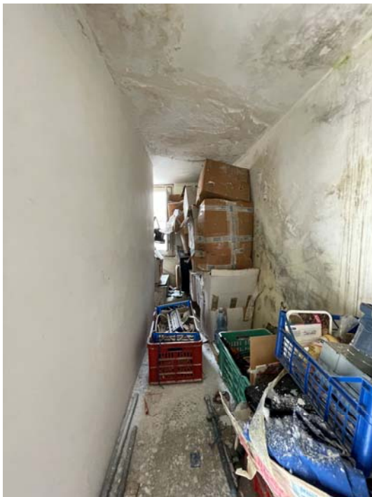
Vista dello spazio annesso alla scala all'ultimo livello
