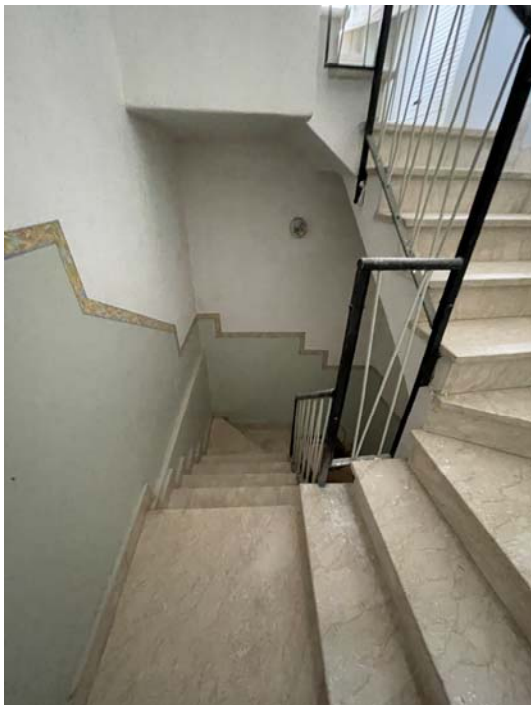
Vista della scala interna
