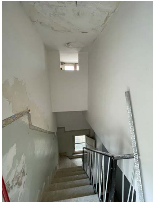
Vista della scala interna
