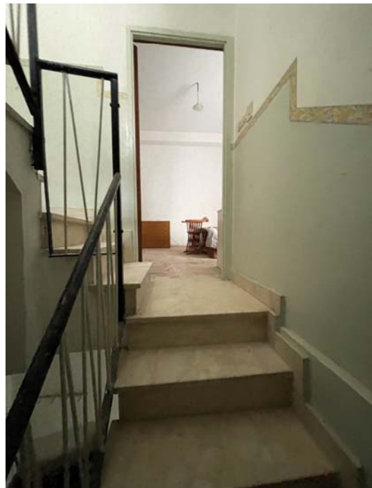
Vista della scala interna
