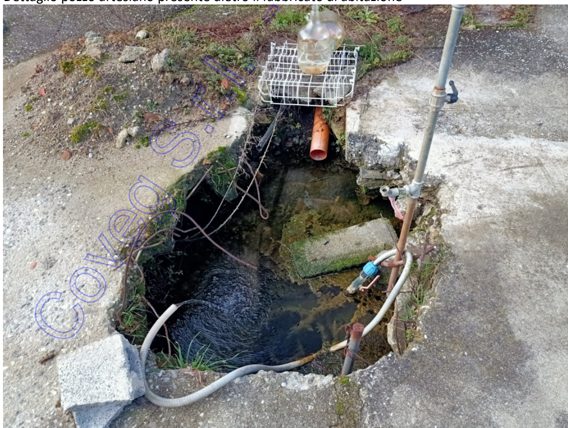
Dettaglio pozzo artesiano presente dietro il fabbricato di abitazione
