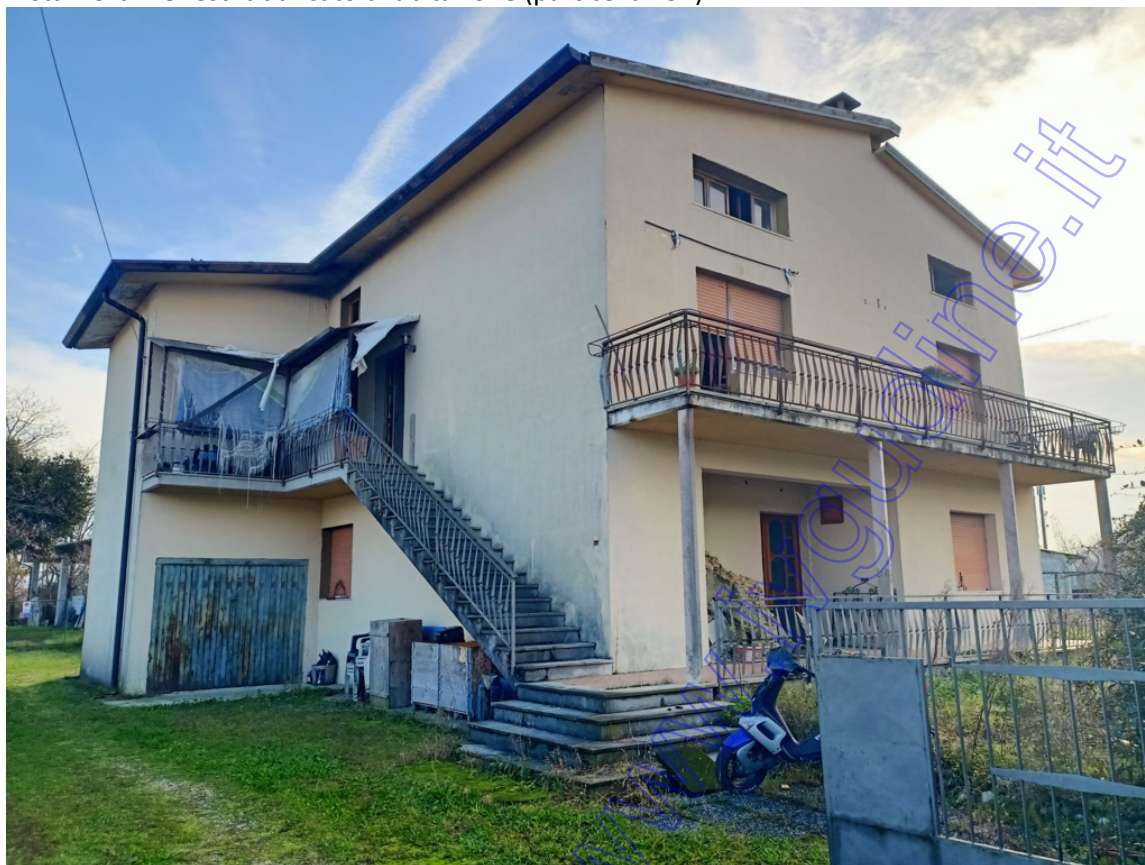
Vista Nord – Ovest fabbricato di abitazione (particella 151)
