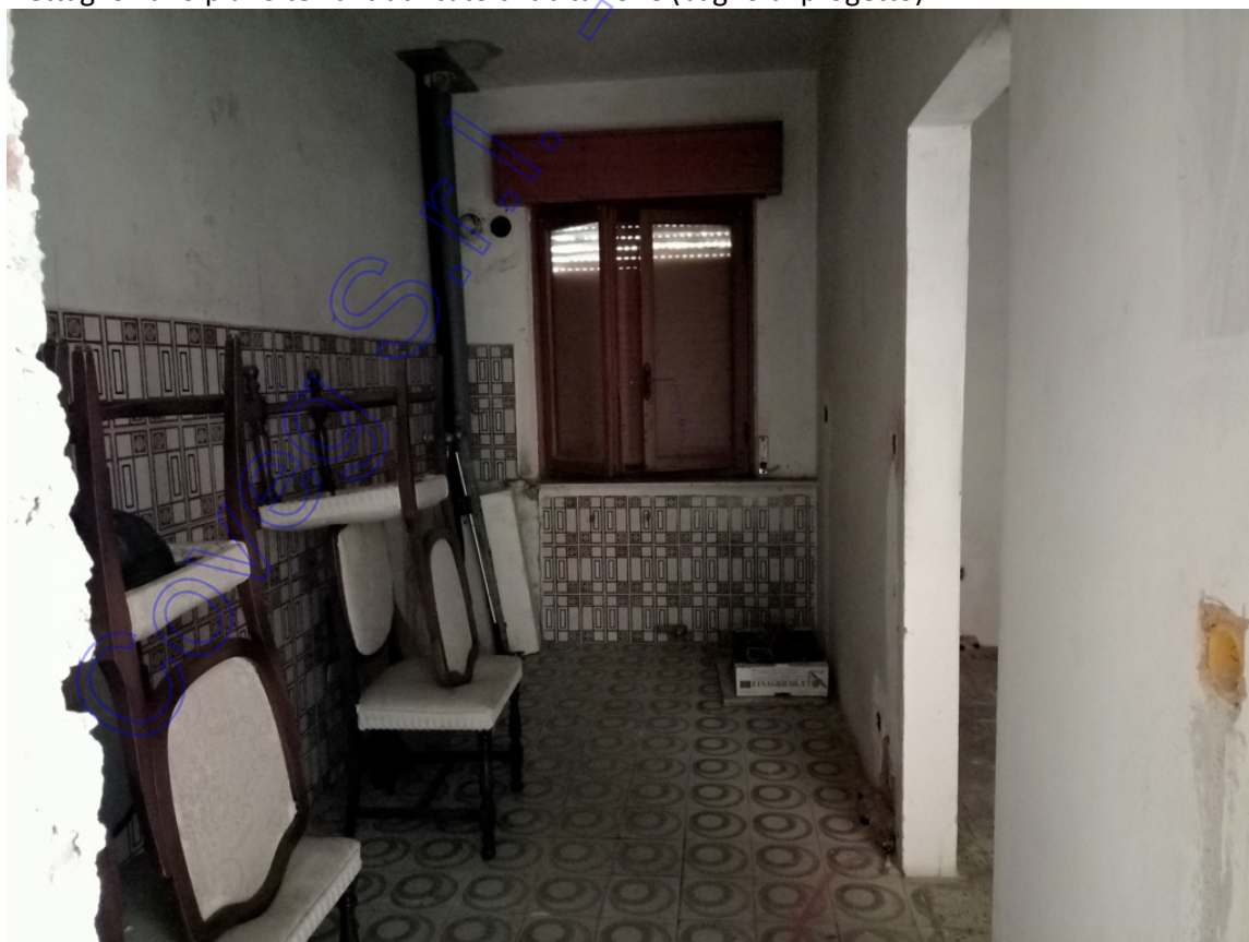
Dettaglio vano piano terra fabbricato di abitazione (bagno di progetto)
