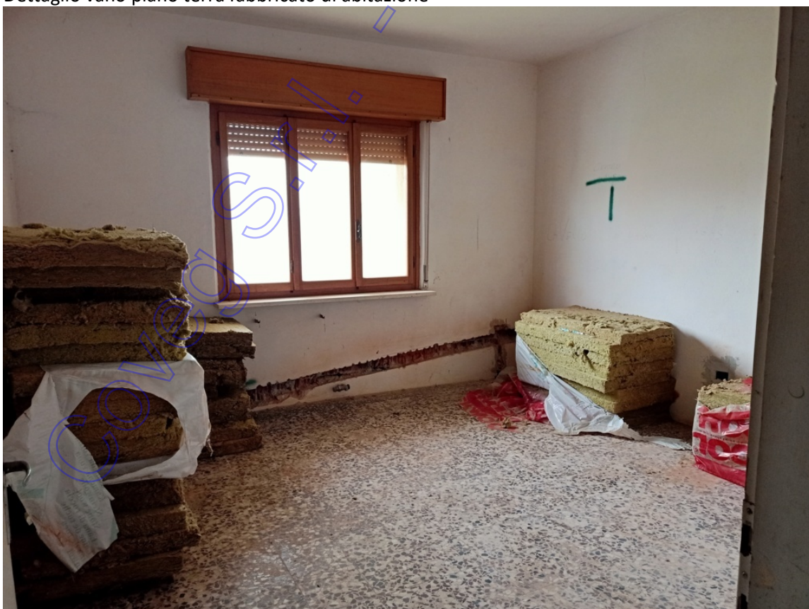
Dettaglio vano piano terra fabbricato di abitazione
