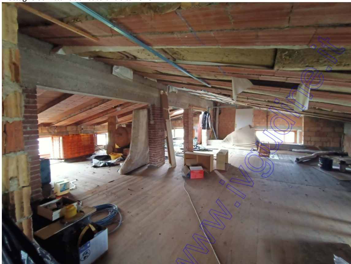
Dettaglio soffitta fabbricato di abitazione
