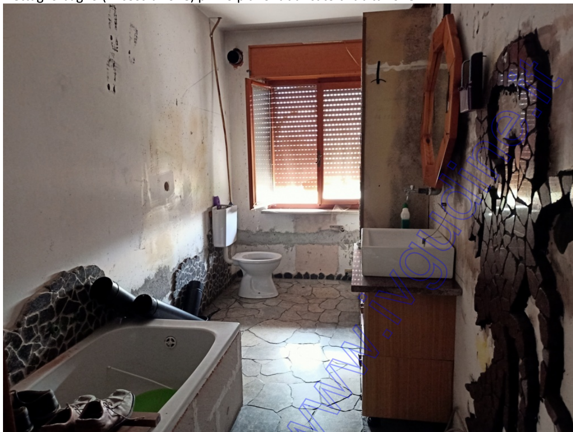
Dettaglio bagno (in costruzione) primo piano fabbricato di abitazione
