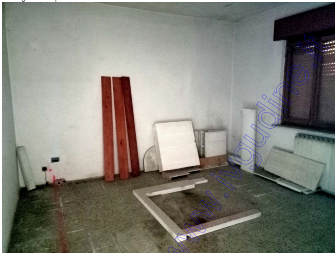
Dettaglio vano piano terra fabbricato di abitazione
