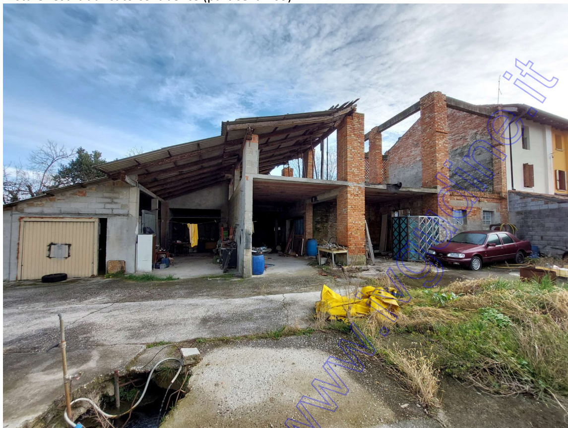
Vista Ovest fabbricato collabente (particella 163)
