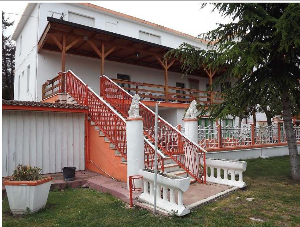
Corpo "A" – scalinata di collegamento terrazza al II° livello, lato camere
