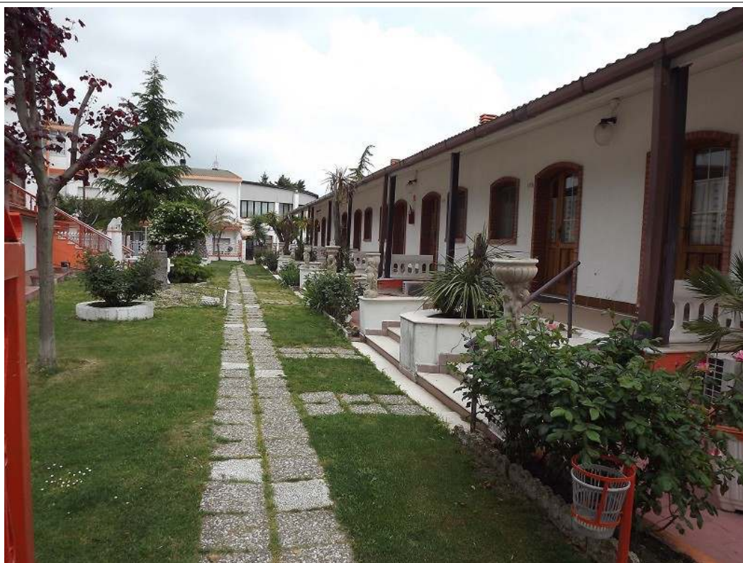
Corpo "B" – II° livello, accesso alle camere
