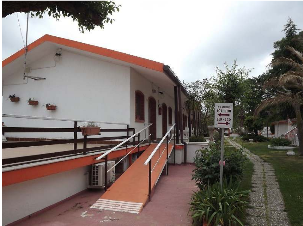
Corpo "B" – II° livello, accesso alle camere
