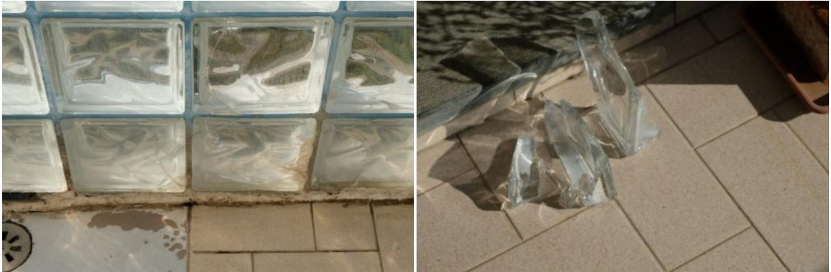
particolari della tipologia e stato di conservazione dei componenti di parte del parapetto dei balconi
