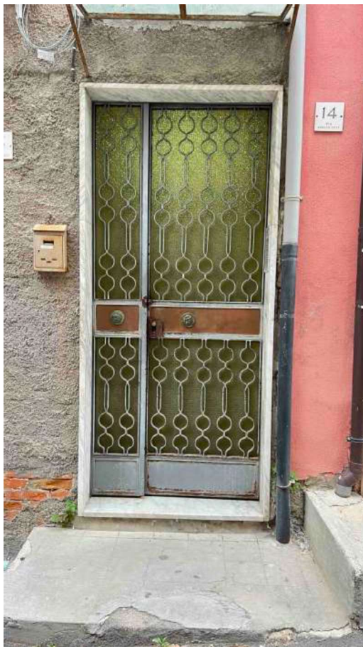
fig. 2 – Portone di ingresso
