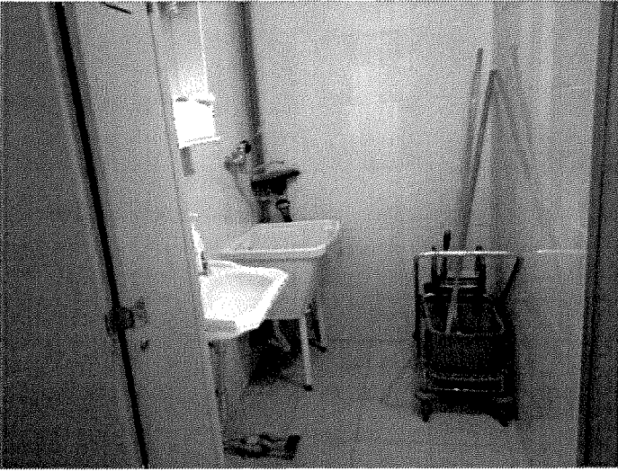
Foto n. 9 – Part. 342 sub 35 - Vista interna
