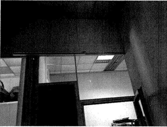
Foto n. 25 – Part. 342 sub 37 - Vista interna
