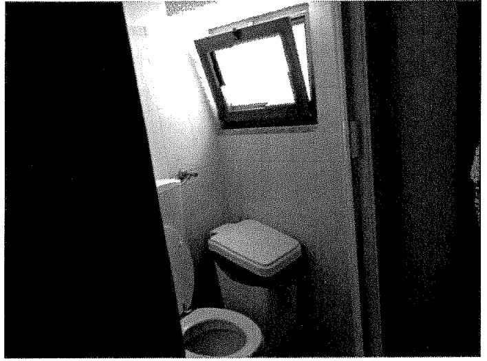
Foto n. 8 – Part. 342 sub 35 - Vista interna
