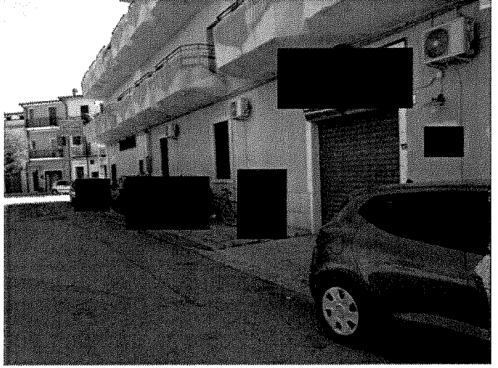
Foto n. 10 – Part. 342 sub 36 - Vista esterna
