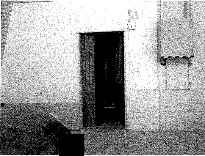
Foto n. 1 – Part. 342 sub 35 - Vista esterna
