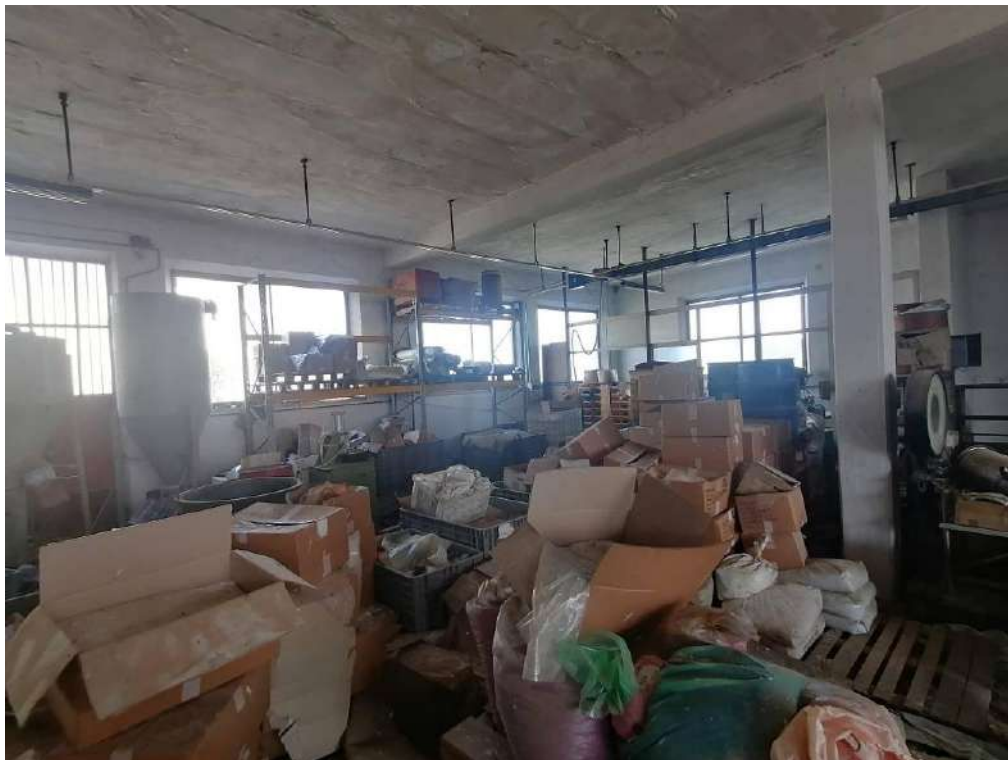
FOTO 107 (laboratorio porzione nord-ovest – piano 1°)
