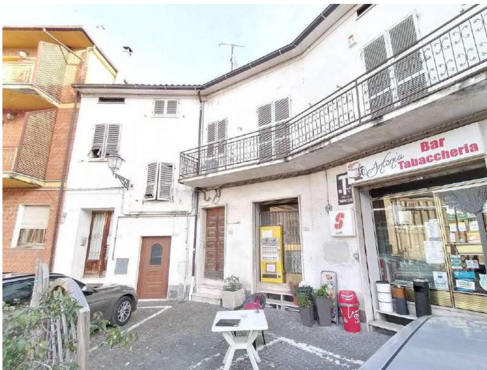
FOTO 13 (vista nord-est / ingresso)
