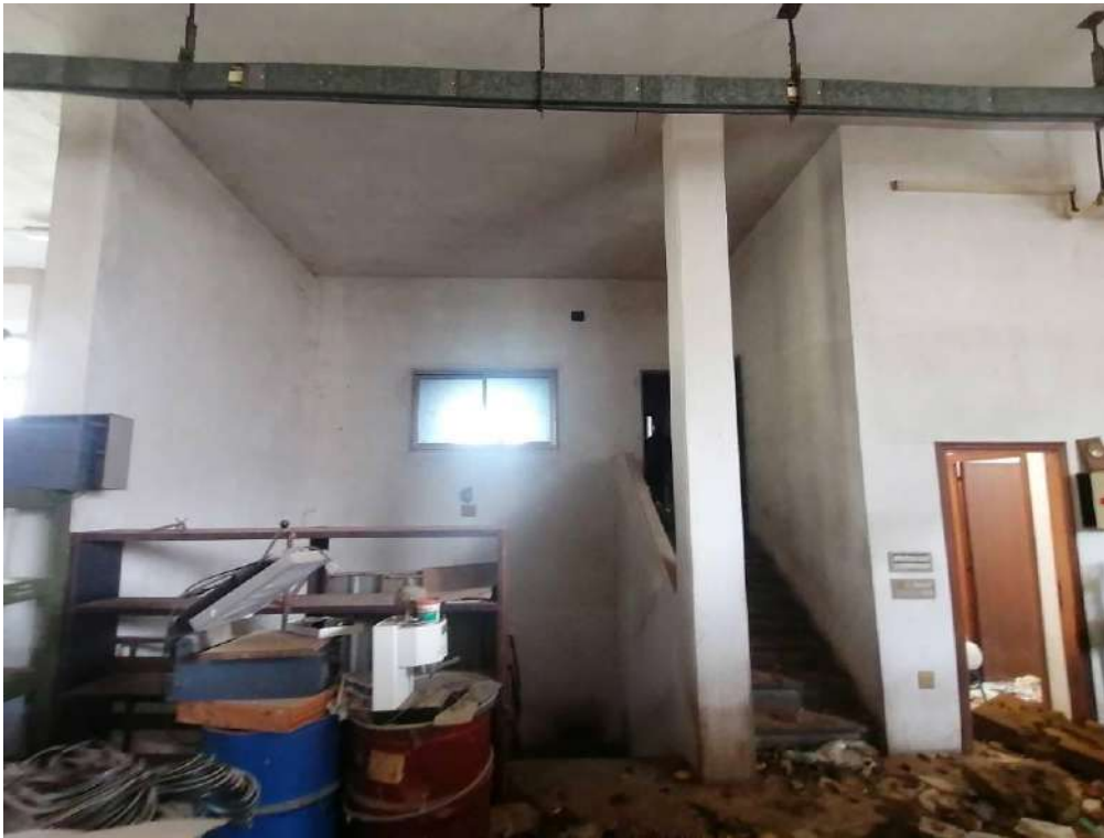
FOTO 108 (laboratorio porzione nord / vano scala – piano 1°)
