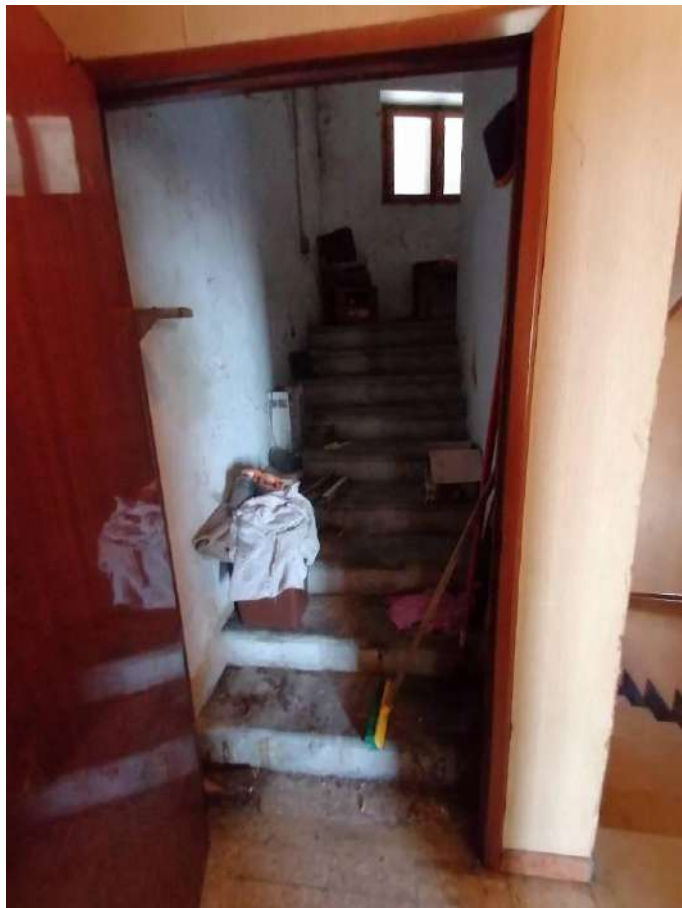
FOTO 20 (ingresso piano sottotetto)
