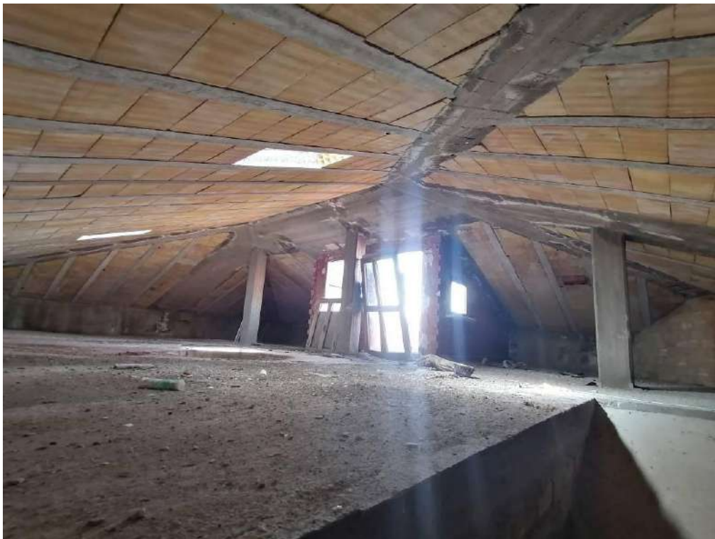
FOTO 137 (locale non ultimato – piano 3°)
