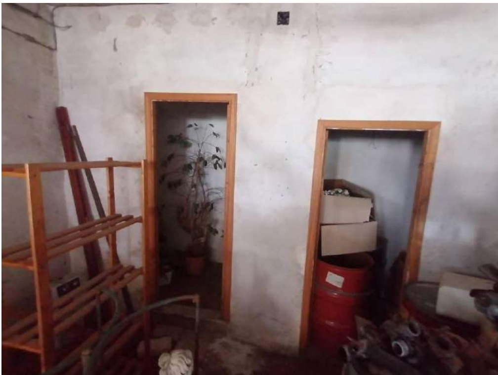
FOTO 92 (ingressi ripostiglio e bagno)
