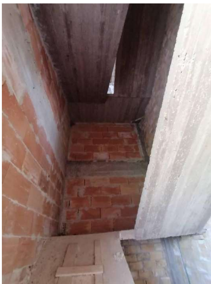
FOTO 121 (vano scala – piano 1°-2°)
