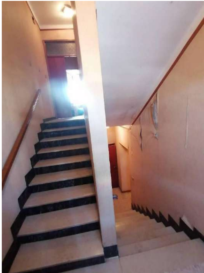
FOTO 44 (vano scala comune)
