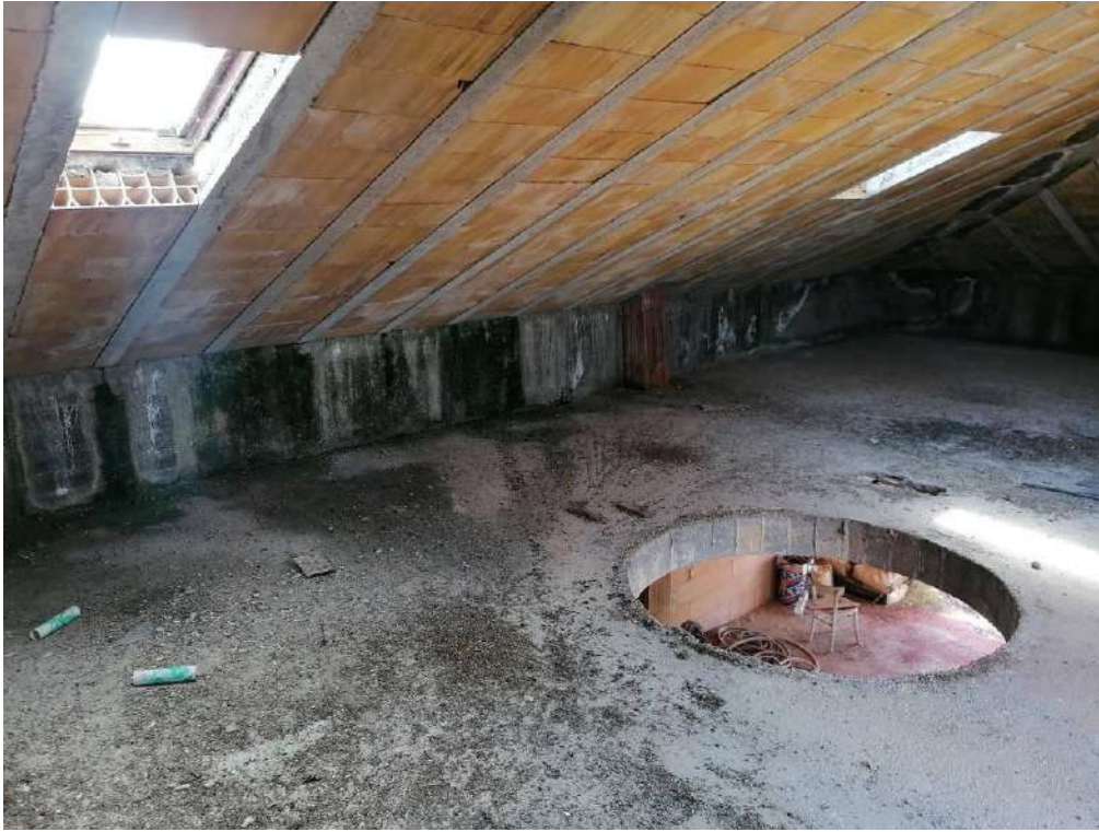
FOTO 138 (locale non ultimato – piano 3°)
