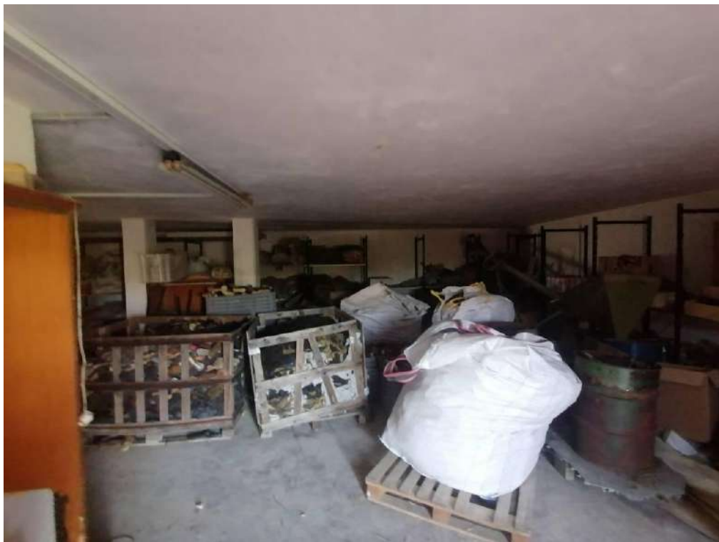
FOTO 123 (magazzino lato est – piano T)
