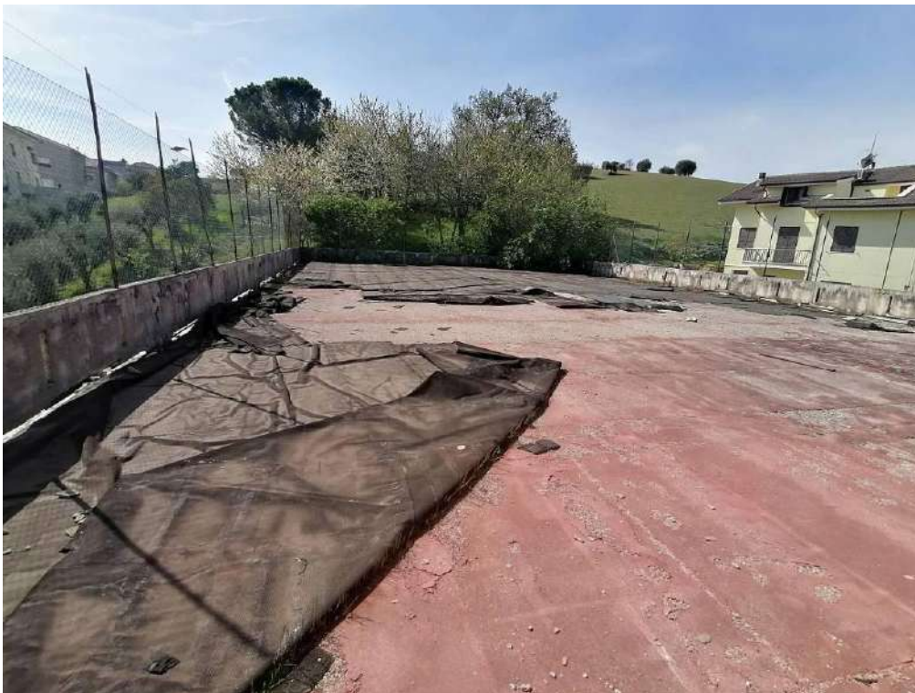
FOTO 101 (copertura porzione sud)
