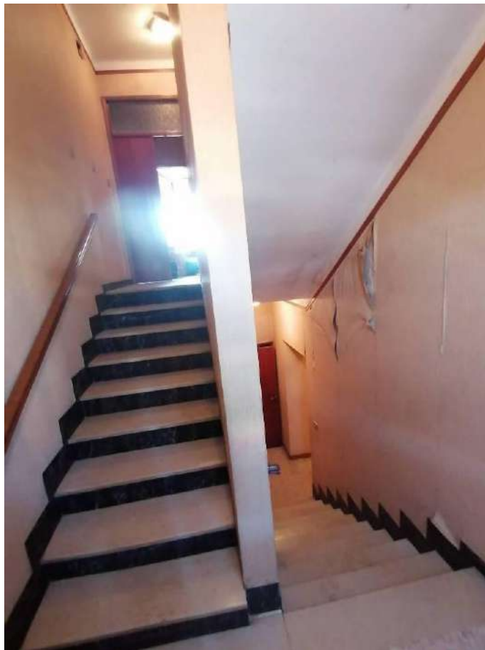
FOTO 16 (vano scala comune)
