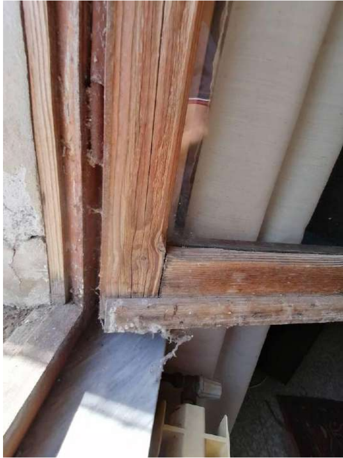
FOTO 27 (particolare degli infissi)
