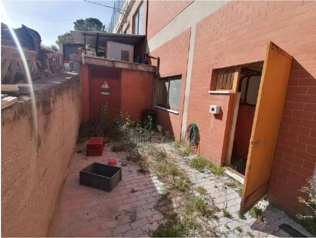
FOTO 132 (ingressi centrale enel esterna e centrale termica – piano T)
