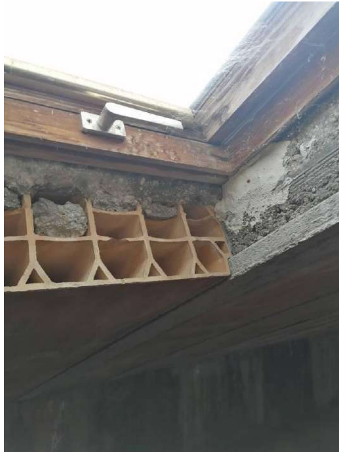
FOTO 139 (particolare del lucernario – piano 3°)
