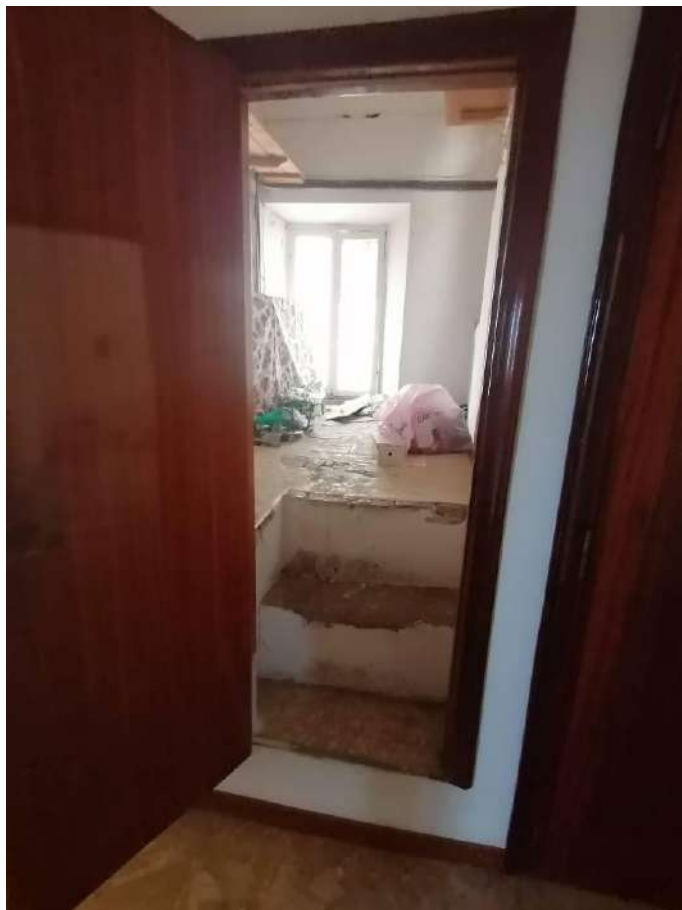
FOTO 162 (accesso locale ripostiglio)
