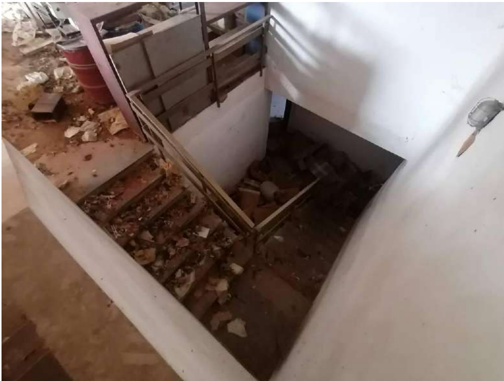
FOTO 109 (vano scala – piano T-1°)
