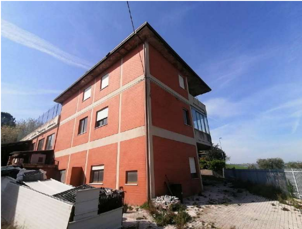
FOTO 131 (vista nord-est, al piano T locale non accessibile situato all'angolo in primo piano)
