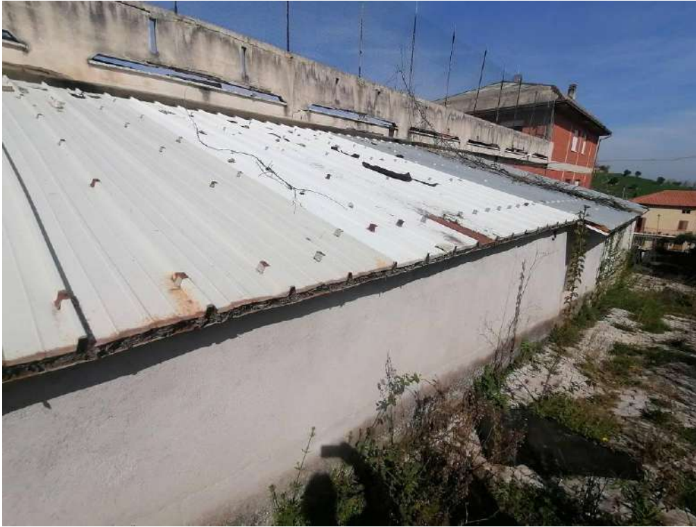
FOTO 130 (copertura del locale coperto a sud del laboratorio, porzione est)
