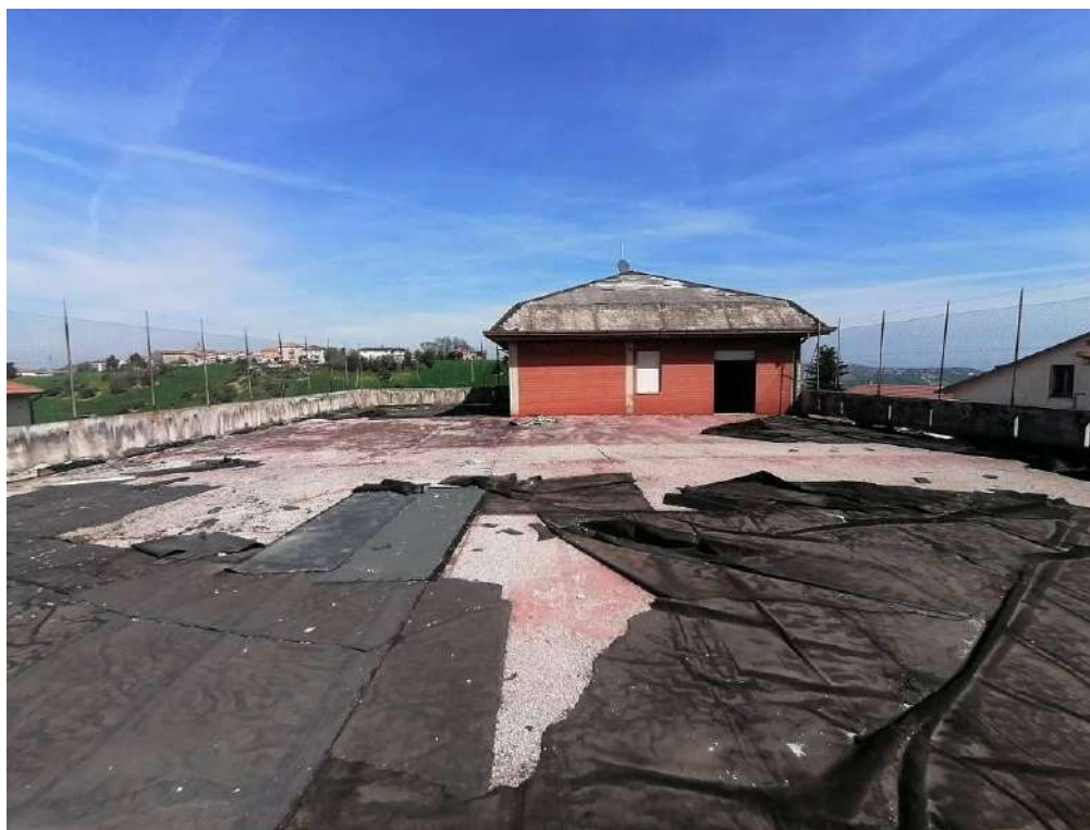
FOTO 103 (copertura vista d'insieme)
