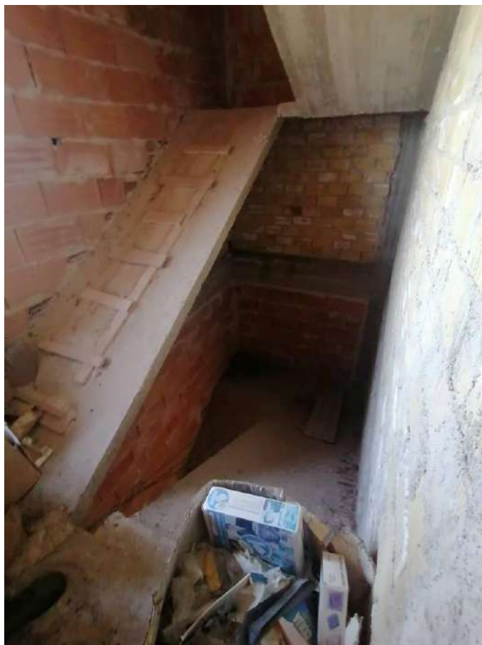
FOTO 120 (vano scala – piano 1°-2°)
