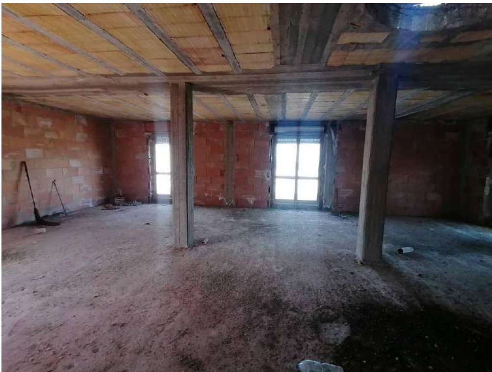
FOTO 135 (locale non ultimato – piano 2°)
