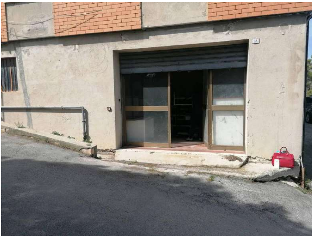
FOTO 84 (vista sud-est / ingresso)
