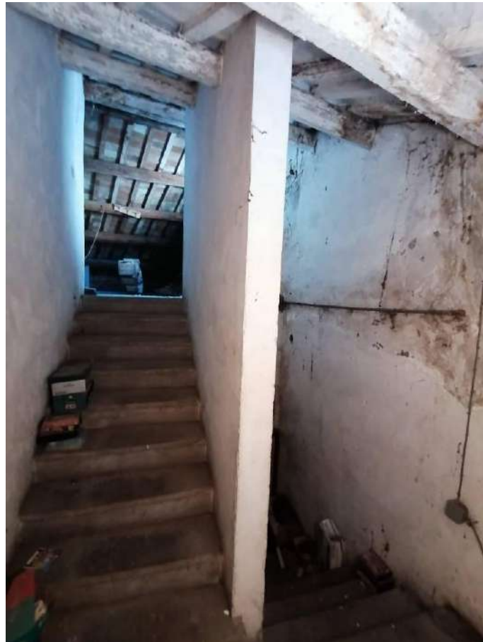
FOTO 34 (scala di accesso alla soffitta comune)
