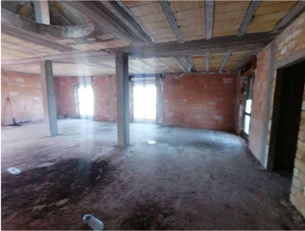
FOTO 134 (locale non ultimato – piano 2°)
