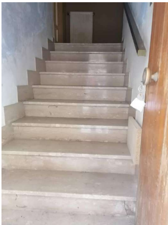
FOTO 146 (vano scala interno comune)
