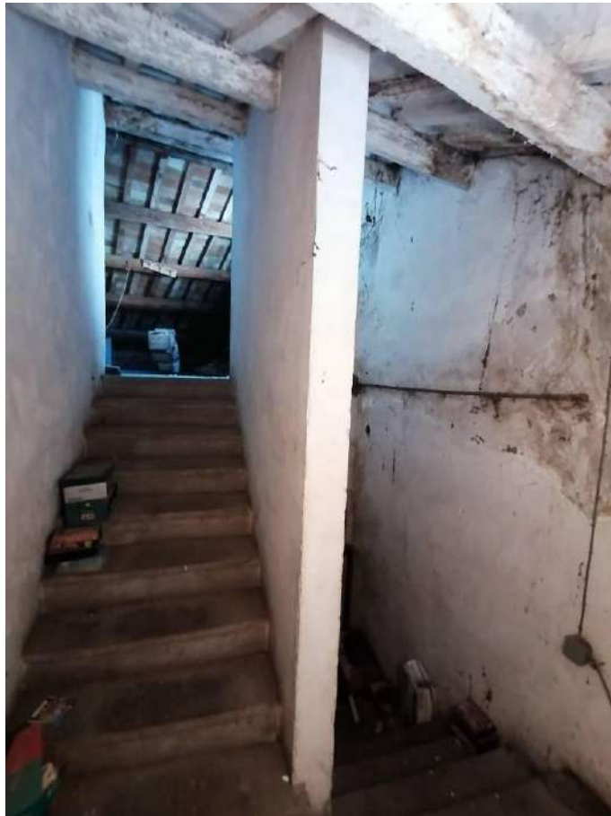
FOTO 63 (scala di accesso alla soffitta comune)
