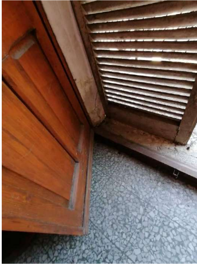
FOTO 54 (particolare dell'infisso e del pavimento della cucina)
