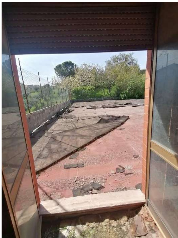
FOTO 142 (accesso alla copertura – piano 3°)
