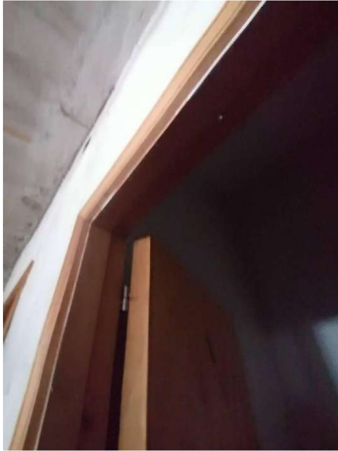
FOTO 95 (particolare porta ripostiglio)
