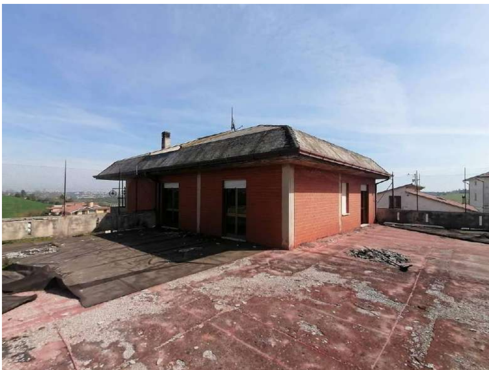
FOTO 102 (copertura porzione nord)
