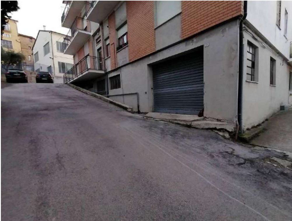
FOTO 83 (vista nord-est / sud-est)
