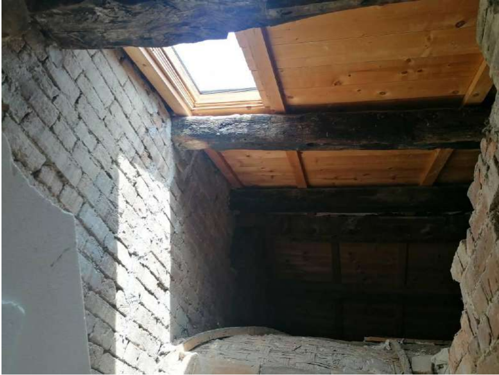
FOTO 164 (intradosso copertura visibile dal locale ripostiglio)
