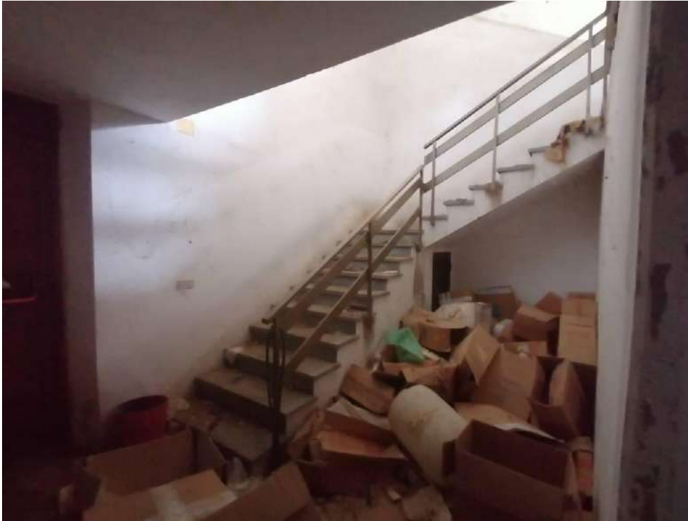
FOTO 124 (vano scala – piano T)
