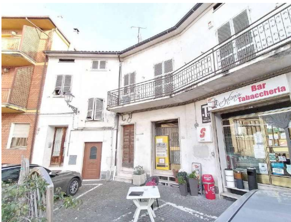
FOTO 1 (vista nord-est / ingresso)
