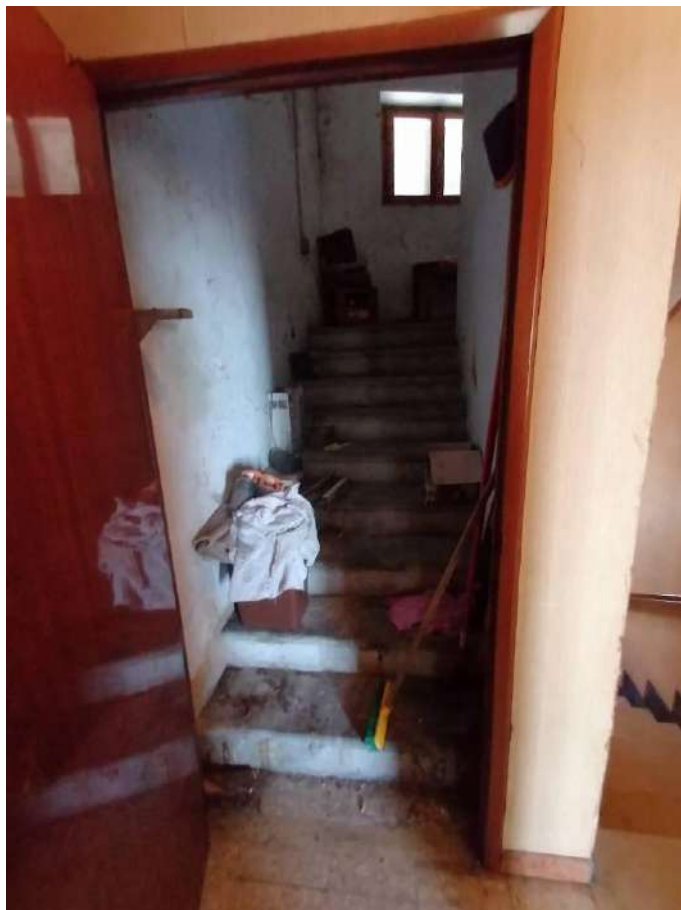
FOTO 48 (ingresso piano sottotetto)
