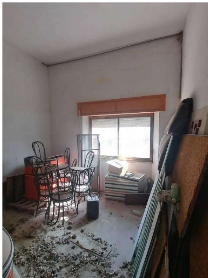
FOTO 129 (magazzino lato nord – piano T)
