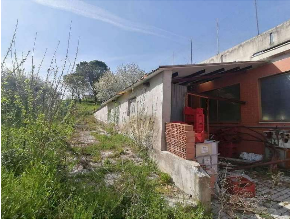
FOTO 100 (vista est porzione sud)
