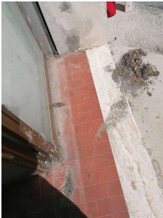
FOTO 86 (particolare soglia, infisso e pavimento ingresso)
