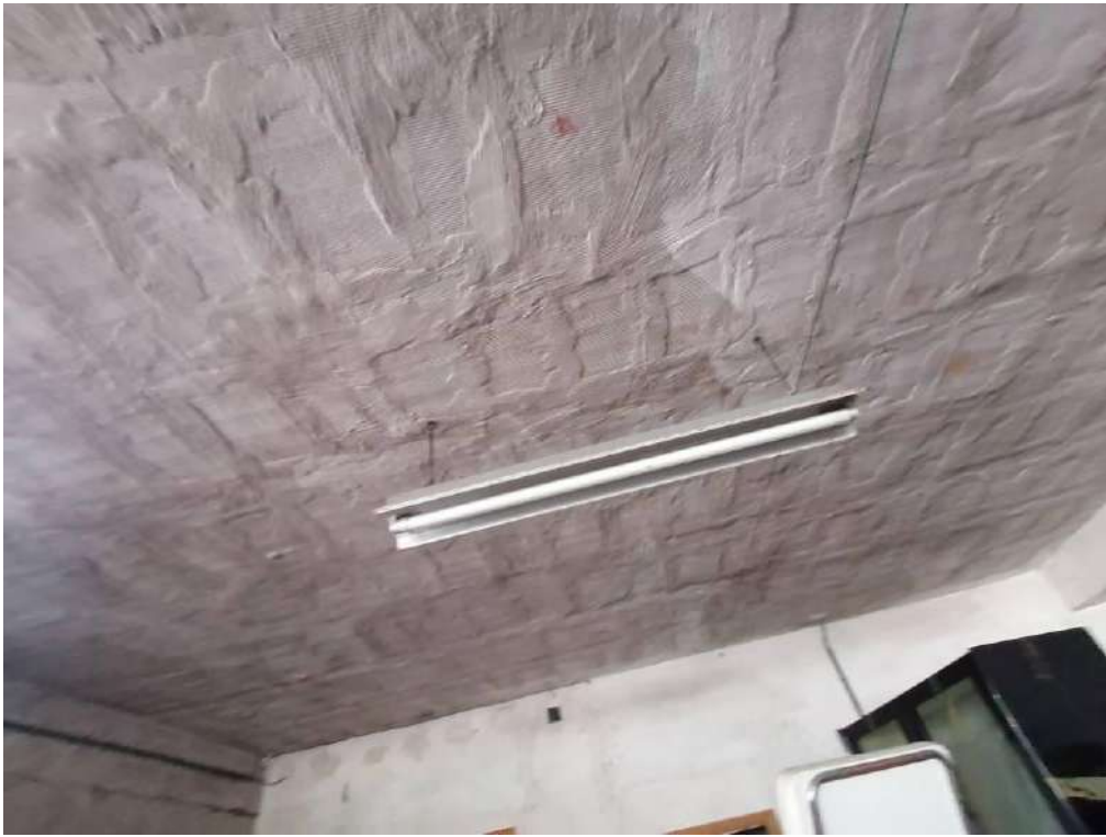
FOTO 91 (particolare del soffitto e dell'impianto di illuminazione)
