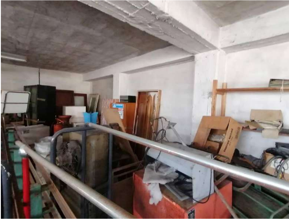
FOTO 89 (laboratorio lato ovest)
