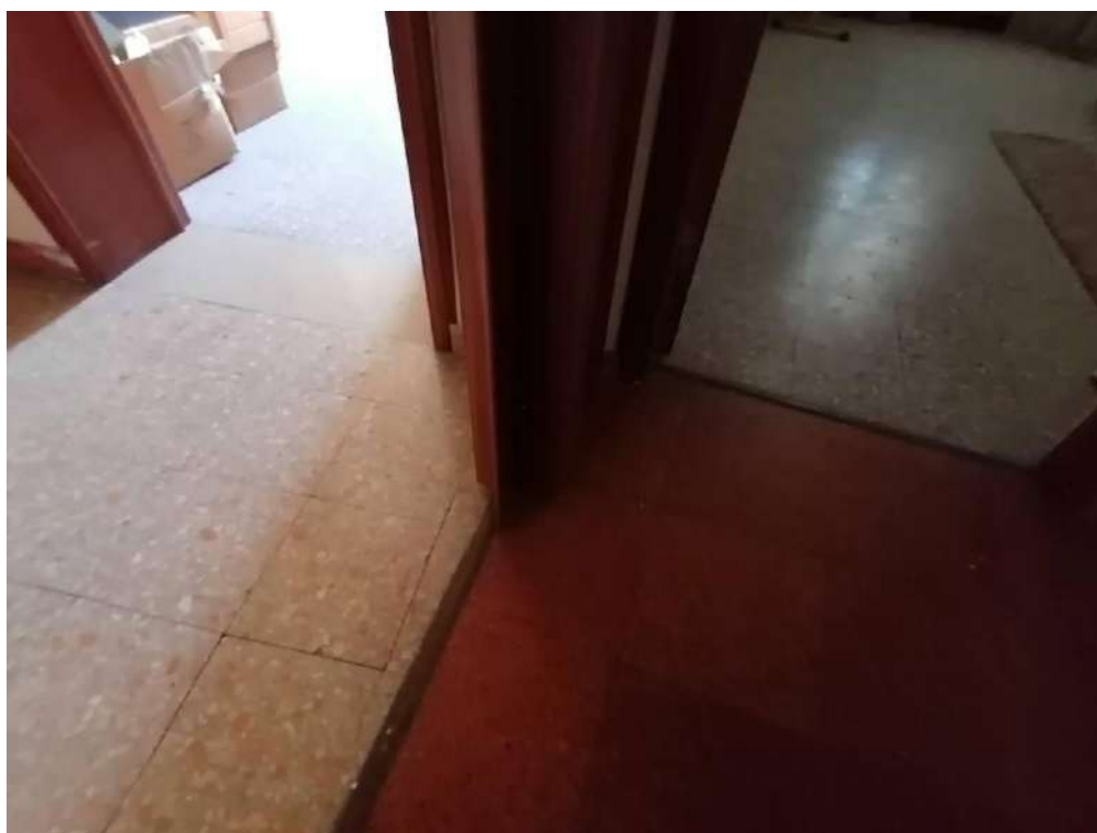
FOTO 57 (particolare pavimento camera e soggiorno)
