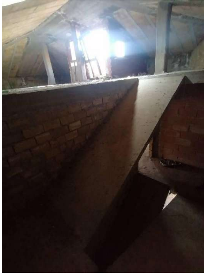
FOTO 136 (vano scala – piano 2°-3°)
