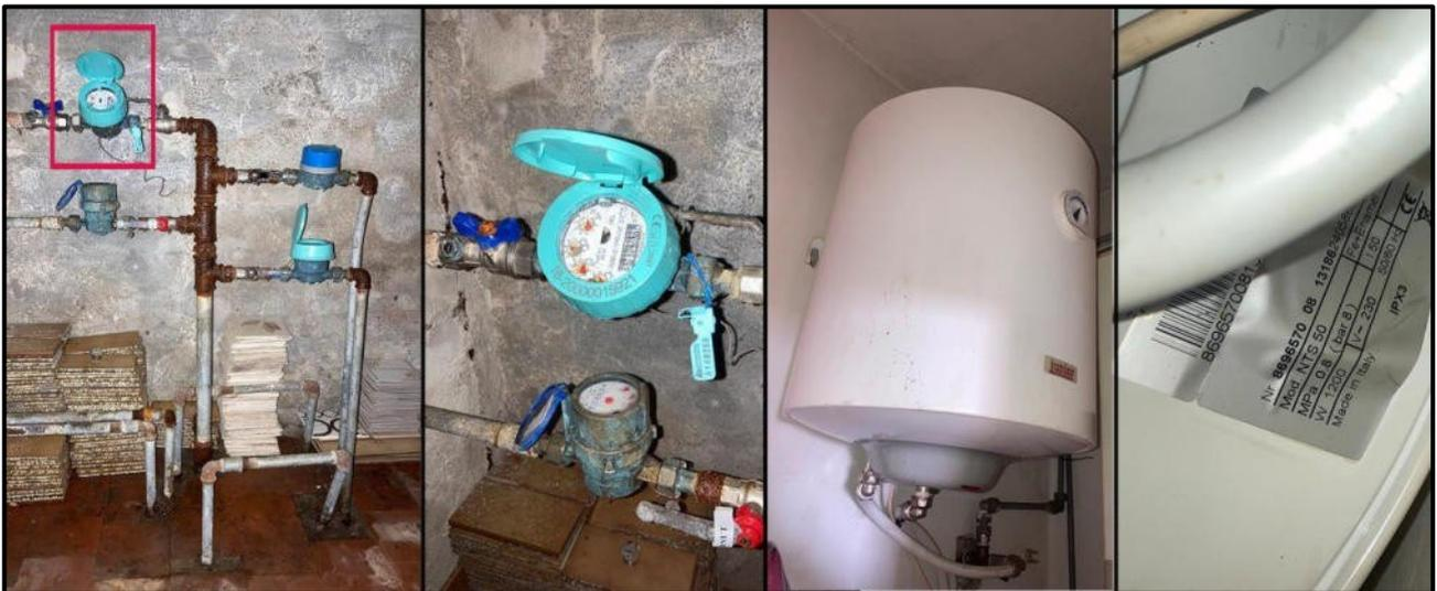
**Impianto idrico: contatore in locale comune sottoscala e boiler per ACS**
