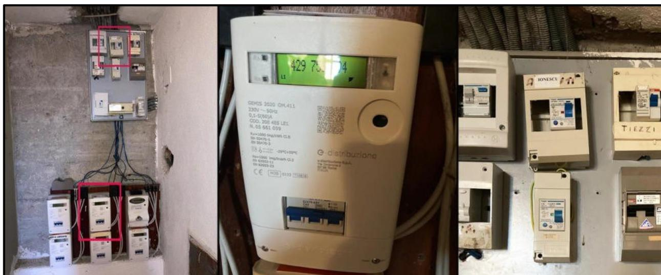
**Impianto elettrico: punto di fornitura con alloggiamento contatore e differenziale.**
