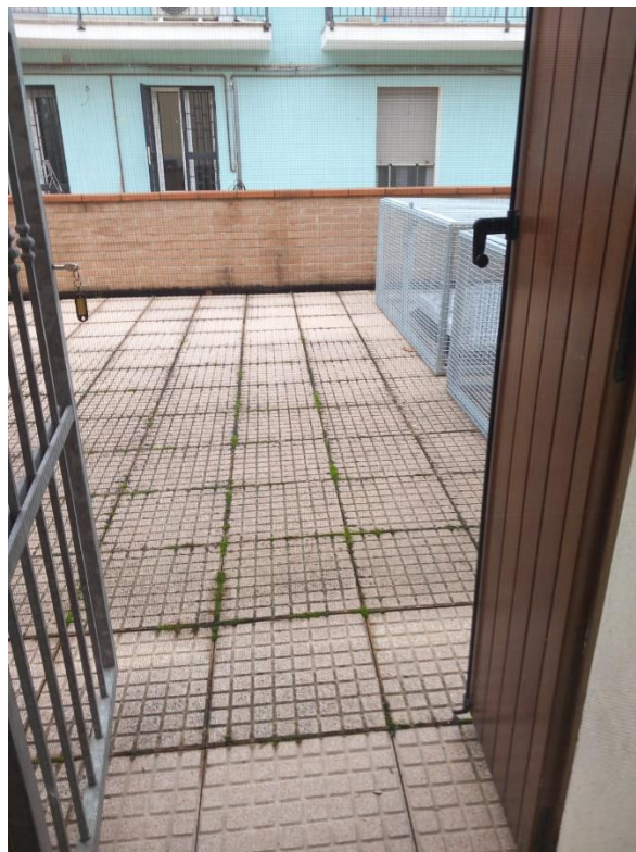
VARCO (PORTA-FINESTRA) PER ACCESSO AL LASTRICO SOLARE
