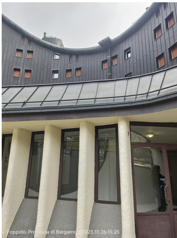
Fotografia 2 – ingresso al complesso immobiliare
