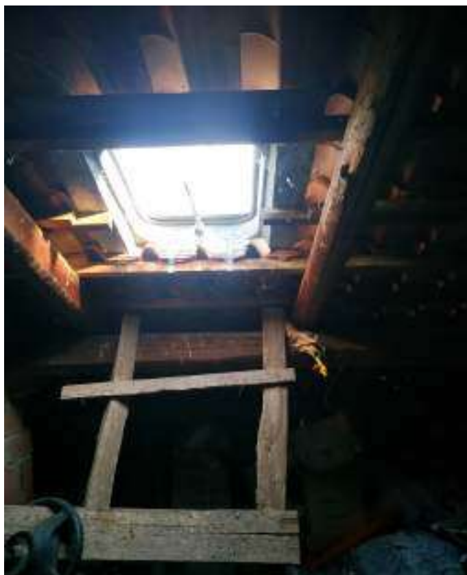
Foto n°22 - Foto n°23 - Foto n°24 - Foto n°25 – Piano sottotetto
