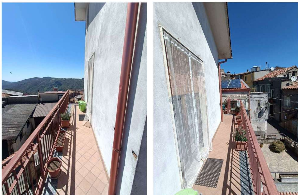
Figura 4: Vista dai due lati corti del balcone della cucina
