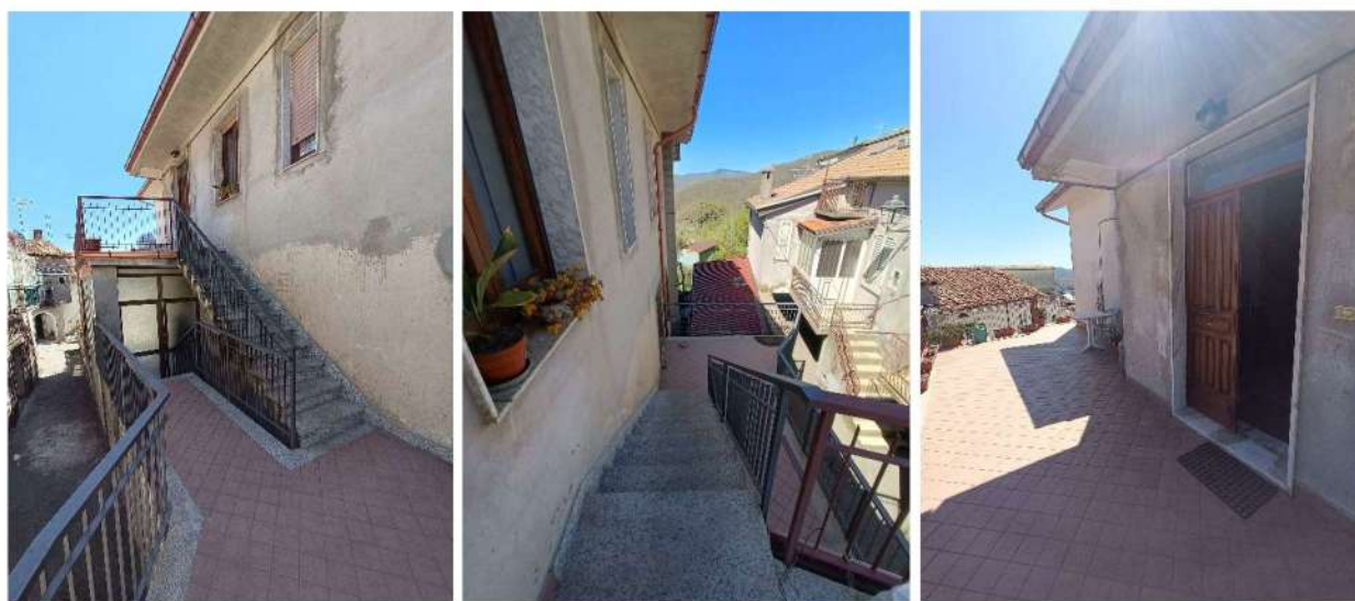
Figura 2: Vista delle scale di accesso all'immobile 1 e vista del terrazzo con portone di ingresso
