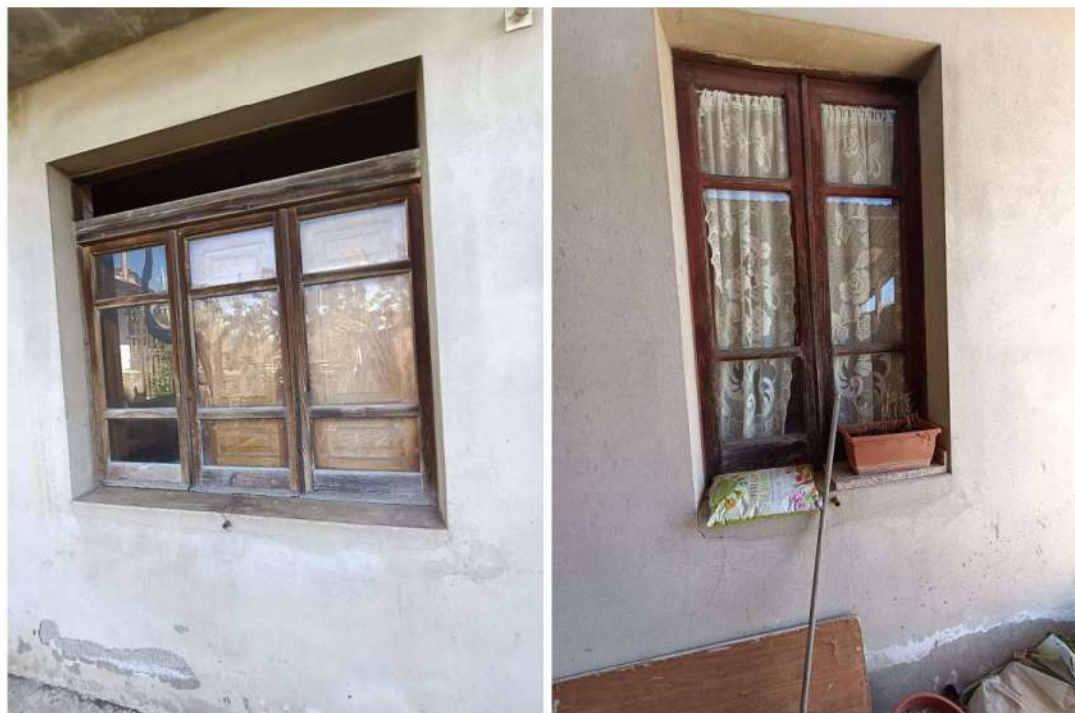
Figura 25: Vista infissi dall'esterno
