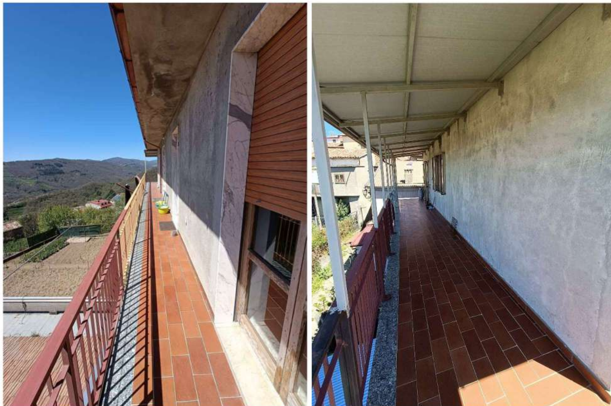
Figura 18: Vista balcone esterno lati sud e ovest
