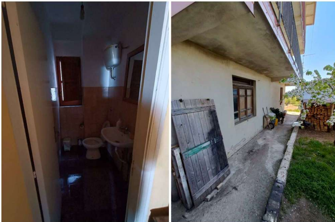
Figura 24: Servizi igienici (a sinistra) e vista dall'esterno (a destra)
