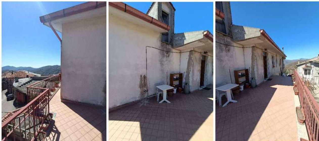
Figura 3: Vista del terrazzo esterno collegato ad ingresso e balcone della cucina
