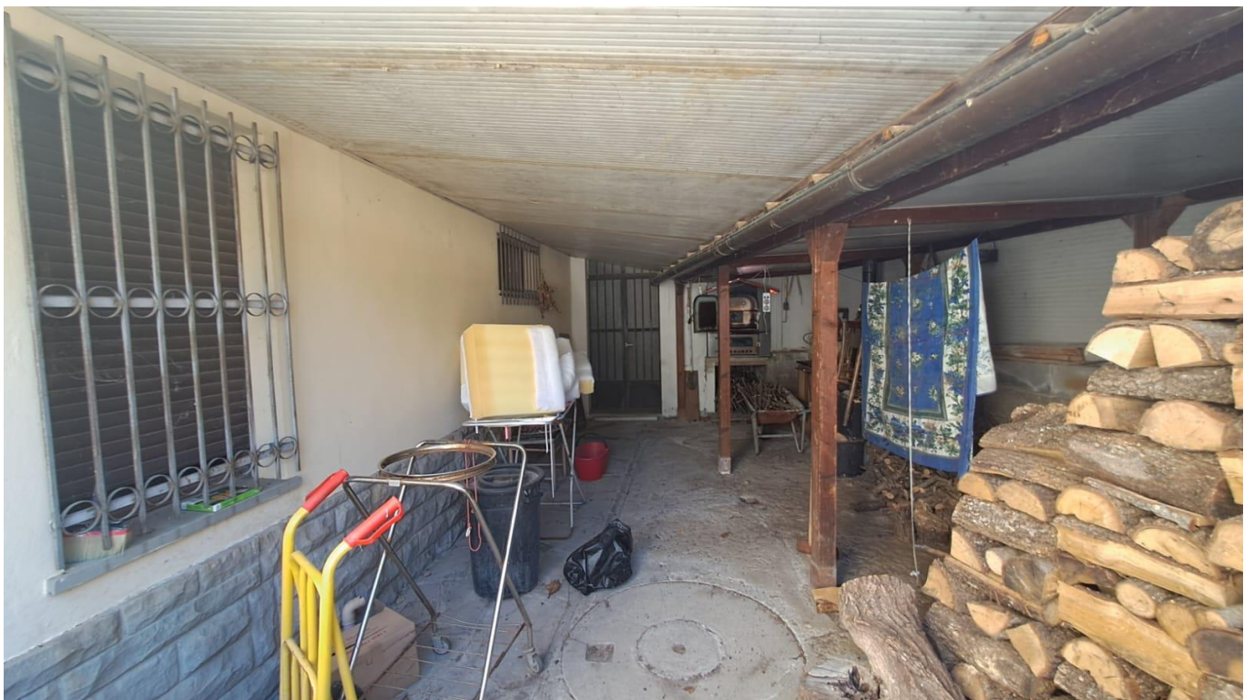
Foto 8 – Manufatti privi di autorizzazione (retro fabbricato)
