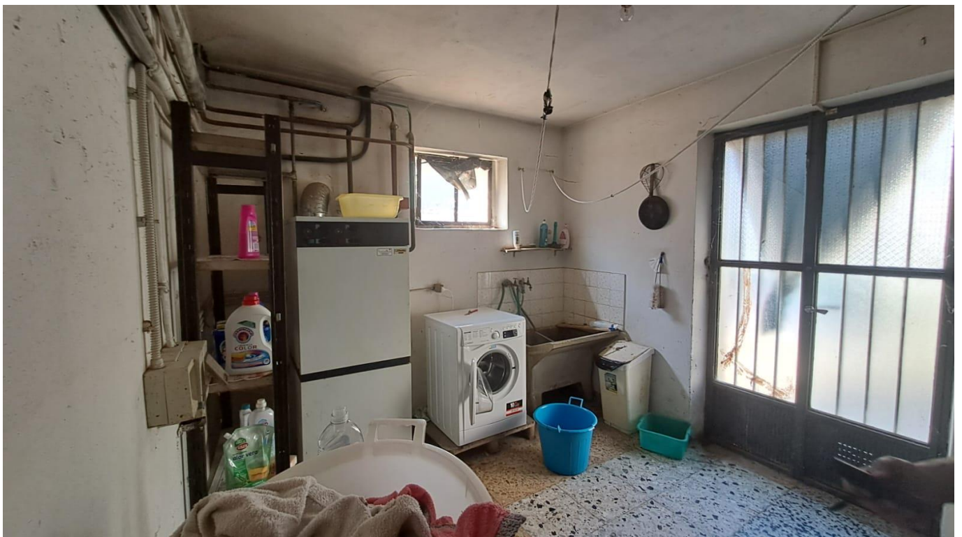
Foto 18 – Magazzino / Locale tecnico
