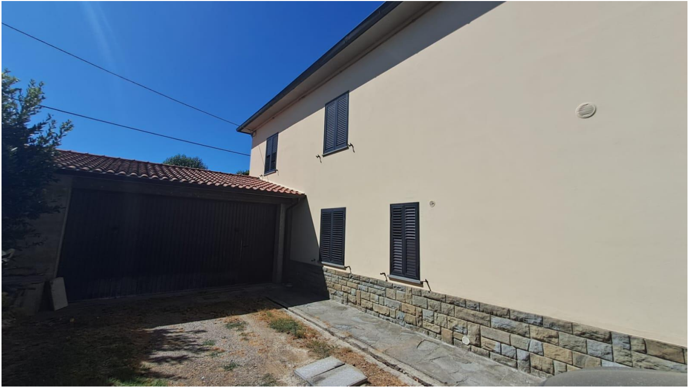
Foto 5 – Lato Est / Garage
