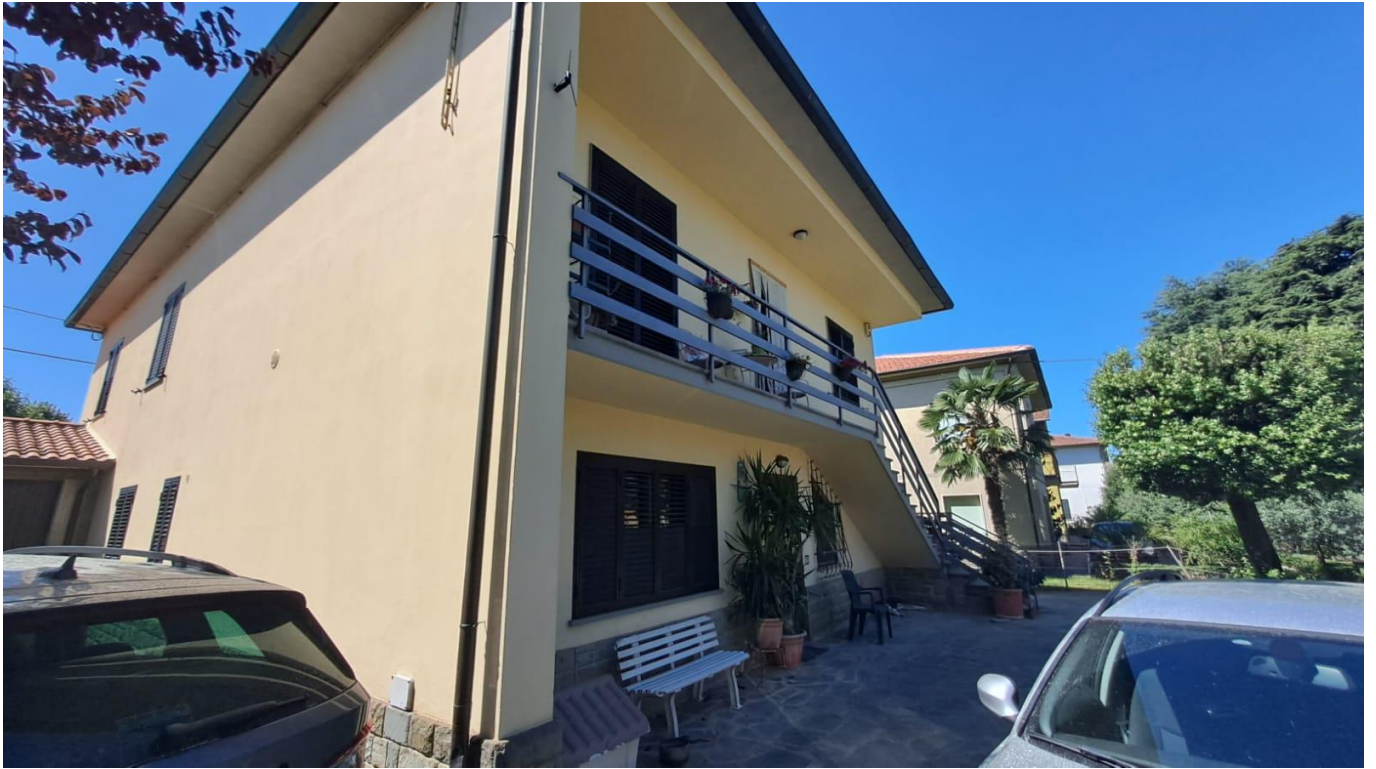
Foto 3 – Lato Nord / Est
