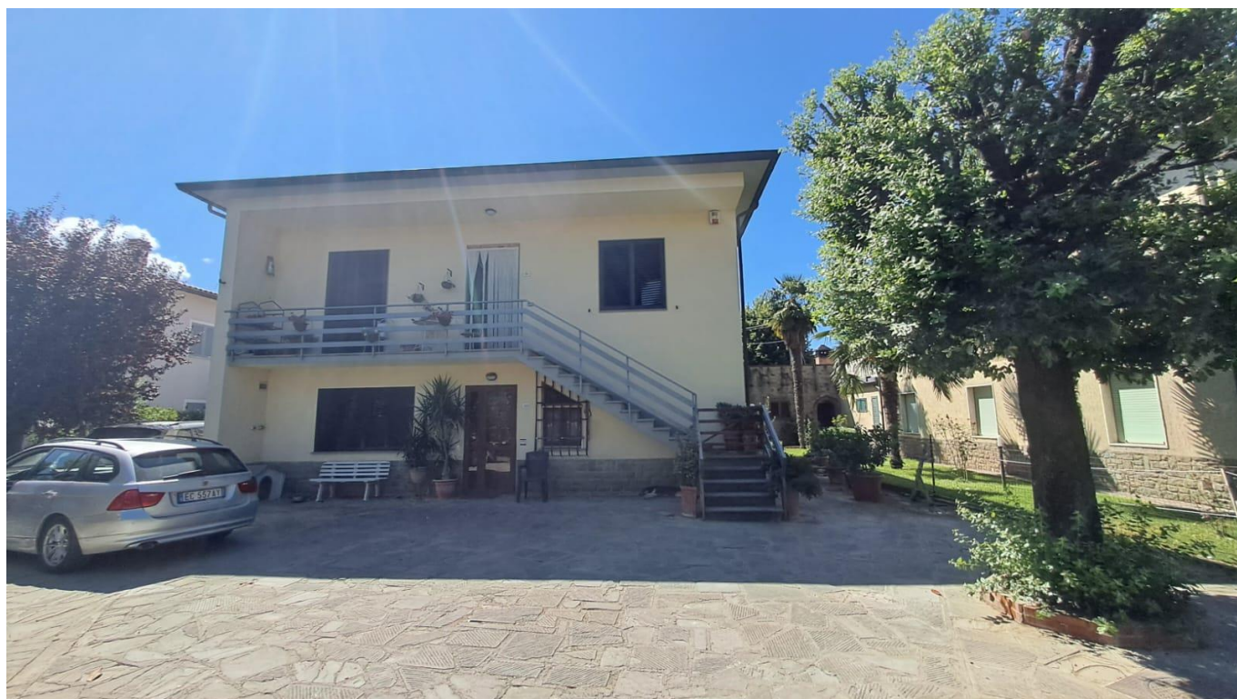
Foto 1 – Lato Nord (Prospetto Principale)
