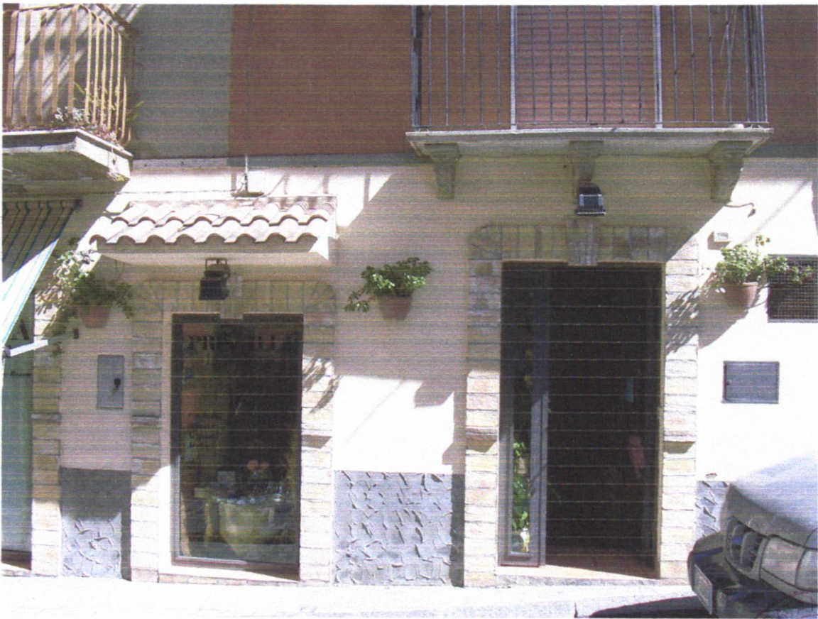
Foto n. 1 - Prospetto principale ed ingresso.
