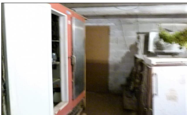
Piano terra - ripostiglio
