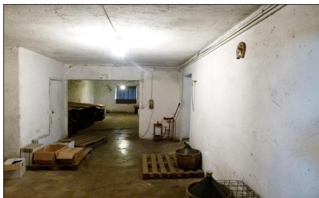
Piano terra - cantina
