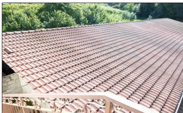
Immibile D – copertura
