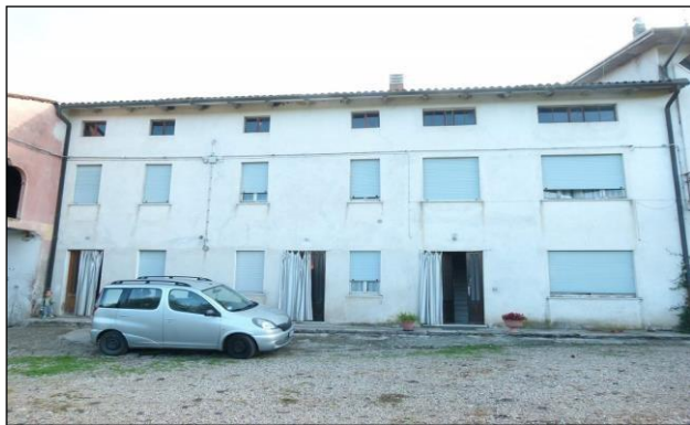
Immobilabile A2 – facciata principale ovest
