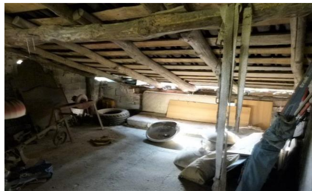
Piano primo soffitta
