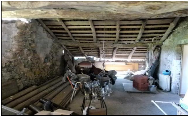
Piano primo soffitta
