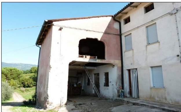
Vista esterna lato sud - accesso dalla corte
