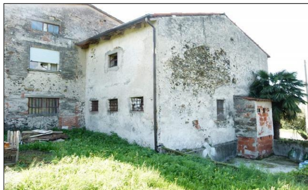
Vista esterna lato nord-est
