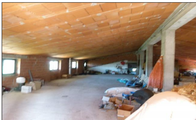
Sottotetto sud - lato ovest
