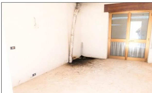
Stanza lato ovest parte pavimentata
