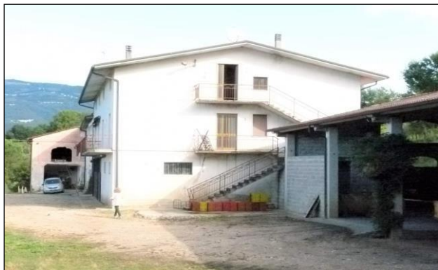
Lato sud -scala di accesso ai piani primo e sottotetto
