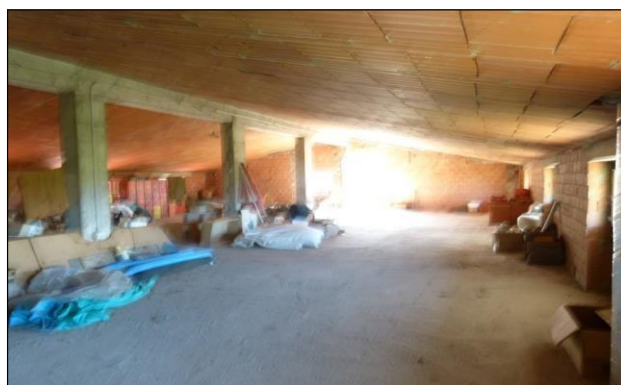
Sottotetto sud - lato ovest
