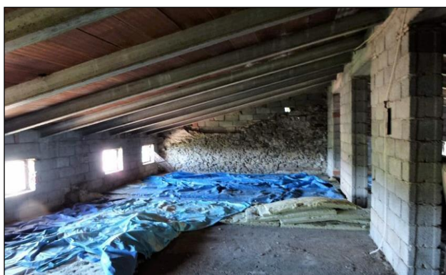
Sottotetto nord - lato ovest
