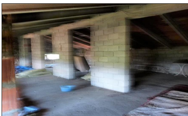
Sottotetto nord - lato ovest
