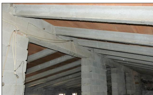
Sottotetto nord - dettaglio
