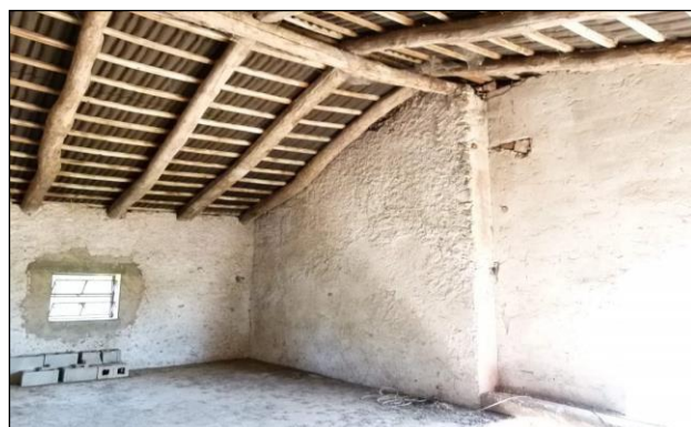
Deposito - fienile p. primo
