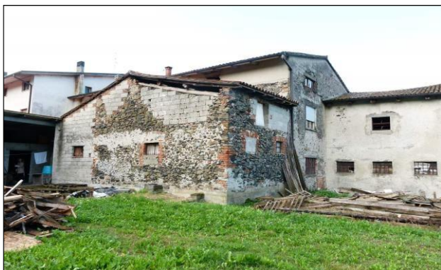
Vista esterna – lati nord ed est
