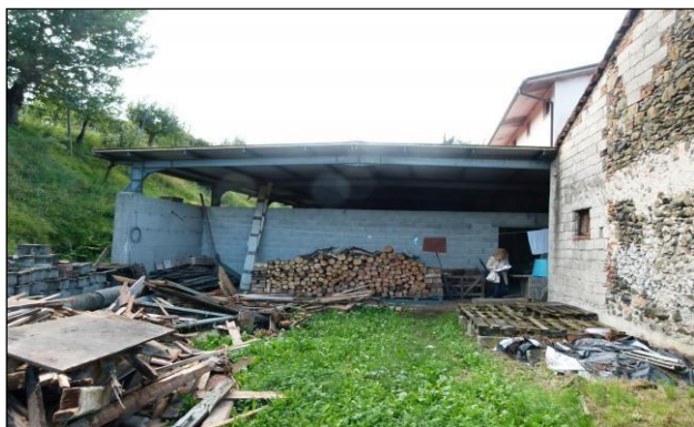
Accesso da lato nord - tettoia
