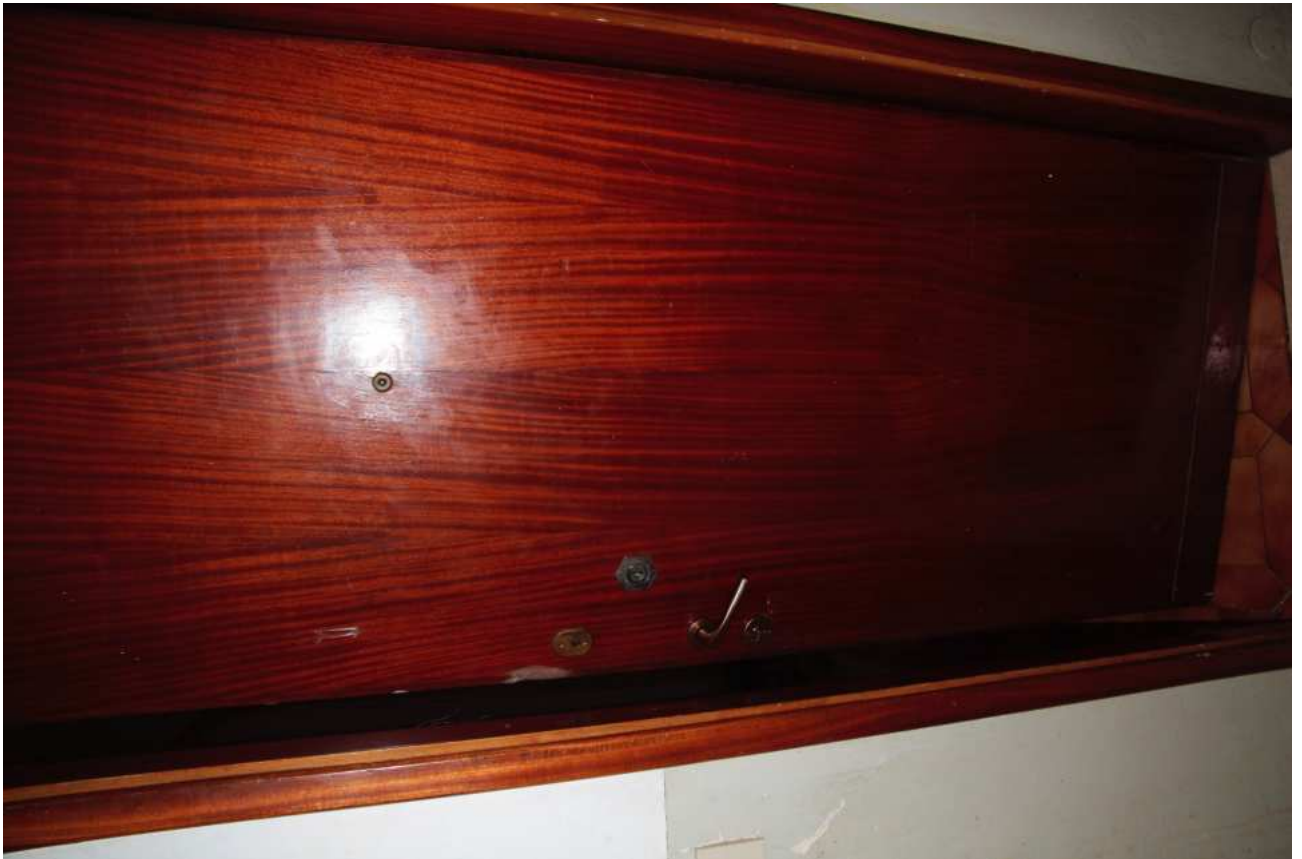
Foto n° 6 - Porta di ingresso all'appartamento
