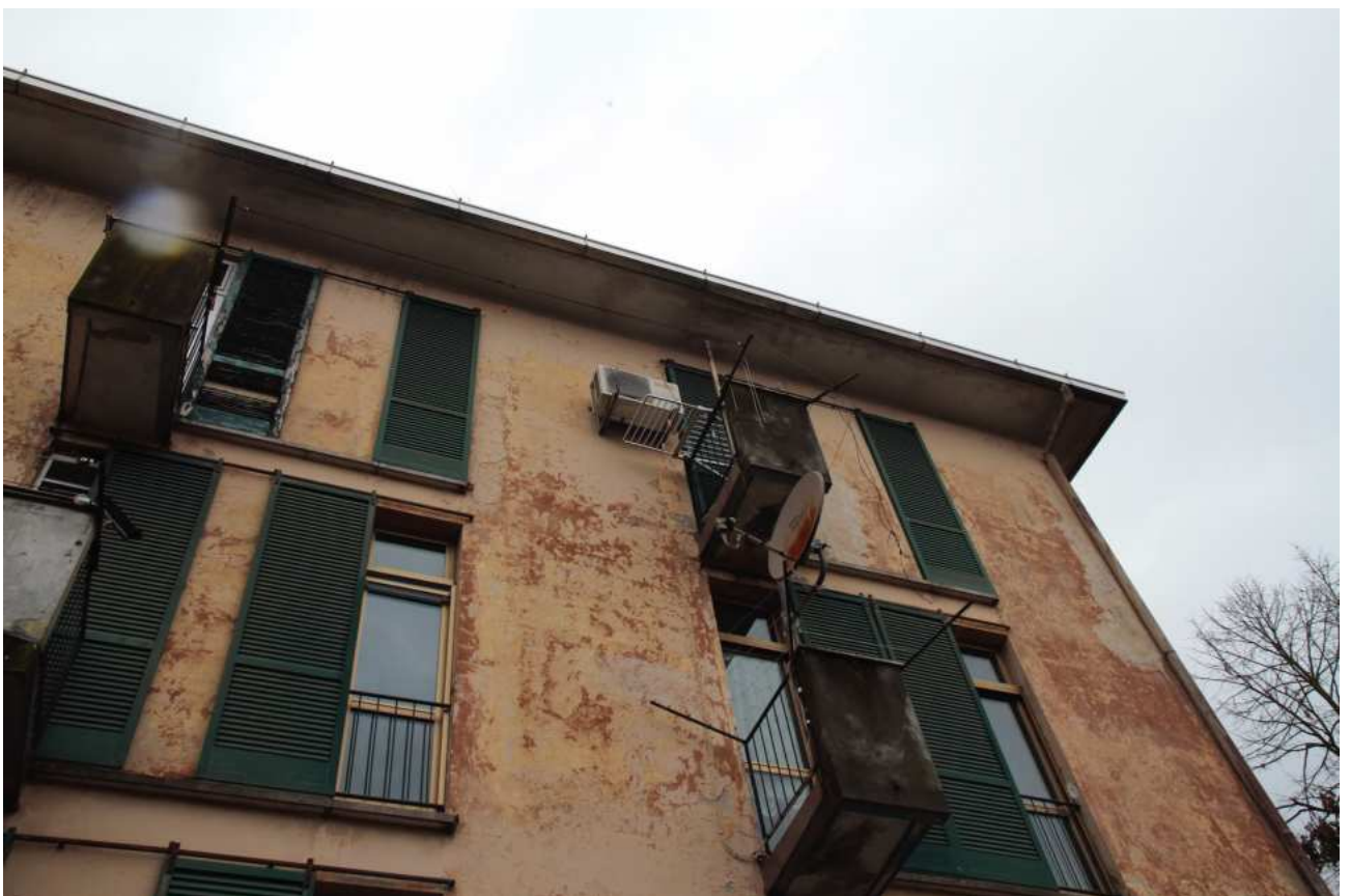
Foto n° 4 - Piano terzo da corte interna
