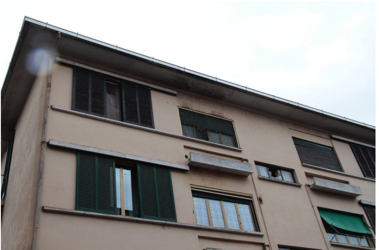
Foto n° 2 - Piano terzo da via Schinelli
