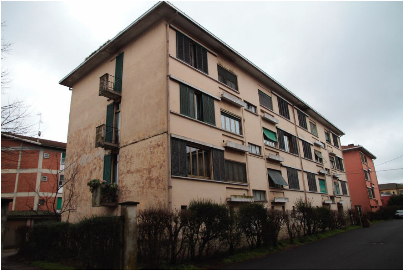
Foto n° 1 - Vista da via Schinelli
