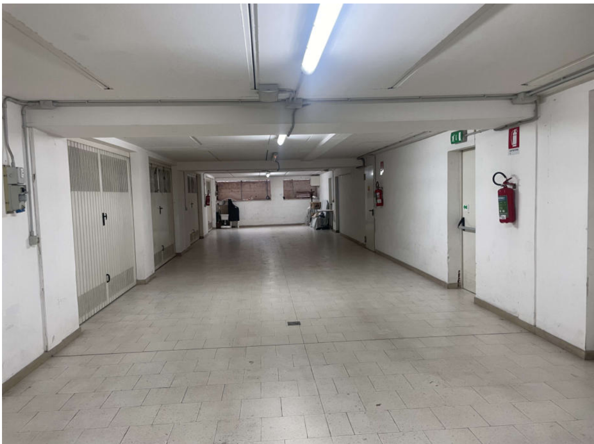
Foto 08 - Corsia garage comune
