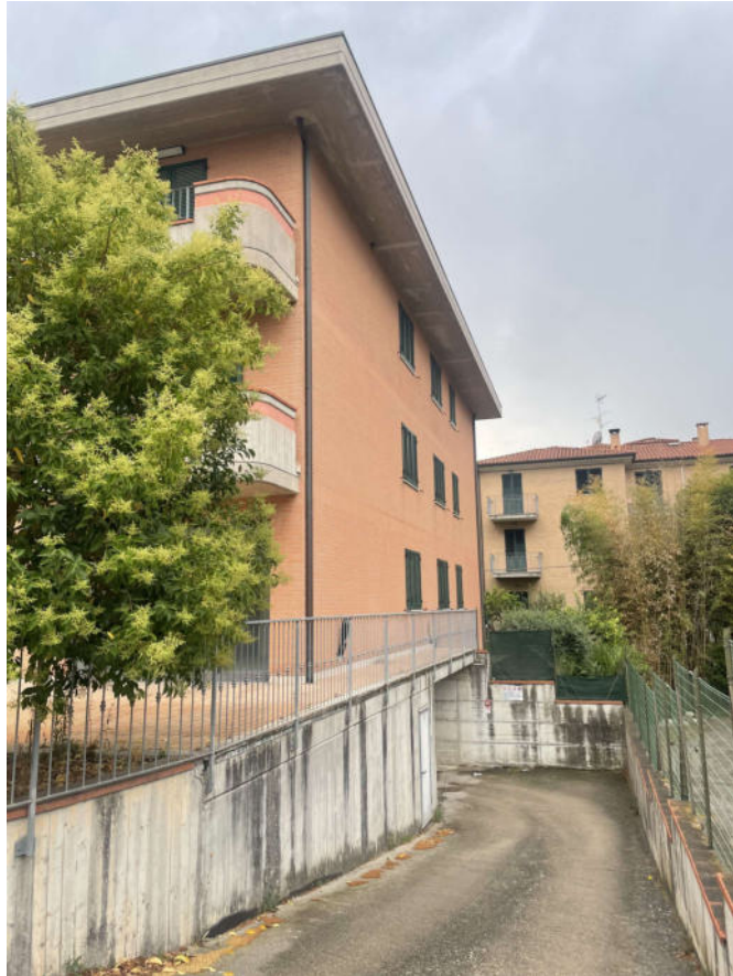
Foto 05 - Rampa accesso garage condominiali
