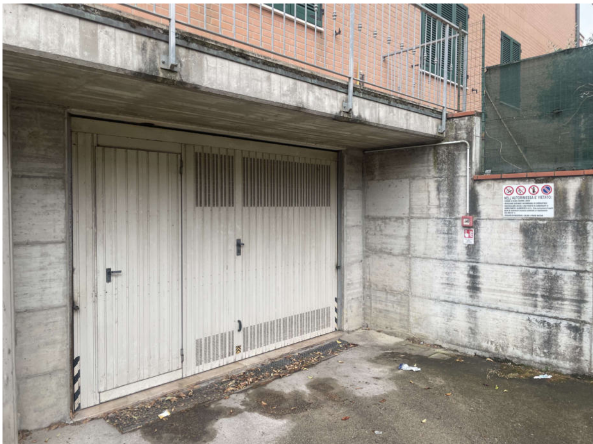
Foto 06 - Porta di accesso garage condominiali
