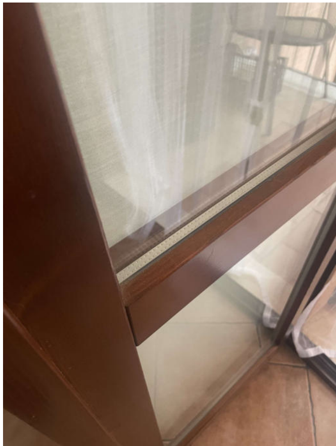
Foto 16 - Particolare infisso con vetrocamera
