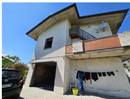
Ingresso Piano terra
