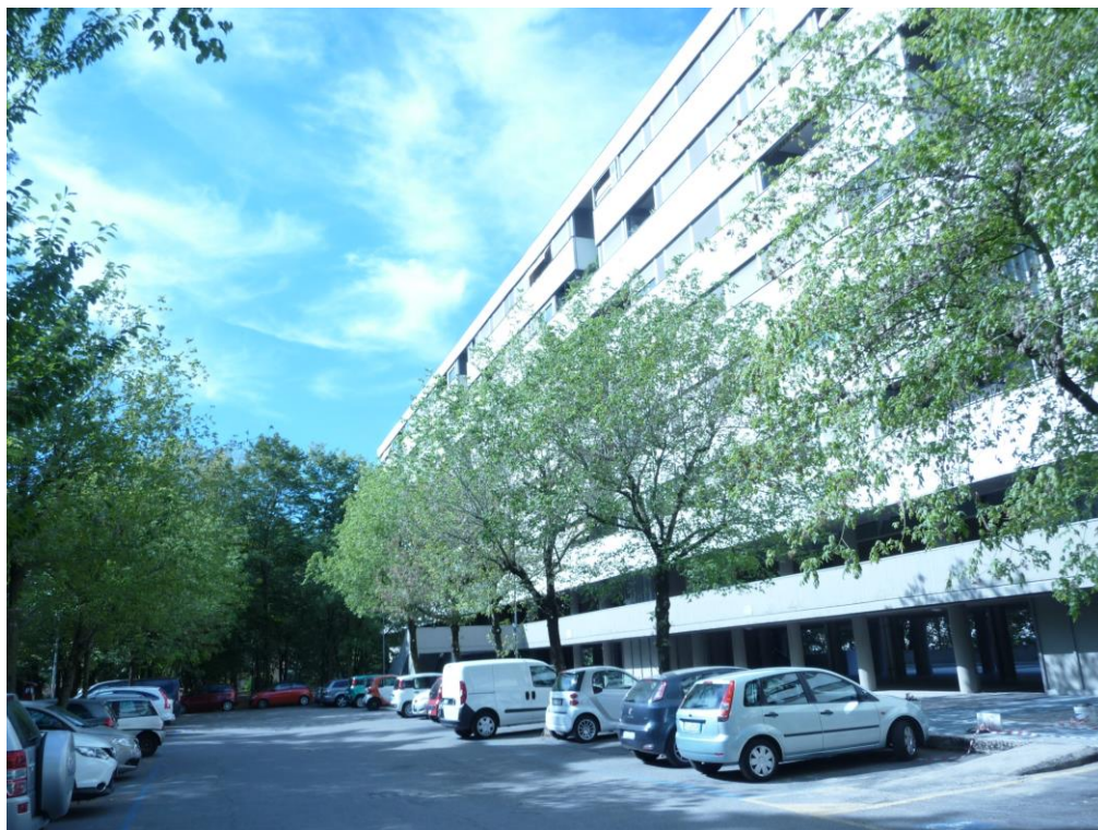
Prospetto principale del complesso “La Caratona” rispetto a via di Corticella
