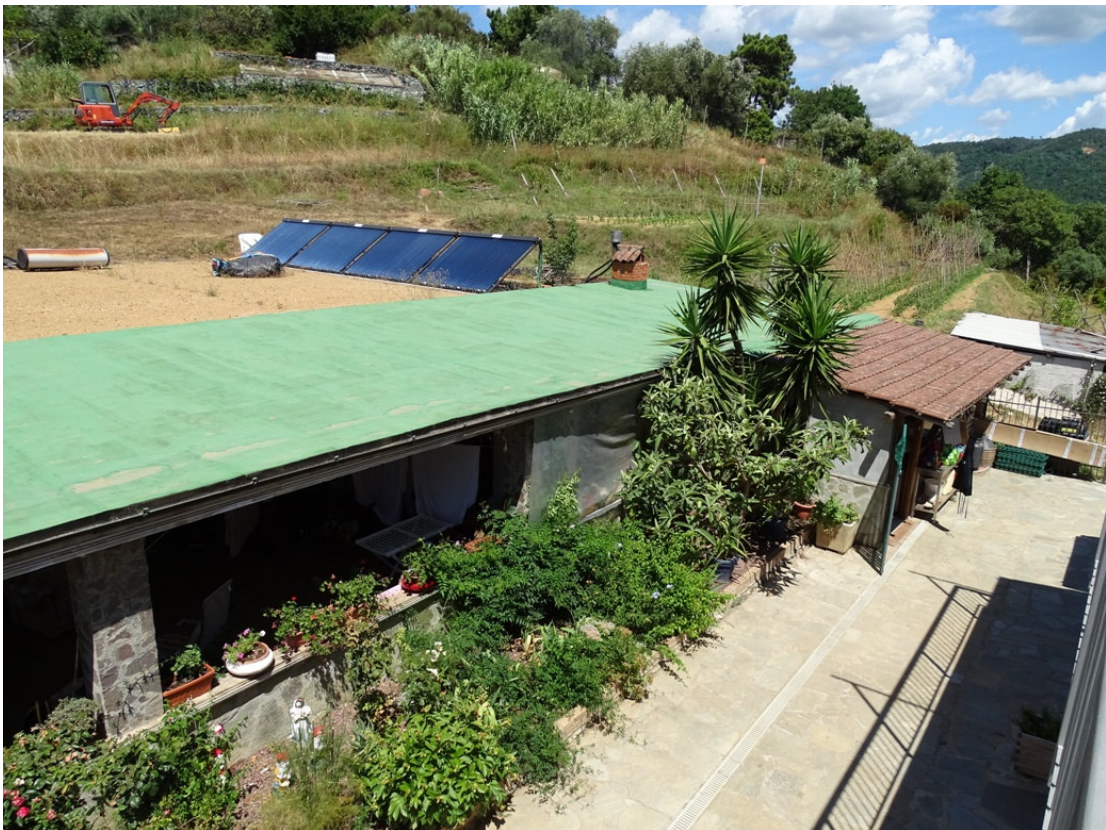
Particolari esterni del fabbricato Corpo A – deposito attrezzi seminterrato
