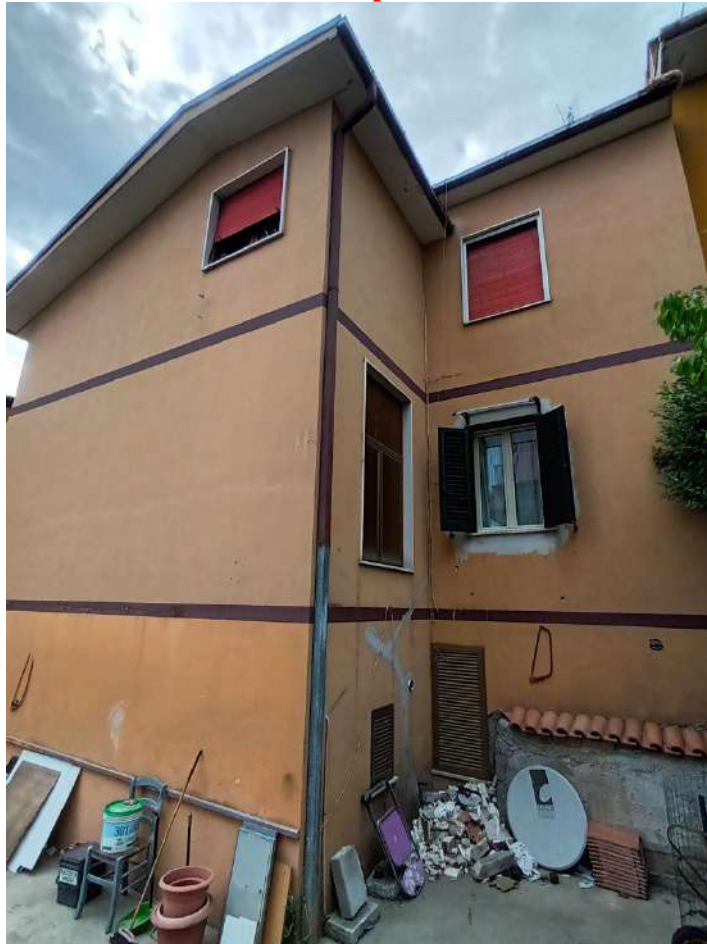
Foto n. 6 – Ancora lato posteriore dell'edificio
