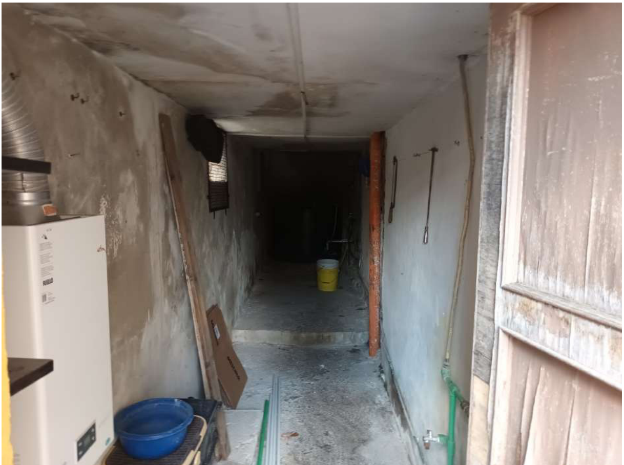
Foto n. 30 – Locale di servizio comune
