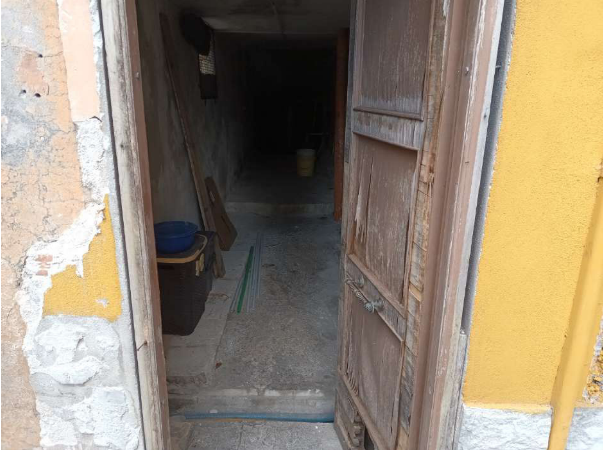
Foto n. 29 – Porta del locale di servizio comune
