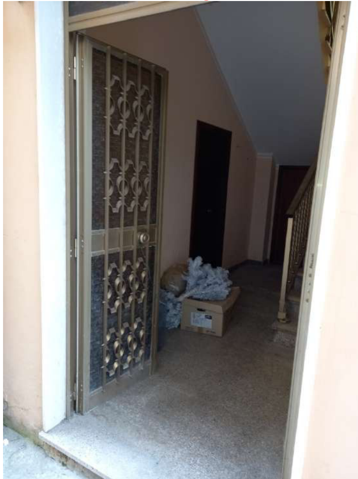
Foto n. 7 – Porta di ingresso alla scala
