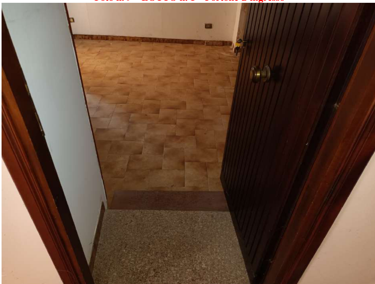
Foto n. 9 – LOTTO n. 1 – Portone d'ingresso
