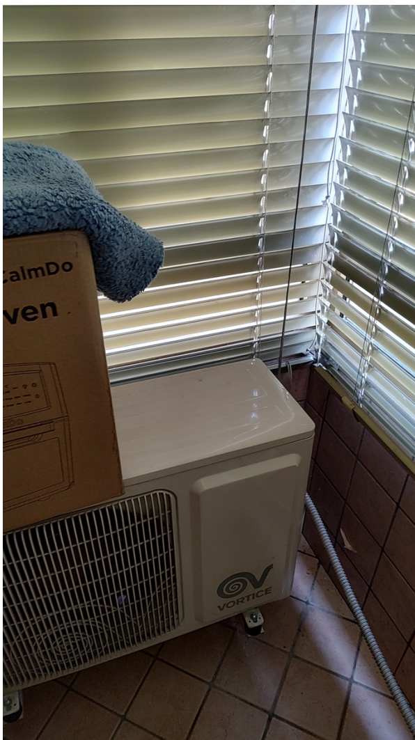
Foto 13 – veranda della camera matrimoniale
