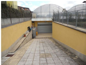
Foto 2 - Rampa di ingresso
