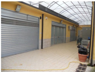
Foto 3 - Prospetto principale ingresso
