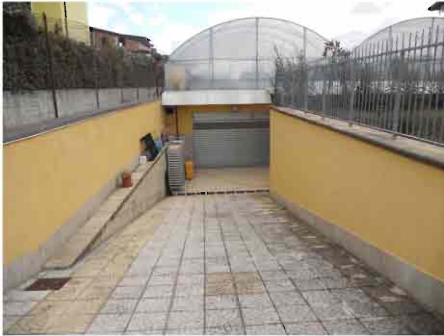
Foto 2 - Rampa di ingresso
