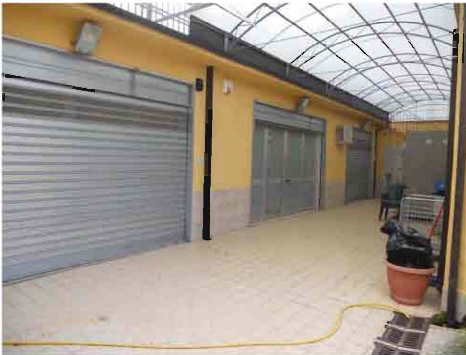
Foto 3 - Prospetto principale ingresso
